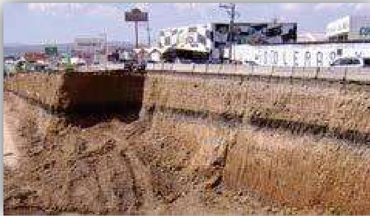
Figura 44. Sedimentos fluvio-lacustres, que afloran en la excavación que se realizó para construir el distribuidor vial de la salida a Charo, al oriente de Morelia.
