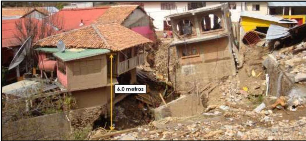
Figura 91. Marca de lodo de seis metros de altura en una vivienda ubicada en la zona de conflicto 3.
