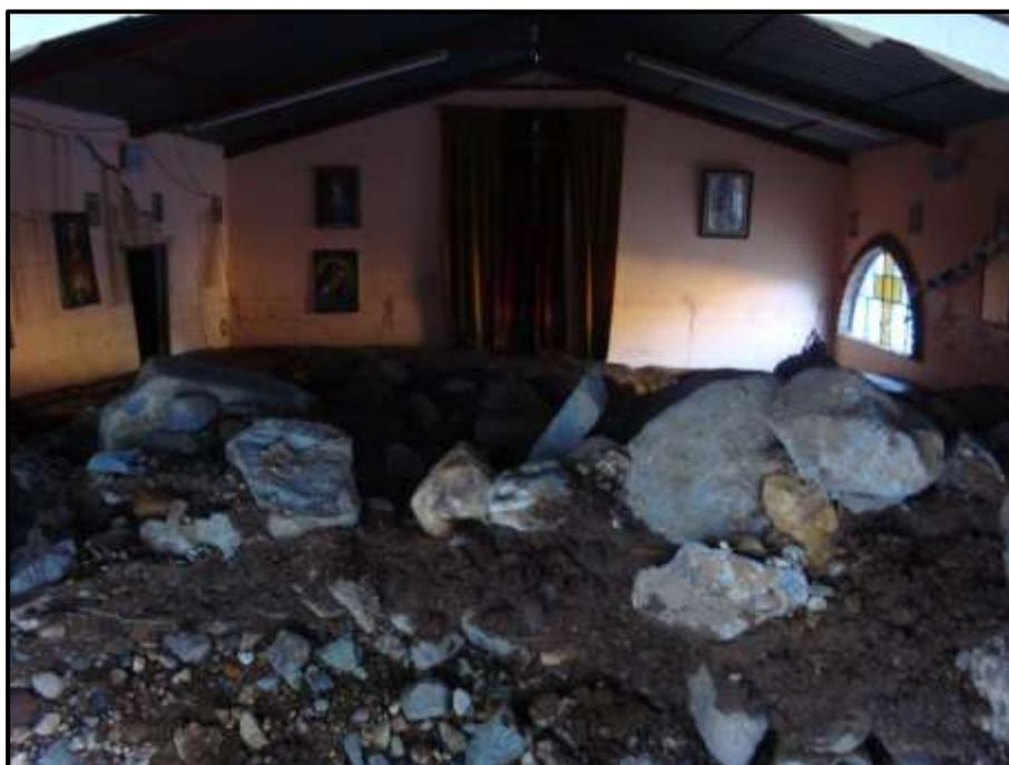
Figura 94. Los bloques de roca, detritos y sedimentos atravesaron las paredes de la iglesia ubicada en la ZC 2 para depositarse en el interior de esta.
