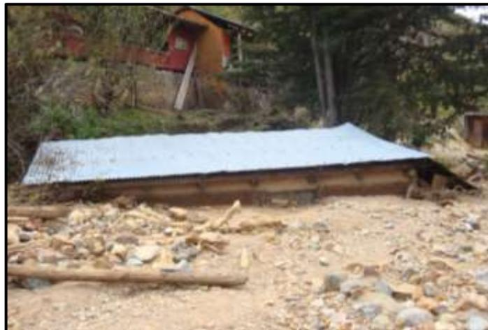
Figura 93. Una vivienda ubicada sobre la margen del río San Pedro en la zona de conflicto 1, quedó totalmente sepultada por el depósito del flujo de detritos.
