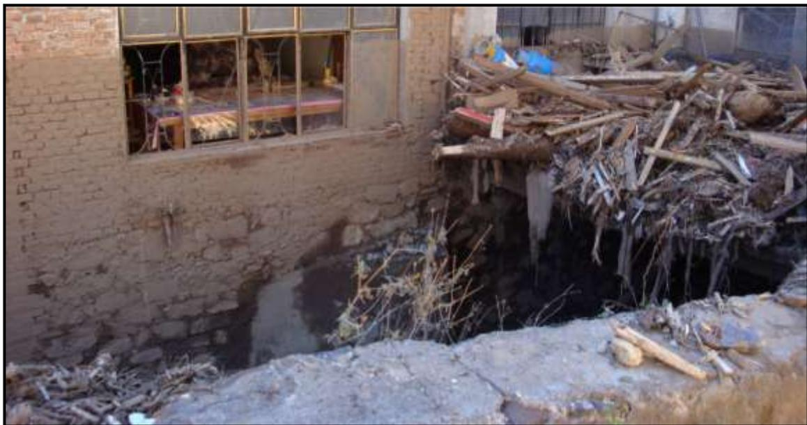
Figura 108. Acumulación de madera, basura y sedimentos en una zona de túnel del río Puercos, esto generó represas que motivaron el desbordamiento del cauce.
