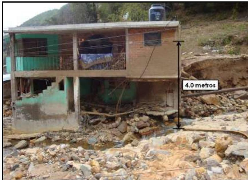
Figura 90. Marca de lodo con altura de cuatro metros en una vivienda ubicada en la ZC 1.
