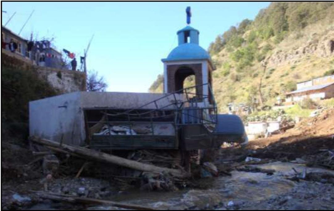
Figura 107. Destrucción total de una capilla ubicada en la margen derecha del río Catingón. Fue afectada por los flujos de detritos provenientes del cauce y el deslizamiento del Cerro Guadalupe.
