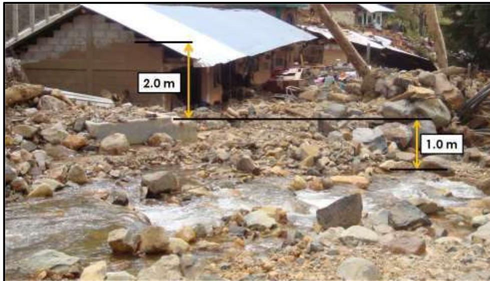
Figura 89. Fotografía donde se observa el nivel que alcanzó el flujo de lodo en una zona del cauce 100 m aguas arriba de la ZC 1.
