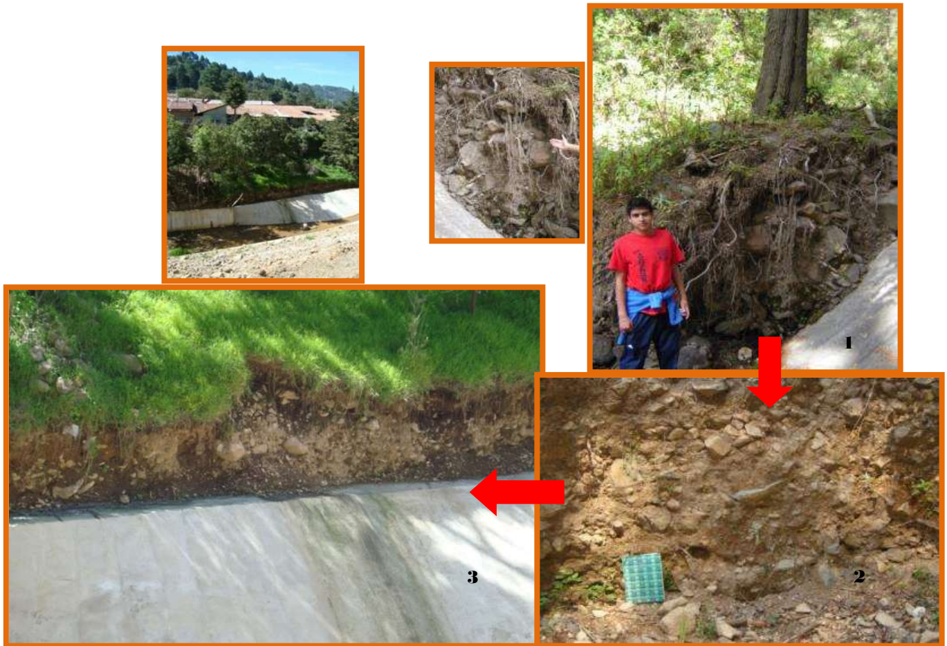
Figura 11 Detritos debajo de la capa vegetal y de las casas al margen del río San Pedro.
