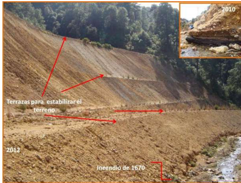
Figura 71 Obras de saneamiento en Angangueo Michoacán
