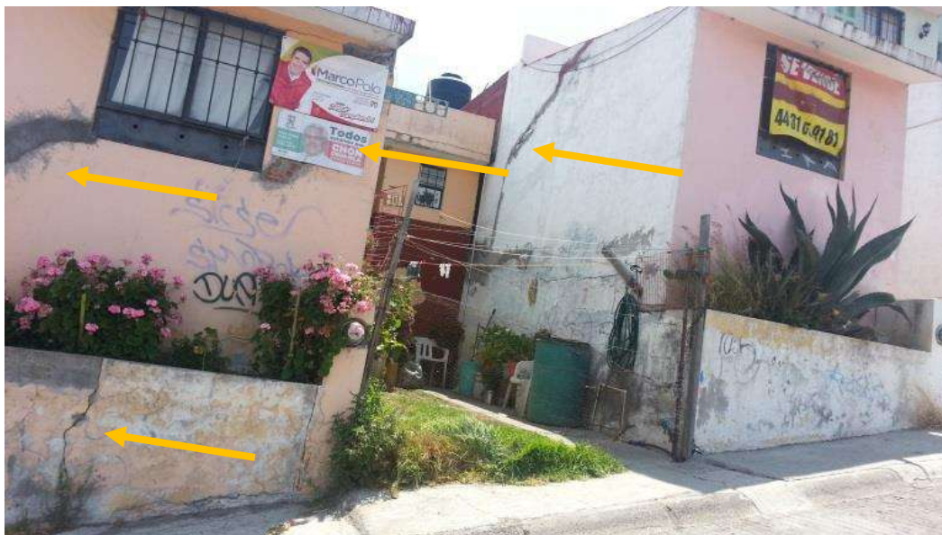
Figura 47: Viviendas ubicadas en zona con pendientes pronunciadas.
