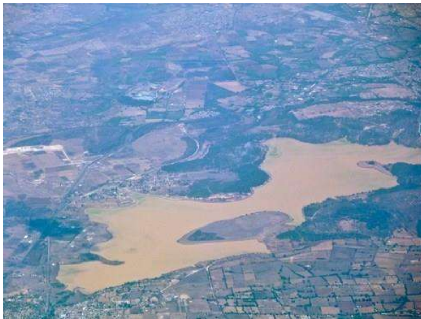
Figura 52: Presa Cointzion (Fuente: http://periodismoaudaz.com.mx/?p=26344 ).
