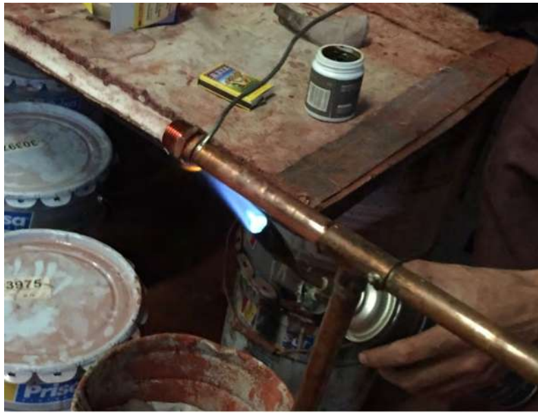
Figura 5.1. Proceso de soldadura de los tubos.
