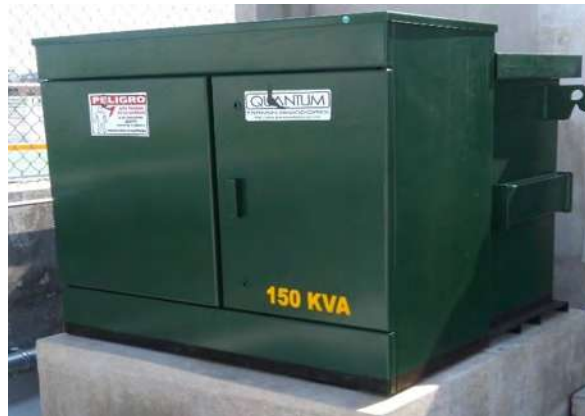
Figura 32. Transformador 440/13200 kV.
