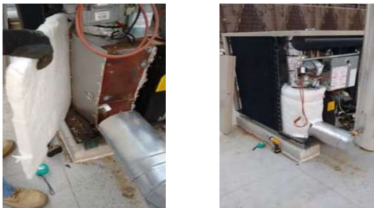
Figura 21. Colocación de aislante térmico en el generador.
