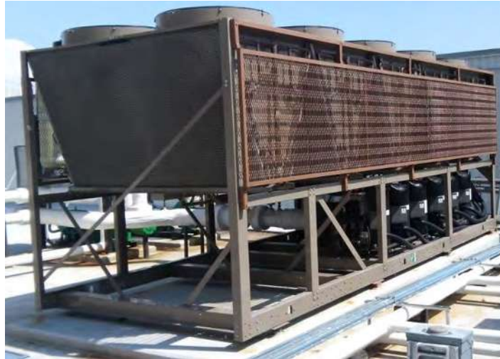
Figura 26. Enfriador de agua YLAA 0170SE.
