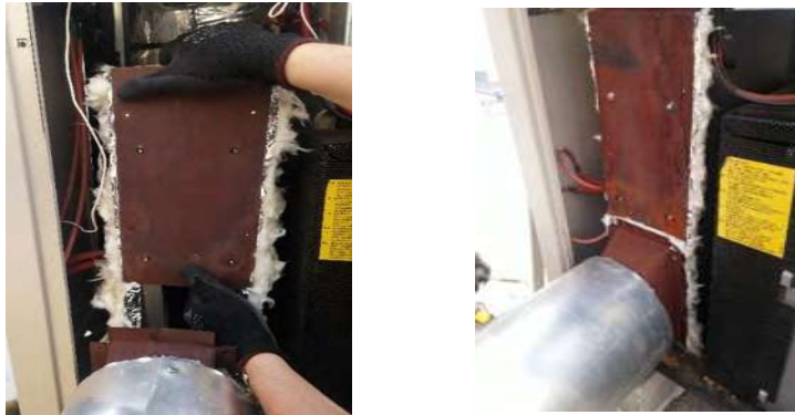
Figura 19. Colocación de empaque térmico en el generador.
