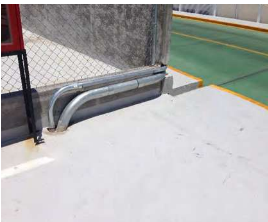
Figura 33. Línea de media tensión
