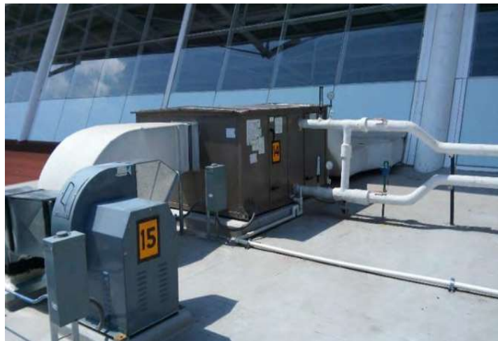
Figura 27. Manejadora de aire.
