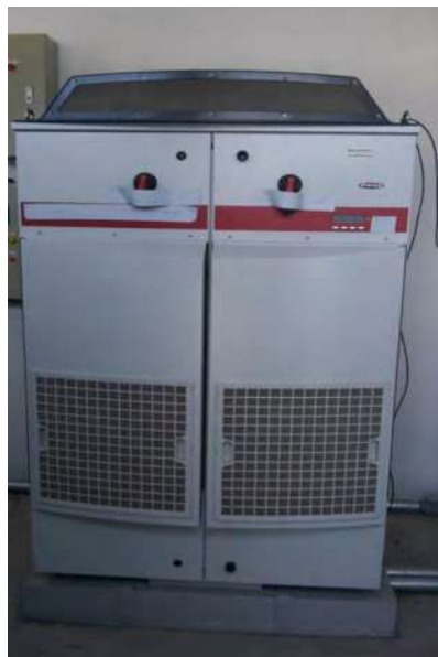
Figura 23. Inversor Fronius CL 33.3 Delta.
