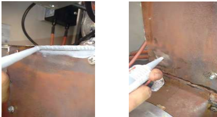
Figura 20. Sellado de fugas en el generador.
