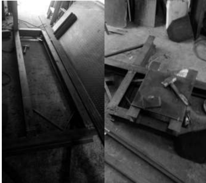
Figura 58. Construcción de la base y el banco.
