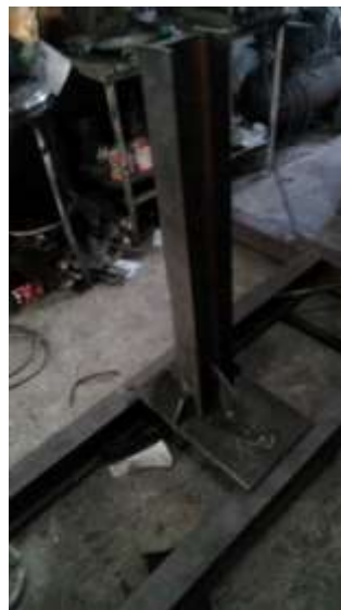
Figura 59. Soldadura de esquineras.
