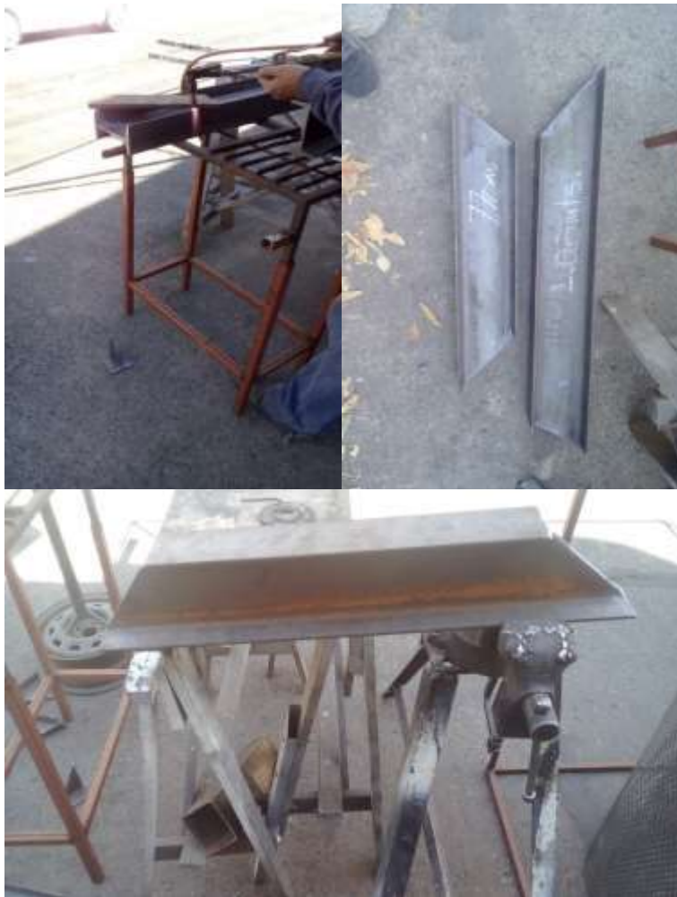
Figura 53. Corte de las vigas en Angulo.
