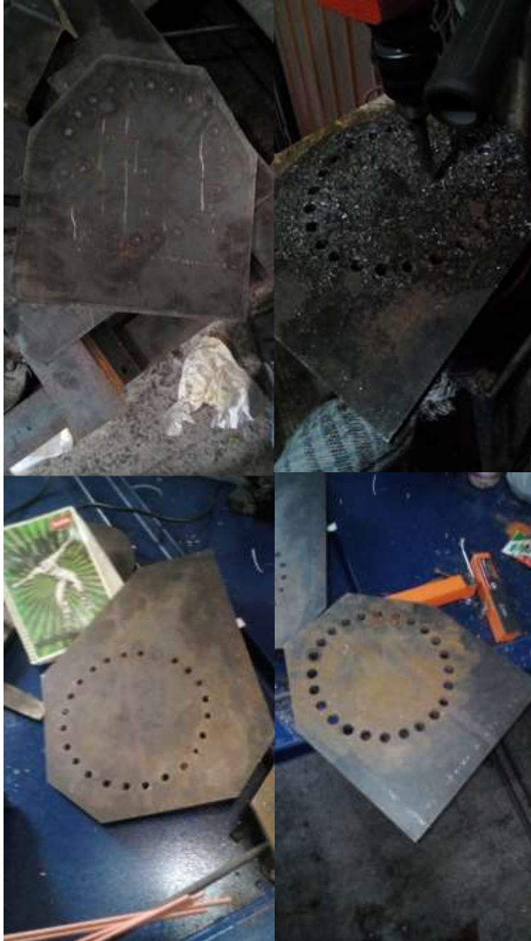
Figura 54. Marcado y perforación del cabezal.
