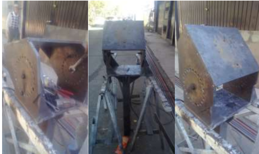
Figura 60. Construcción del cabezal.
