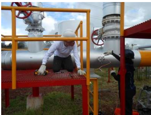
Fotografías J Se abre lentamente la válvula y se deja fluir el gas.
