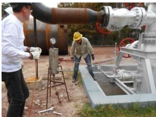
Fotografías M Se conecta el separador portátil y se purga.
