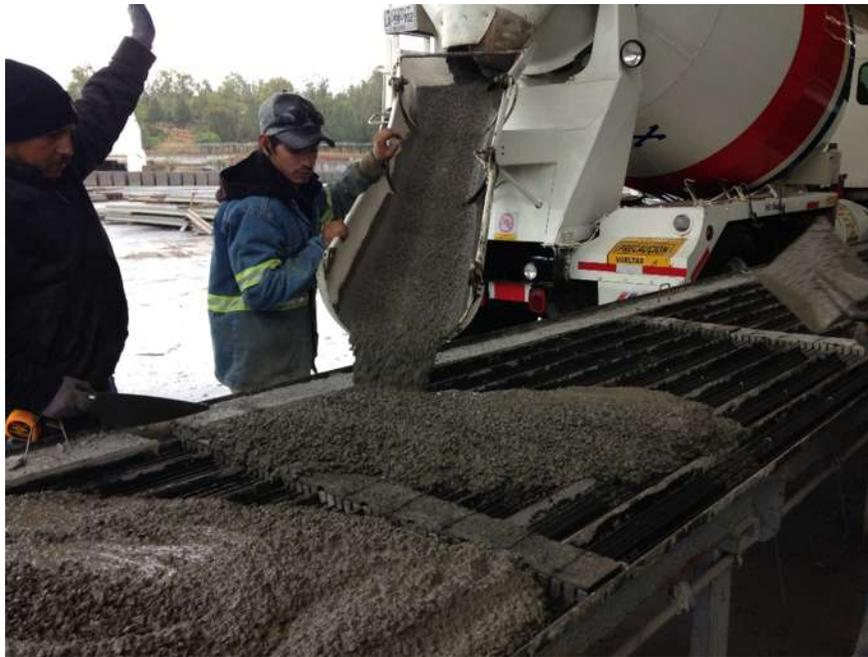
*Figura 5. Colado de elemento presforzado.*
