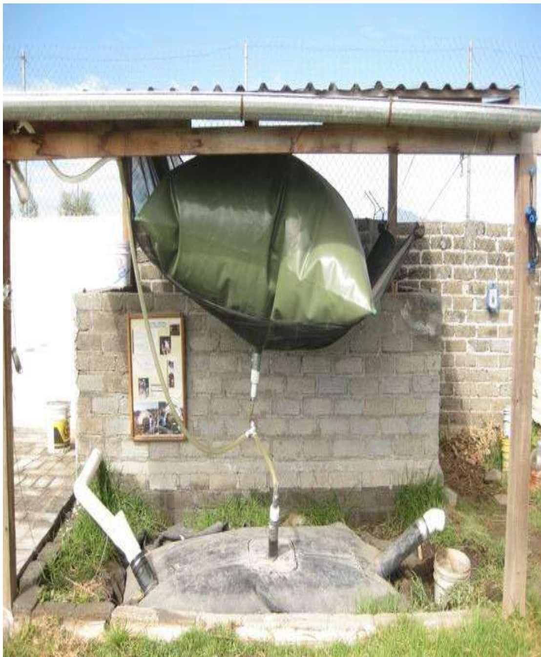
Figura 3.3 Modelo de un Sistema Biobolsa de geomembrana para pequeñas granjas ( figura de vista a lo largo)
