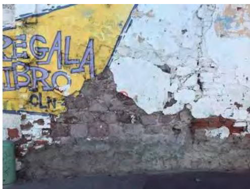
Fig. 19. Acercamiento a uno de los muros de la fachada de la casa de la Vega. Construcción que data de la década de 1790, se puede apreciar el uso de mampostería irregular. Fotografía tomada por la autora. [21/10/2020]
