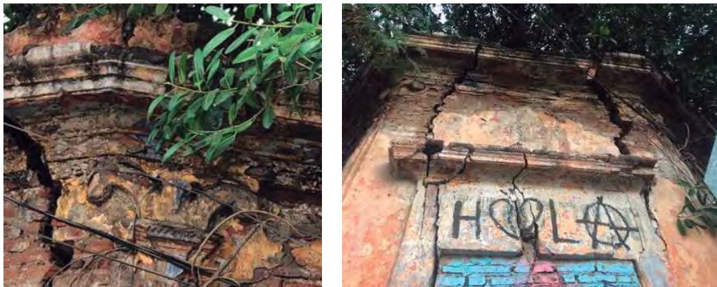
Fig. 46. Fotografías de detalle de pilastra y cornisa. Fotografía por la autora [21/10/2020].
