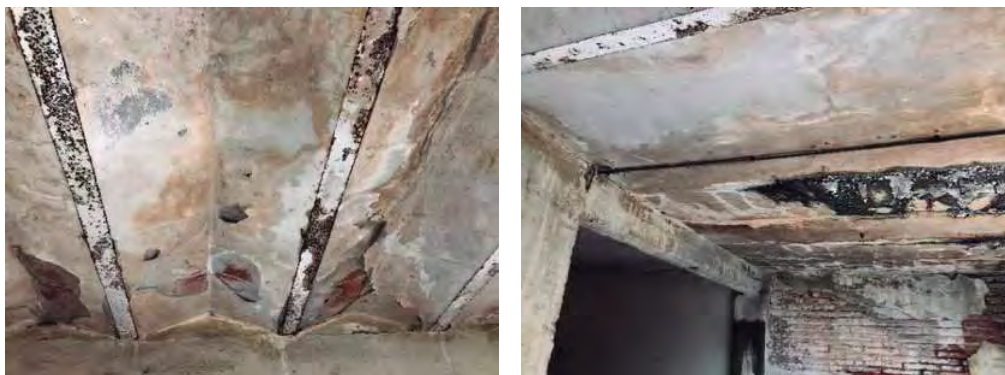
Fig. 60 Fotografías de la cubierta de perfiles de acero y tabiques. Fotografías tomadas en el sitio [09/11/2020].
