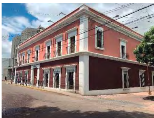
Fig. 41 Contexto inmediato al inmueble, vista noroeste. Fotografía tomada en sitio por la autora [31/08/2020]
