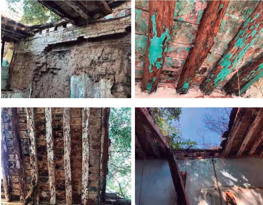
Fig. 59 Fotografías de la cubierta de vigas de madera y soleras de barro. Fotografías tomadas en el sitio. [09/11/2020].
