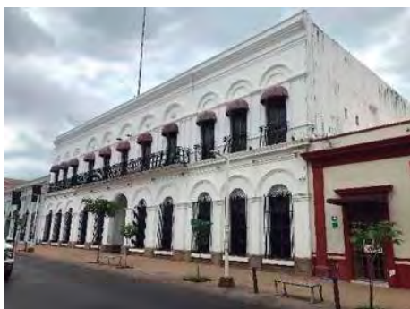
Fig. 21. La Tercena (actualmente Archivo Histórico), edificio del siglo XIX. Fotografía tomada en sitio por la autora. [21/10/2020]
