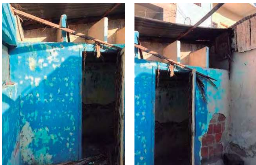
Fig. 62 Imágenes de la cubierta formada por polines de madera y lamina. Fotografías tomadas en el sitio [09/11/2020].
