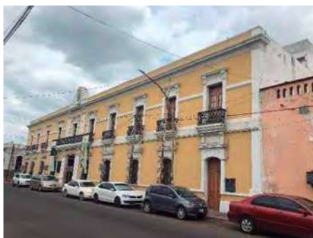
Fig. 22. Actual Museo de Arte de Sinaloa debió construirse alrededor de los años 30 del siglo XIX. Puede observarse una altura considerable en su paramento. Fotografía tomada en sitio por la autora. [21/10/2020]
