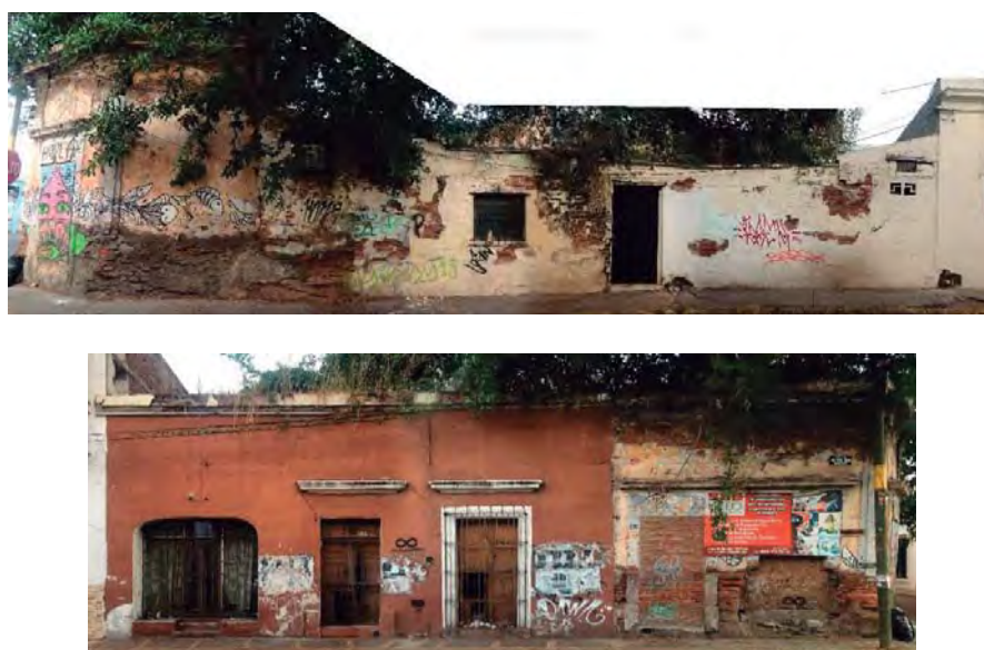
Fig. 7 Fotografías de la fachada lateral y frontal del inmueble. Tomadas en sitio por la autora [09/11/2020]
