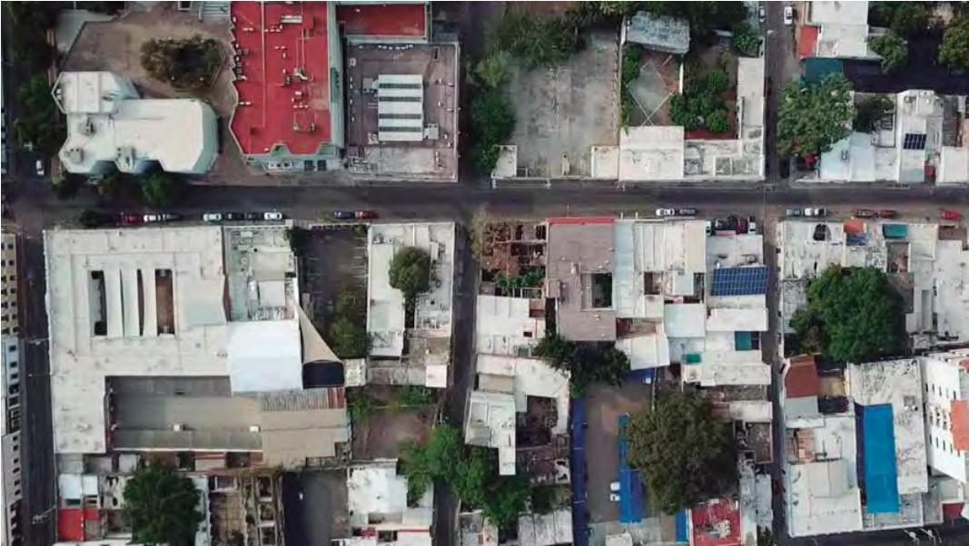
Fig. 51. Fotografía aérea mostrando las vialidades y los inmuebles colindantes. Fotografía por la autora [04/07/2021]
