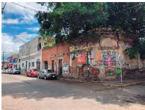
Fig. 36 Contexto inmediato al inmueble, vista este. Fotografía tomada en sitio por la autora [31/08/2020]
