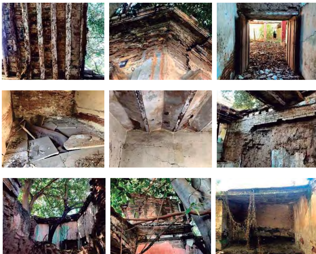
Fig. 6 Fotografías tomadas al interior y exterior del inmueble. Tomadas en sitio por la autora [09/11/2020].
