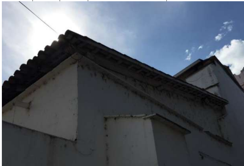
Figura 56. Cubierta inclinada a un agua en bautisterio. Autor GTN.
