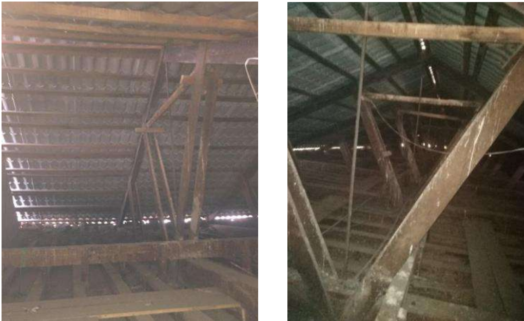
Figura 53. Cubierta de armadura de madera en nave principal
