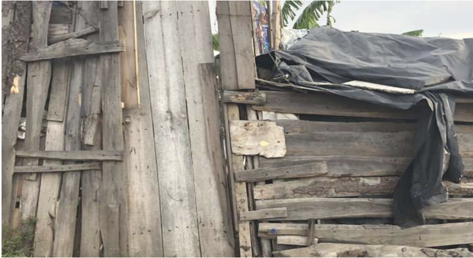
Al lado I 53 Fo- Imagen Brisas del Sur. tografía: Autoría propia 2018.
