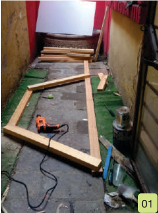
Trazo y armado de primera mitad de hexágono
