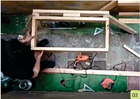
Armado de pieza superior de unión
