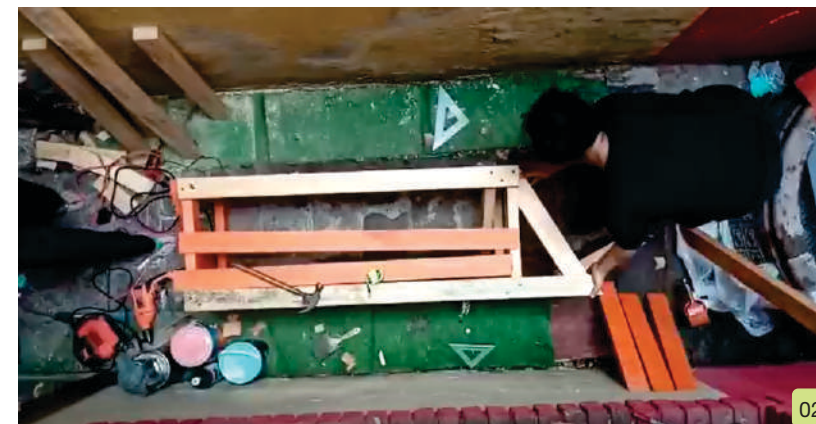
Armado de chafán y estructura principal en banca
