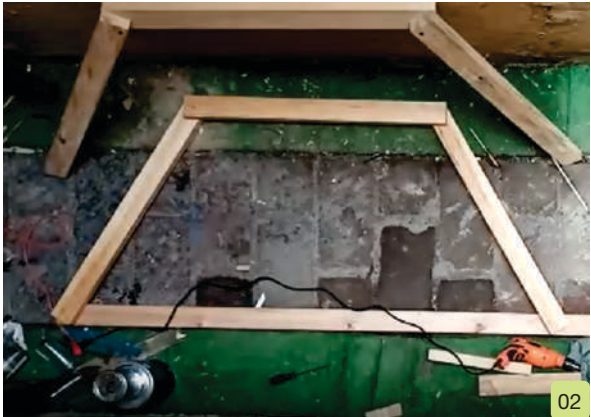
Trazo y armado de primera mitad de hexágono
