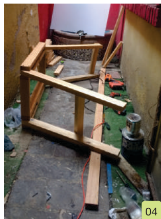
Ensamblado de las dos caras
