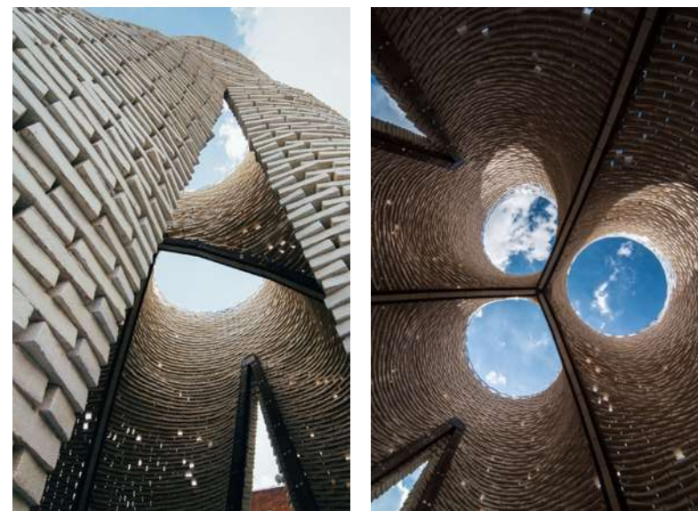
Fig. 27 y 28 Pabellón Hy-Fi
