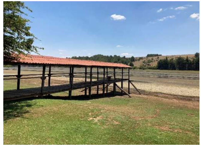
Imagen 3.3 Vista de muelle zona sur, temporada de secas
