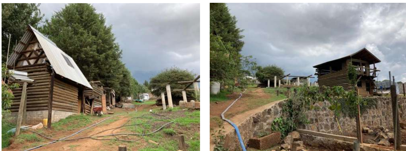
Imagen 5.1 Cabañas en construcción
