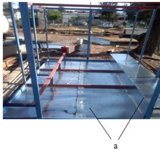
Figura 11. Preparación de área de trabajo de la cámara de termotratamiento. a) lámina galvanizada calibre 26 y delimitación de áreas de trabajo.
