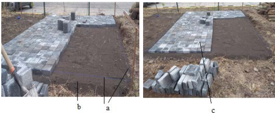
Figura 18. Preparación del espacio de colocación de la cámara de termotratamiento. a) hilos de para nivelación de piso, arena y adoquín, b) arena nivelada, c) colocación del adoquín.
