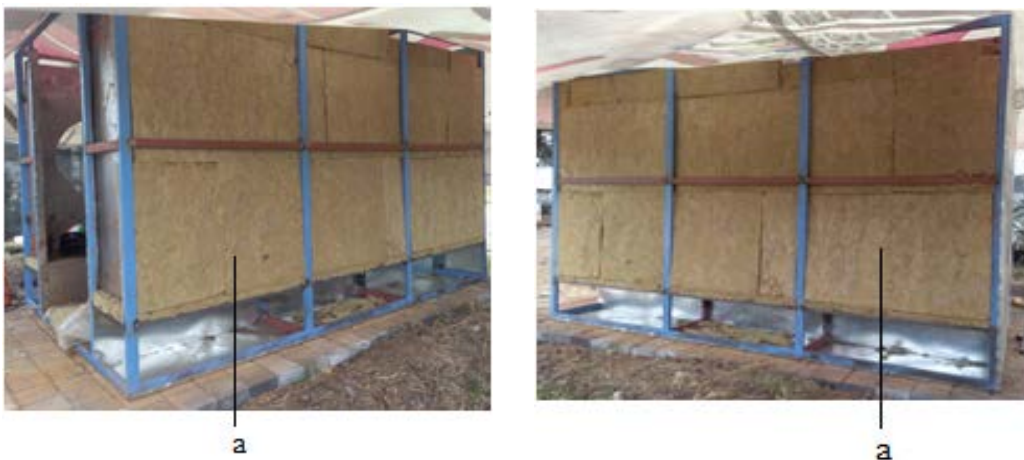
Figura 13. Aislante térmico de la cámara de termotratamiento. a) colocación del recubrimiento de lana mineral en las paredes de la estufa.
