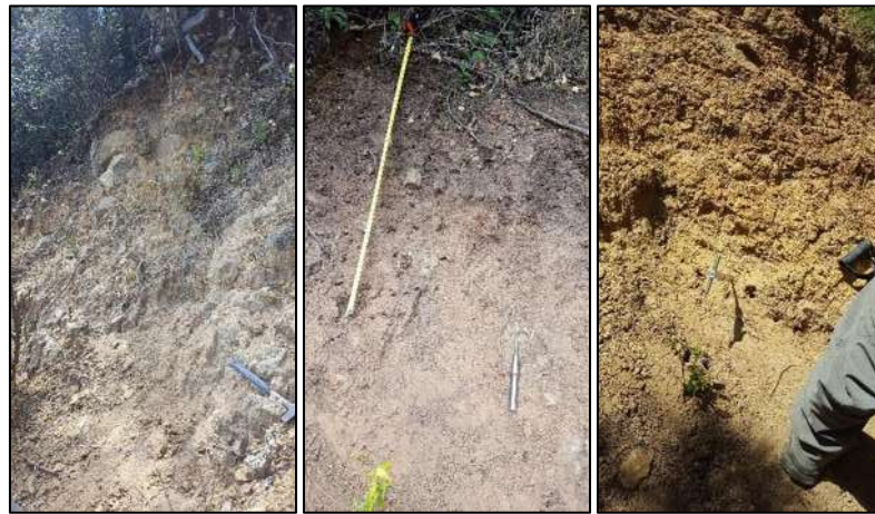
Figura 66. Se presenta un depósito coluvial, un depósito de caída de lapilli; lo cuales fueron los materiales que se movilizaron sobre la superficie de la roca dacita alterada hidrotermalmente durante el deslizamiento del 2010.
