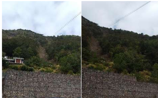
Figura 24. Vista de la ladera del Cerro Guadalupe sobre la zona del deslizamiento donde se construyó un muro de contención a base de gaviones; se puede observar aun viviendas habitadas en la zona.
