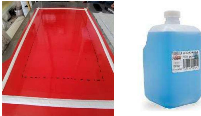
Figura 3 11 Delimitación de zona de infusión y aplicación de película desmoldante
