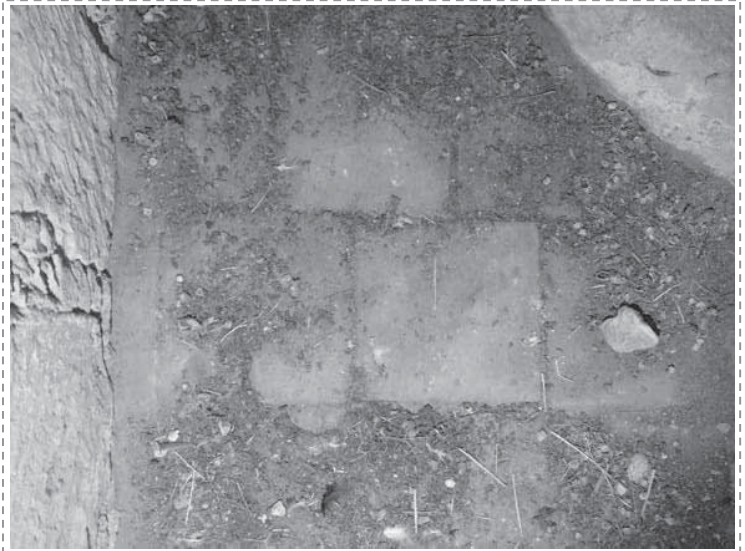
Imagen 4: piso de baldosa cerámica en pasillo de acceso al coro.
