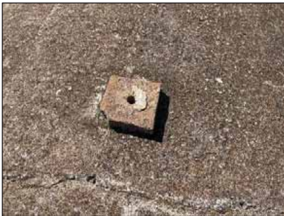
Figura 29: Base de ignimbrita para suspensión de candelabro. Fuente: Fotografía del autor.
