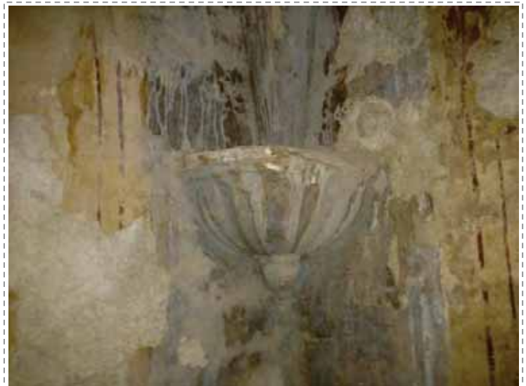
Imagen 4: venera de ignimbrita en arranque de bóveda.
