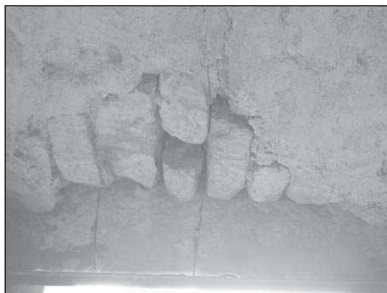
Figura 25: Platabanda aparejada en vano de puerta de torre. Fuente: Fotografía del autor.
