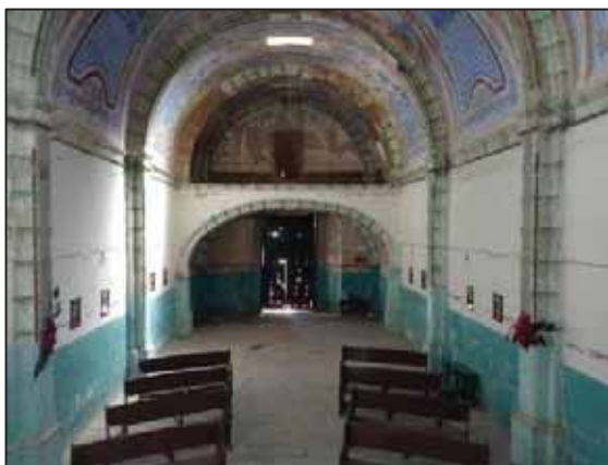
Figura 27: Cubierta y entrepiso del templo. Fuente: Fotografía del autor.
