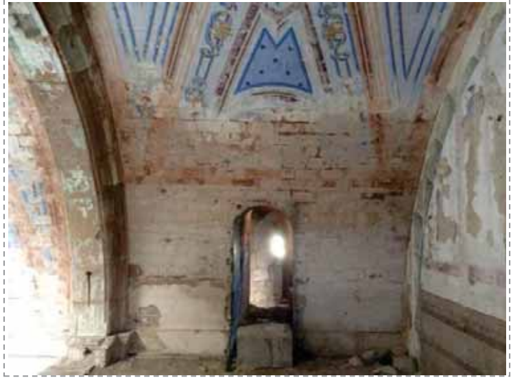
Imagen 2: vano de acceso desde la torre.
