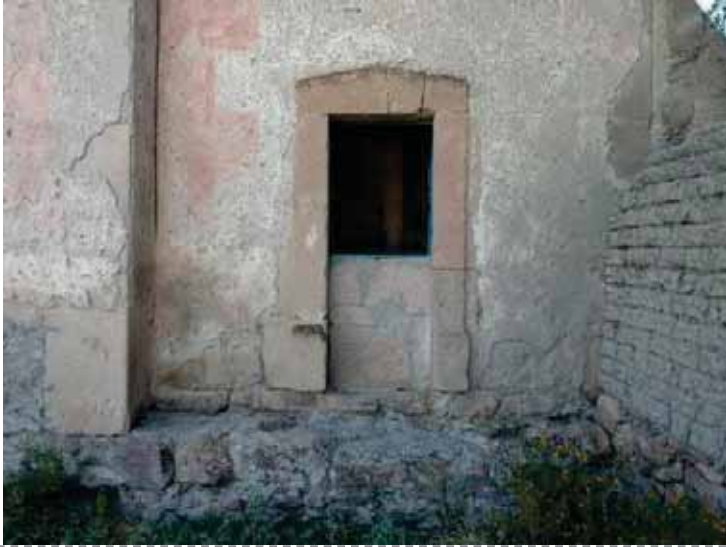
Imagen 1: vano de acceso a la torre, con marco de ignimbrita de dintel y jambas rectas, acabado aparente.
