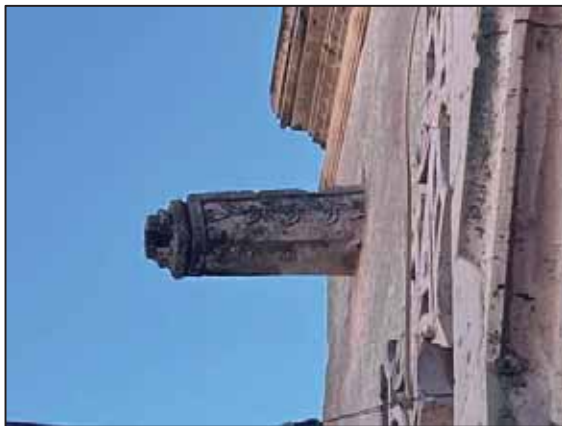
Figura 30: Gárgola de cantería en fachada. Fuente: Fotografía del autor.
