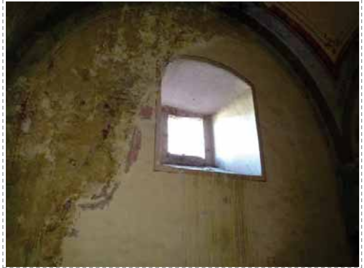
Imagen 2: ventana con capialzado en arco y jambas en derrame.
