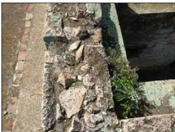
Figura 18: Corona de muro, se observa el núcleo de pedacería de piedra. Fuente: Fotografía del autor.
