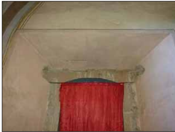
Figura 23: Platabanda dovelada en vano de sacristía. Fuente: Fotografía del autor.
