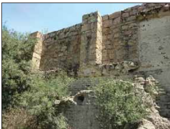
Figura 19: Estribos existentes en muro sur. Fuente: Fotografía del autor.
