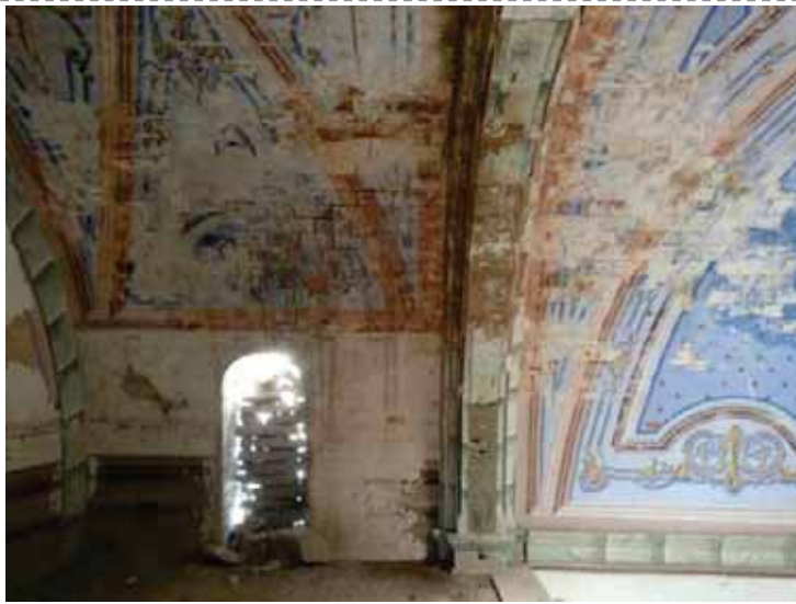
Imagen 3: antiguo vano de acceso desde la Casa Grande.
