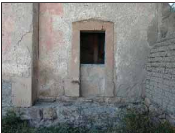
Figura 24: Vano de puerta en torre. Fuente: Fotografía del autor.
