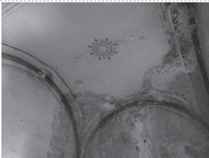
Imagen 3: bóveda tabicada de arista, con aplanados de mortero de cal-arena, y pintura a la cal.
