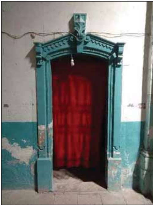
Figura 22: Vano de acceso a sacristía. Fuente: Fotografía del autor.
