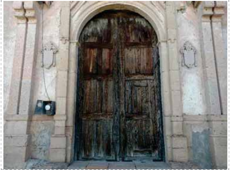
Imagen 2: extradós del vano de acceso al inmueble.
