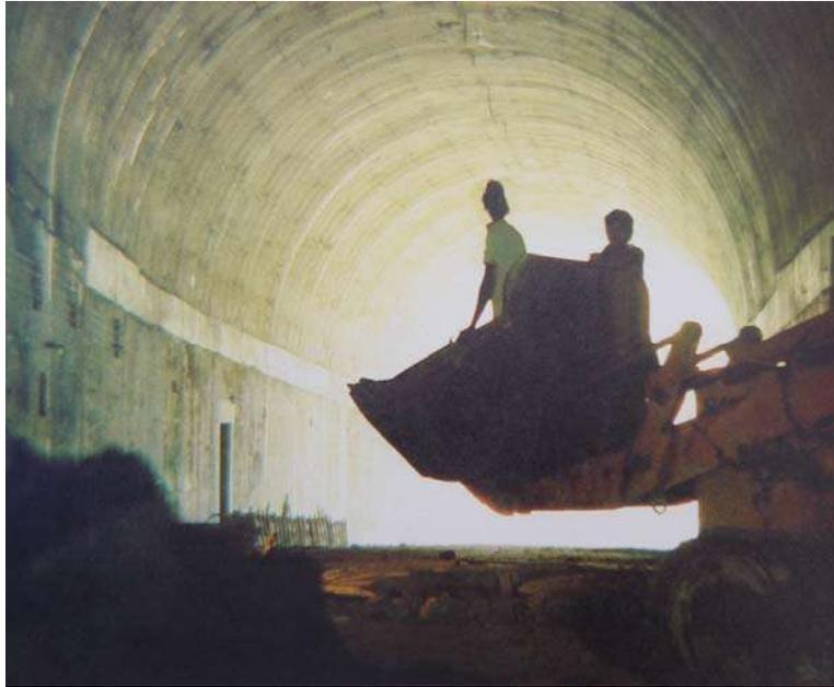
Fig. 30.- Túnel Atoyac, extracción de material producto del banqueo
