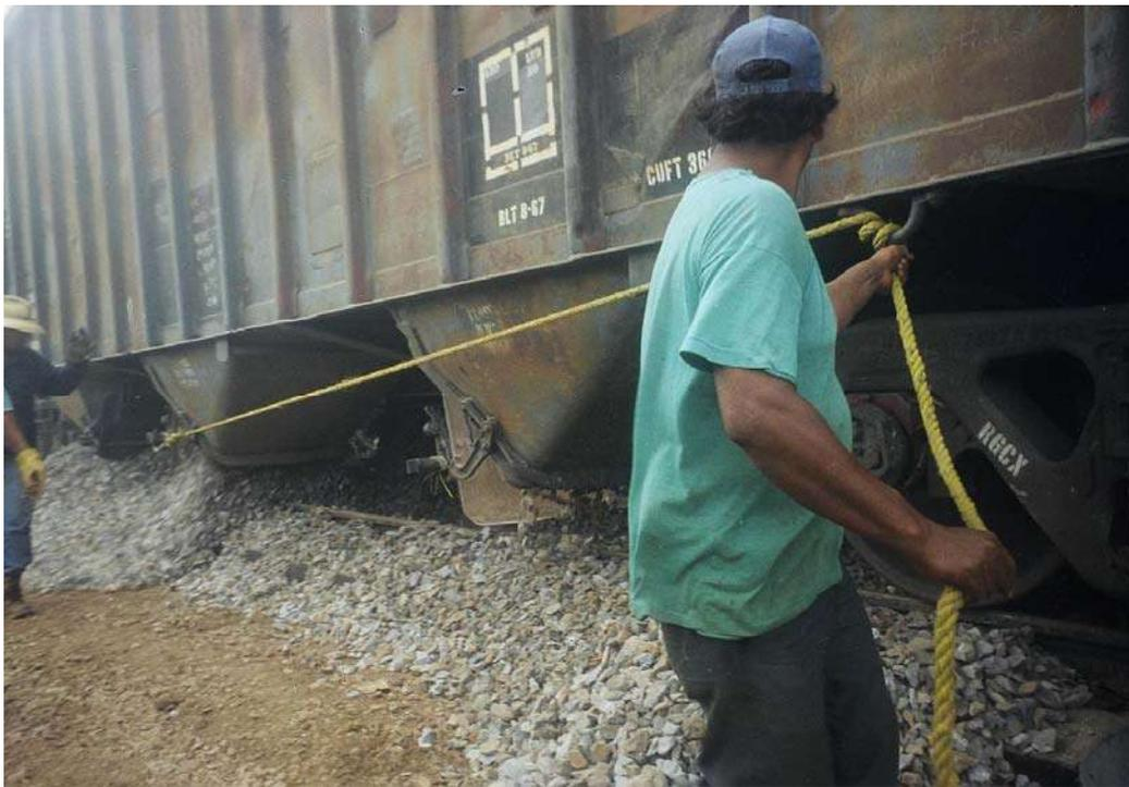
Fig. 3.- Descarga de balasto a paso de tren, con góndolas balasteras
