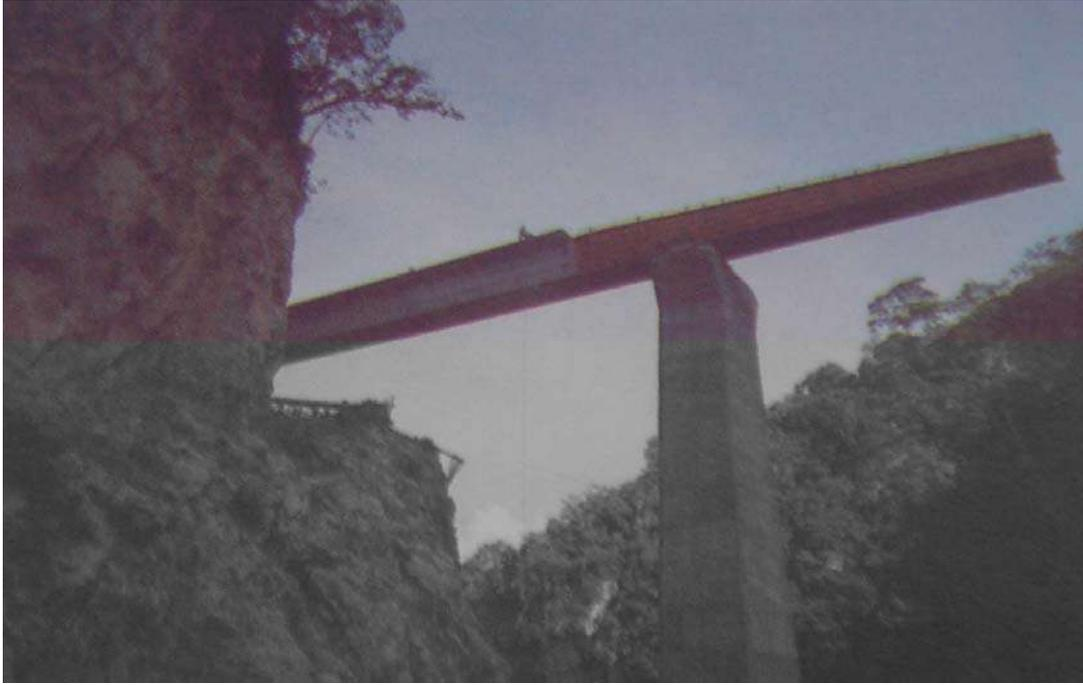
Fig. 33.- Viaducto Atoyac-Chiquihuite, empuje de las primeras dovelas ancladas a la nariz metálica
