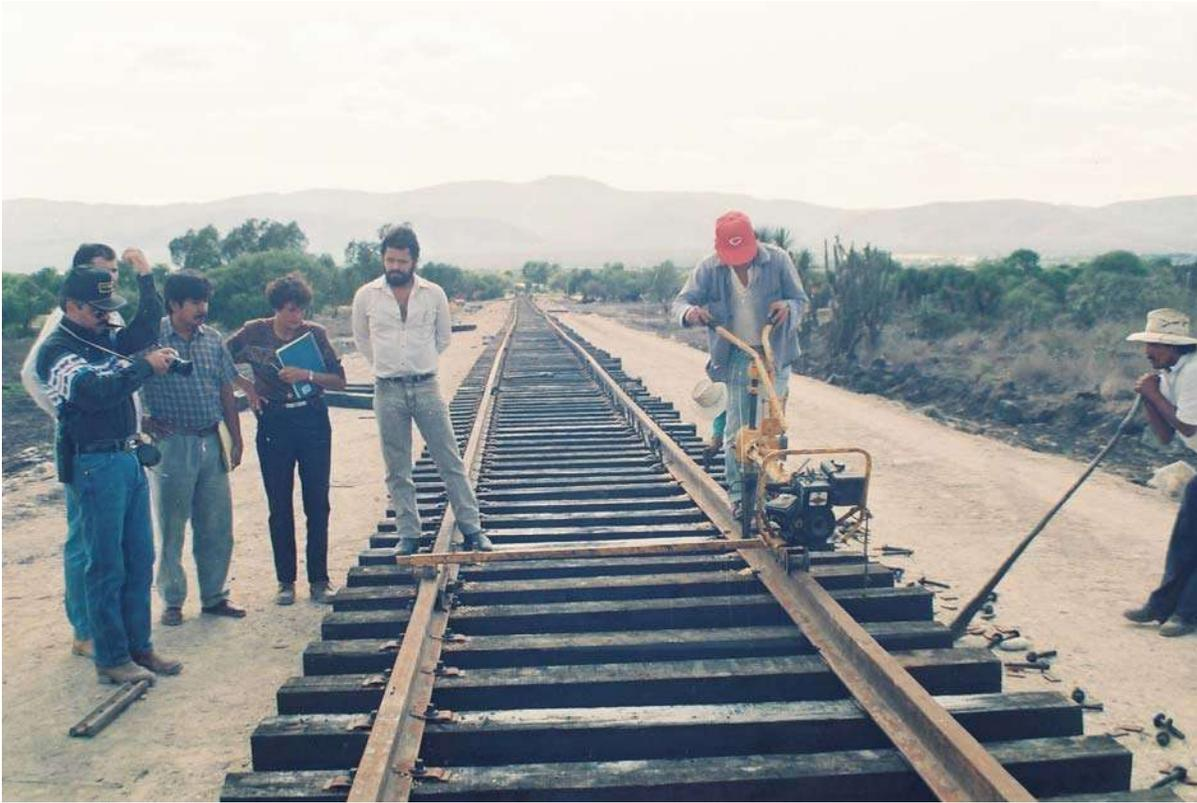
Fig. 12.- Durmientes para vía, de madera dura, tratados con impregnación de creosota
