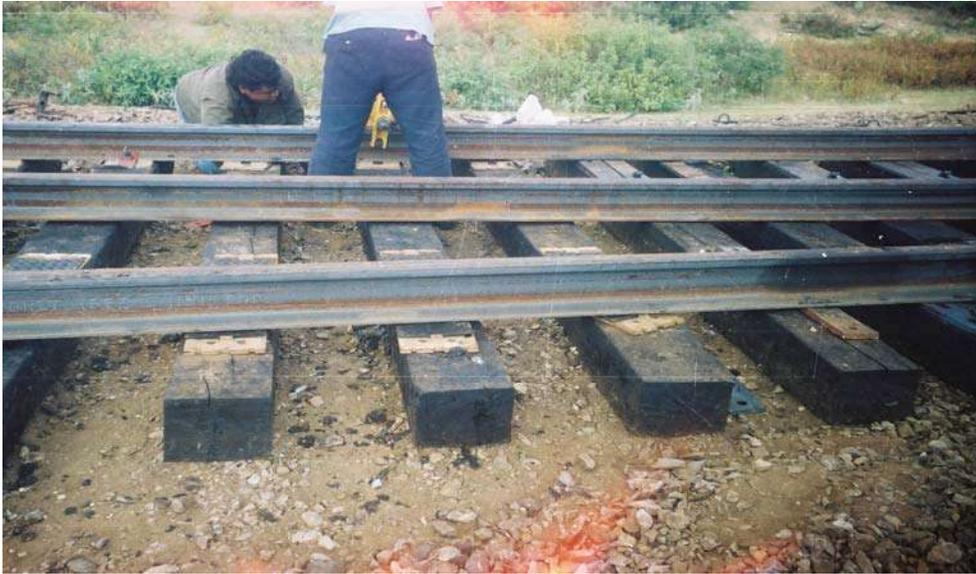
Fig. 29.- Vía tradicional, con placa de asiento, tirafondo y durmiente de madera
