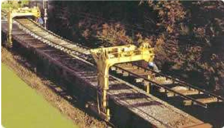
Fig. 11.- Pórticos hidráulicos, descargando un tramo de vía premontado
