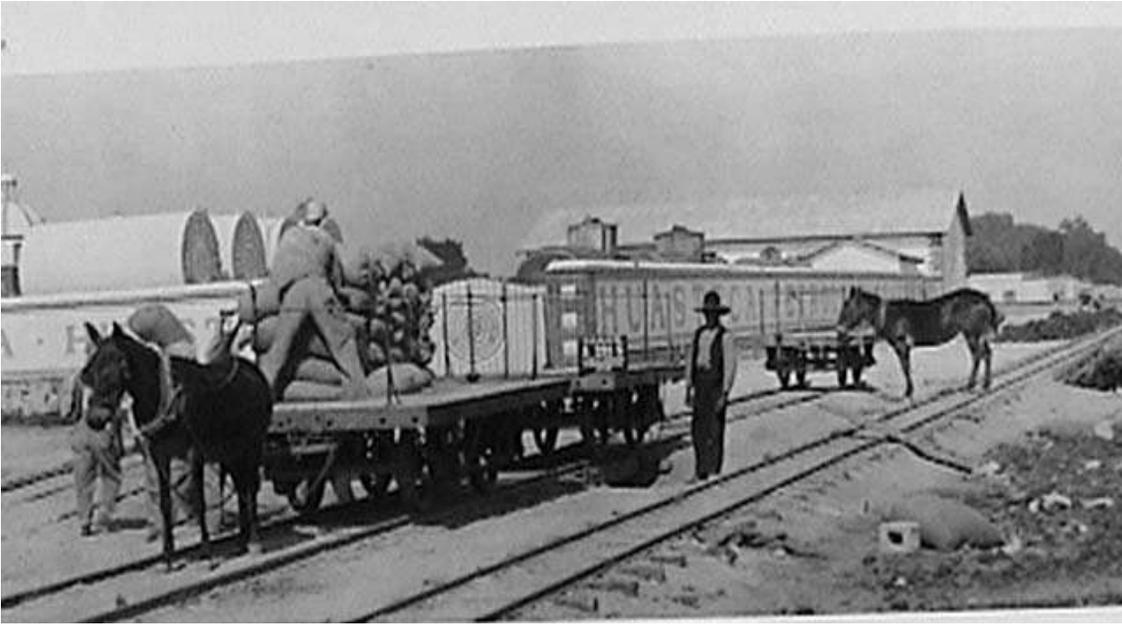
Fig. 6.- Carga y descarga de flete en Vías de patio, plataformas de tracción animal
