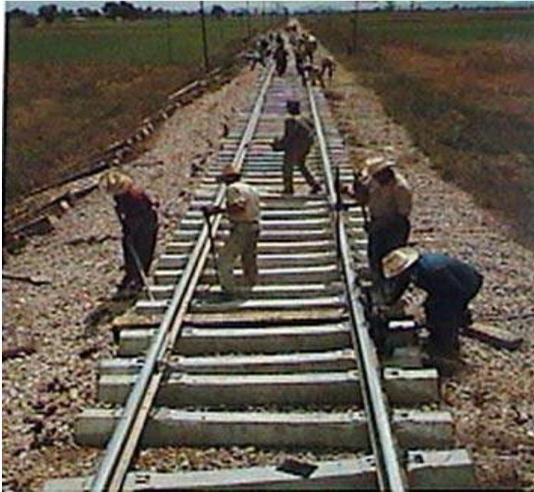
Fig. 22.- Rehabilitación de vía, cambio de durmiente, riel y sujeción
