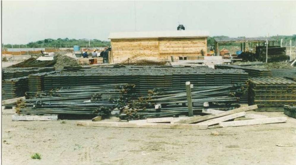
Fig. 7.- Almacén de materiales, placas de asiento, planchuelas, durmientes de madera, etc.
