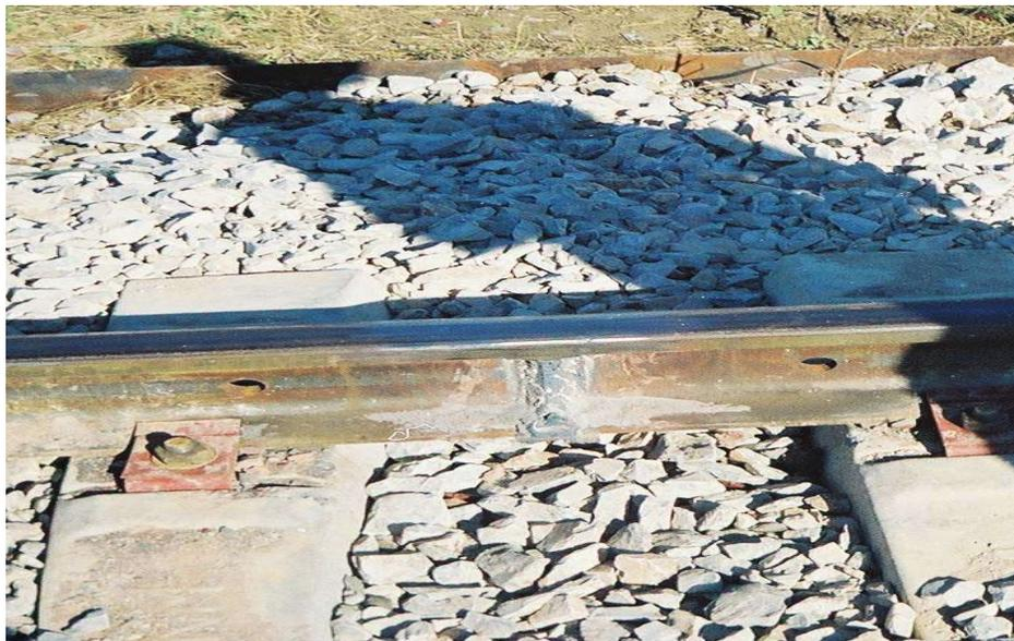
Fig. 26.- Soldadura aluminotérmica, esmerilada, en riel de 112 lb/yd
