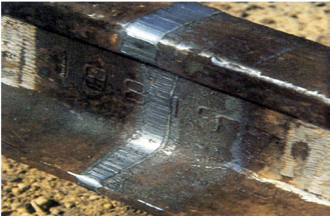
Fig. 25.- Soldadura eléctrica, en riel de 115 lb/yd
