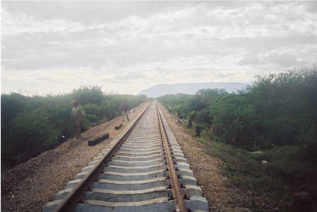
Fig. 14.- Durmiente monolítico (monoblock), de concreto preesforzado
