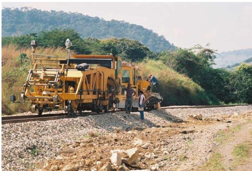
Fig. 6.- Multicalzadora y reguladora de balasto, afinando y nivelando vía
