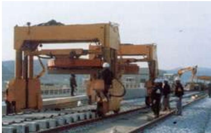
Fig. 15.- Pórtico mecanizado, descargando durmierte de concreto
