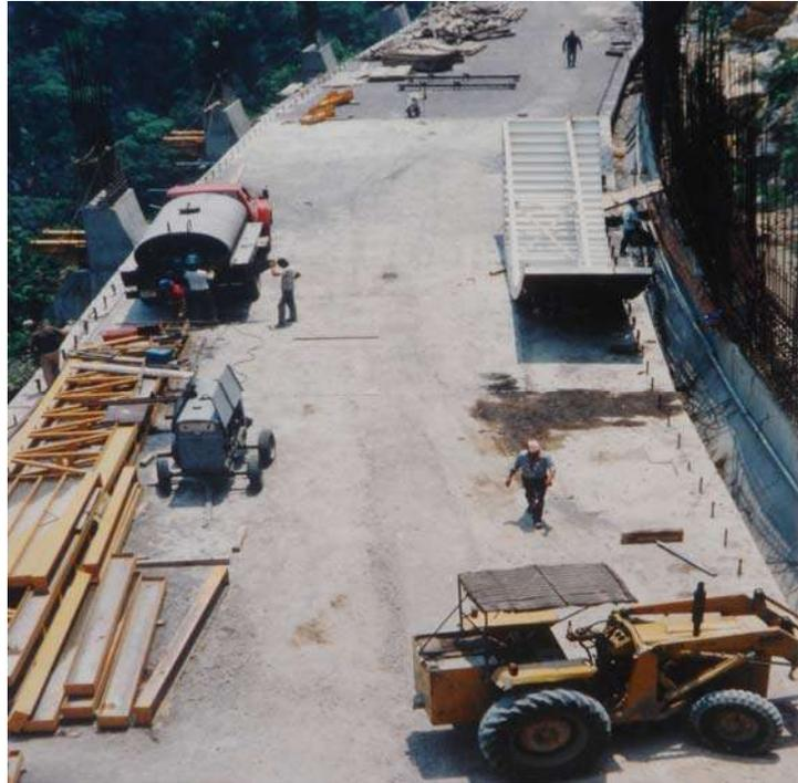
Fig. 31.- Viaducto-Túnel pensil, terminación del viaducto (en curva)
