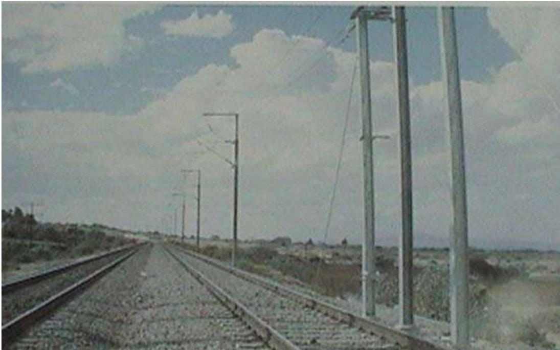
Fig. 14.- Doble vía Electrificada México-Querétaro (247 Km)
