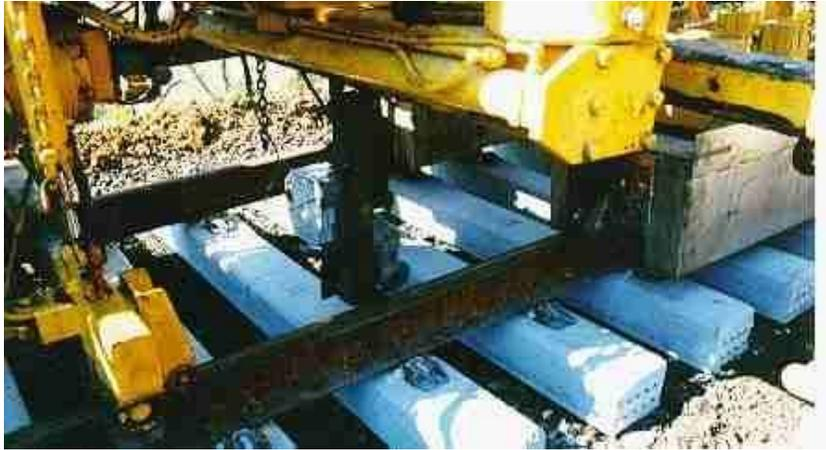
Fig. 28.- Máquina soldadora por calentamiento de las uniones de los rieles
