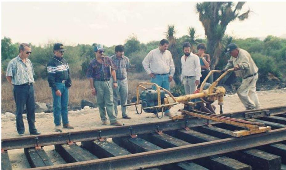
Fig. 31.- Elementos de fijación, placa de hule acanalada, grapilla y tirafondo
