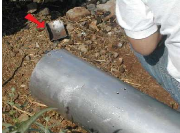
Figura 7 En esta imagen se observa uno de los aditamentos construidos para fijar los accesorios de las estaciones de medición del nivel de agua.
