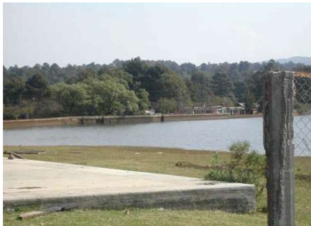
Figura 3 Imagen que muestra panorámicamente el lugar donde se decidió la colocación de la estación de medición del nivel de agua, (cortina de la presa de Umécuaro).
