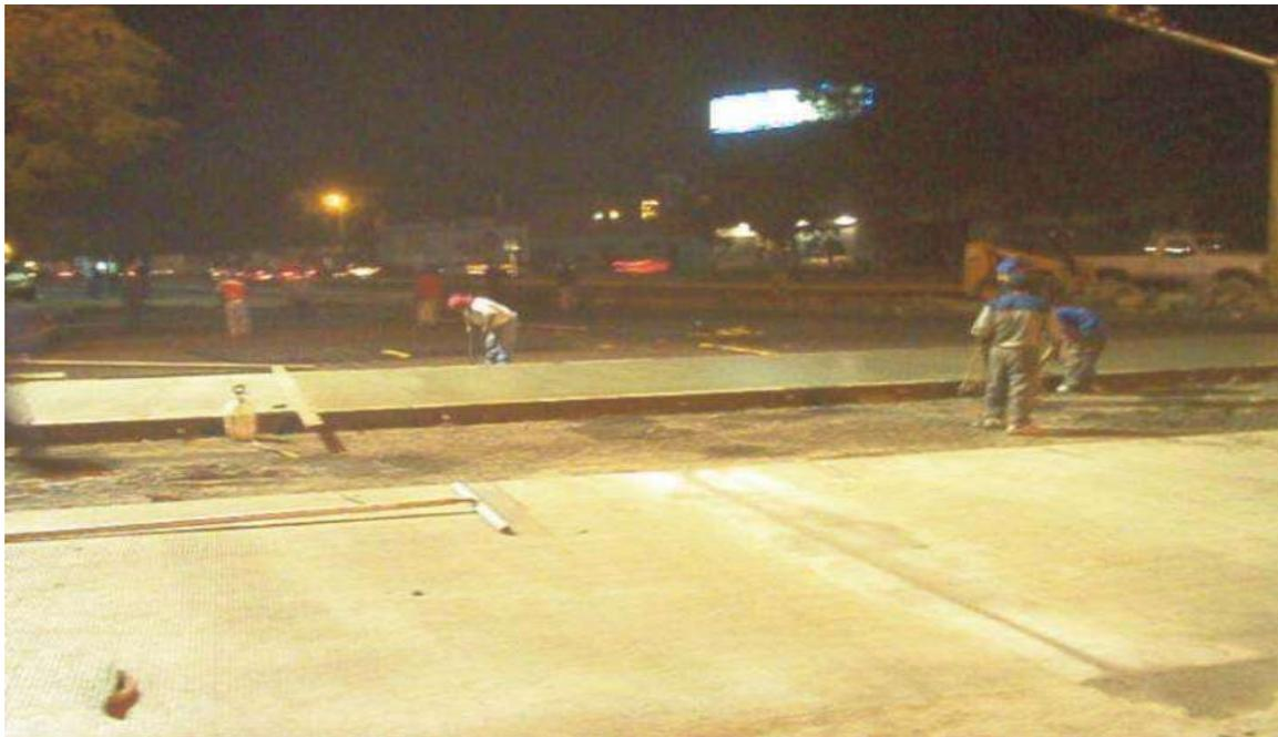
**FOTO No.22.-COLOCACION DE CONCRETO HIDRAULICO Y VISTA DE ACERO DE REFUERZO**
