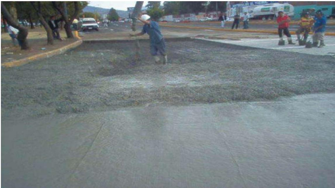
**FOTO No.24.- COLOCACION DE CONCRETO HIDRAULICO**
