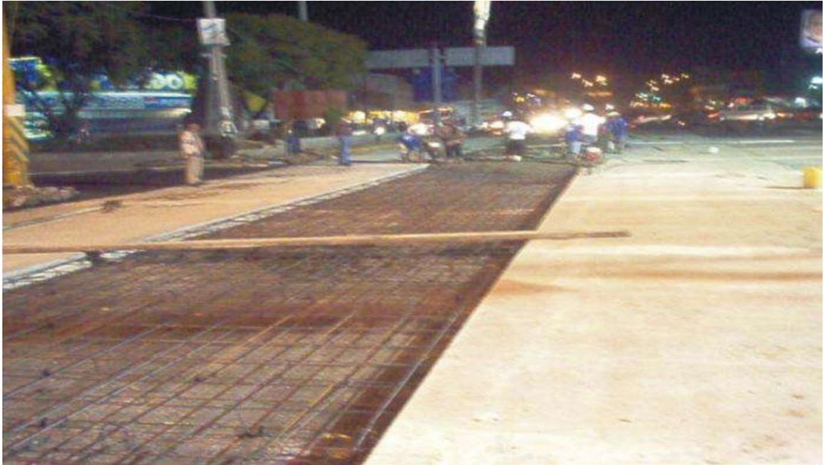
**FOTO No.21.-COLOCACION DE CONCRETO HIDRAULICO Y VISTA DE ACERO DE REFUERZO**
