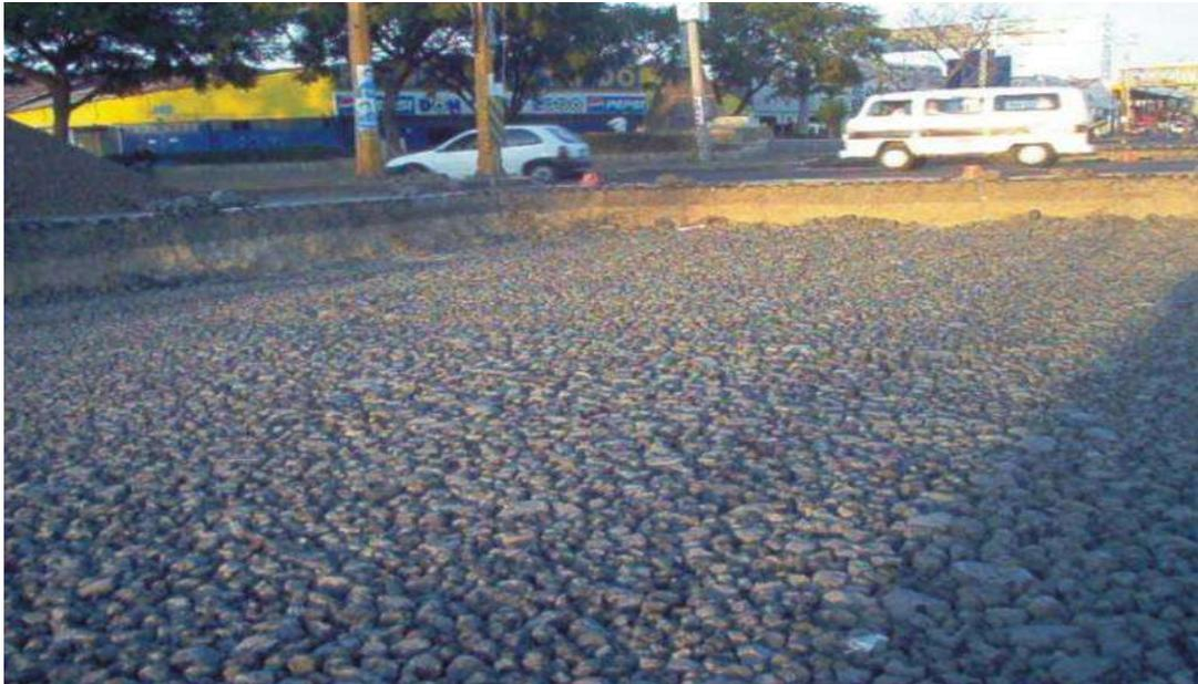
**FOTO No.11- TENDIDO DE CAPA DE SUB-BASE**
