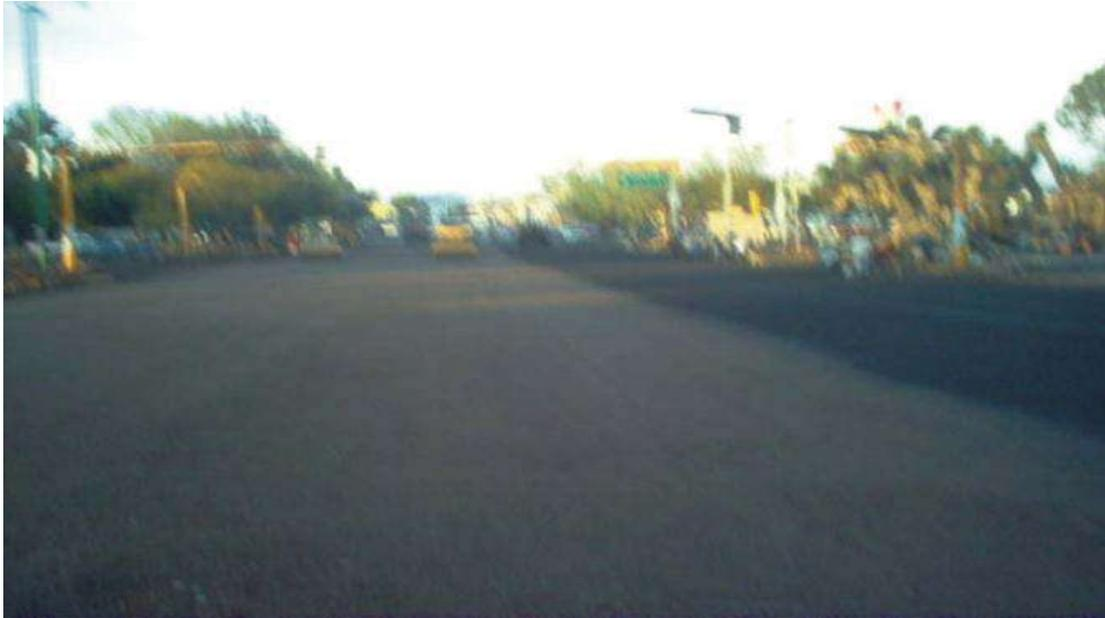
**FOTO No.-13 COMPACTACION DE CAPA DE BASE HIDRAULICA**
