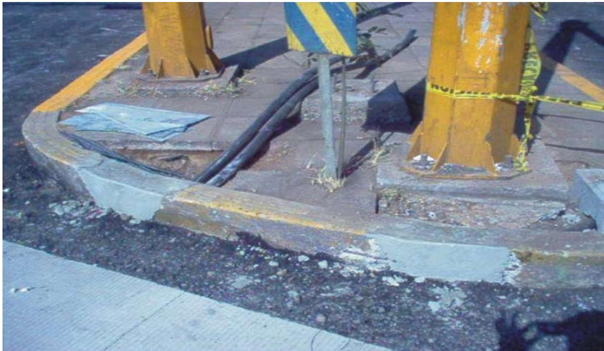
**FOTO No.29.- REPARACION DE GUARNICIONES DAÑADAS Y LOSETAS**
