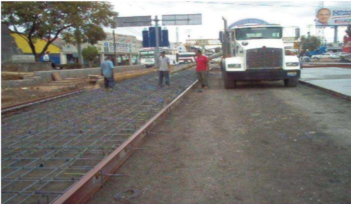
**FOTO No.20.-COLOCACION DE CONCRETO HIDRAULICO Y VISTA DE ACERO DE REFUERZO**
