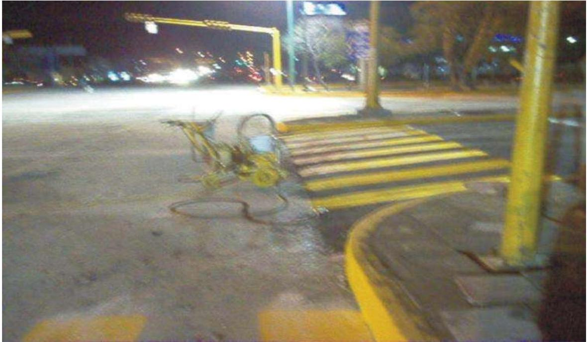
**FOTO No 28.—BALIZAMIENTO Y SEÑALAMIENTO**
