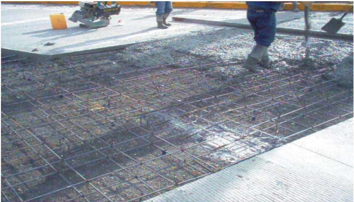
**FOTO No.- 18 COLOCACION DE CONCRETO**
