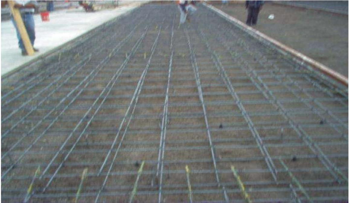
**FOTO No-17 COLOCACION DE ACERO DE REFUERZO Y VISTA DE LOSA**
