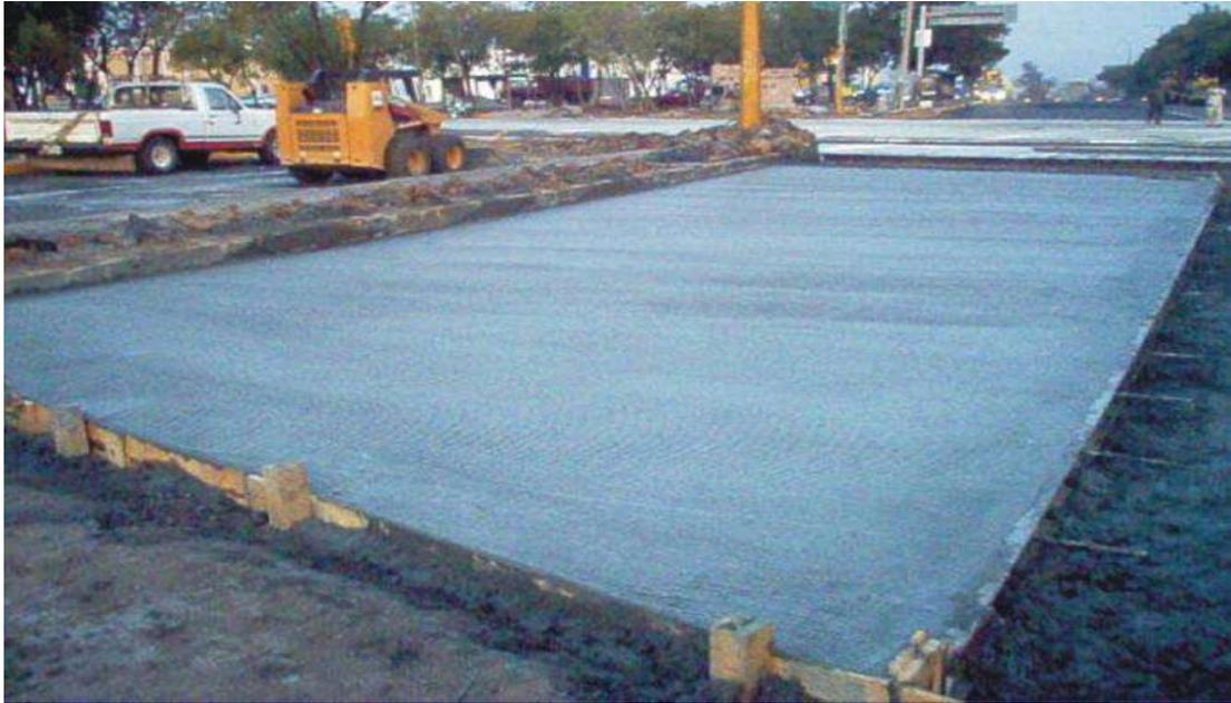
**FOTO No.19.- COLOCACION DE CONCRETO**
