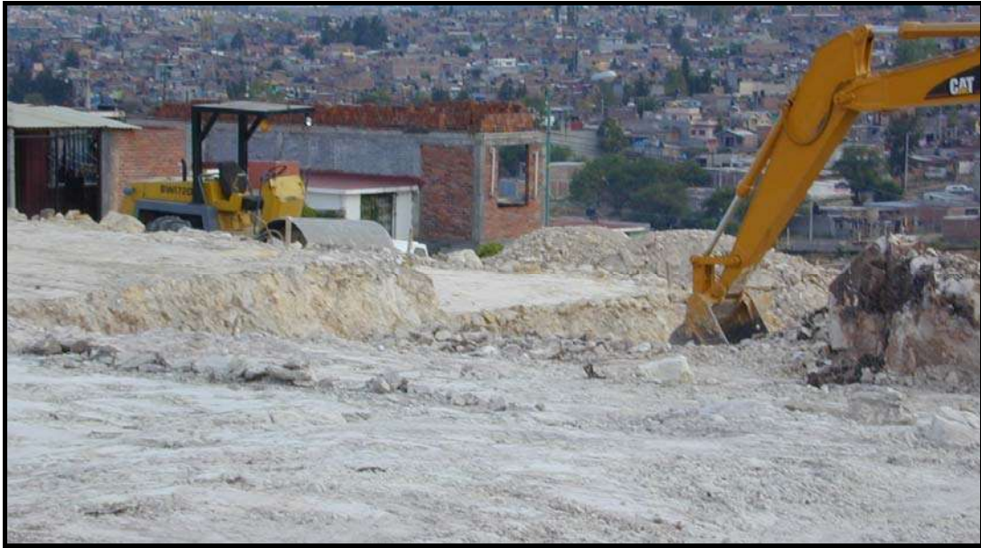
Foto 20.- Procedimiento constructivo de las casa habitación.
