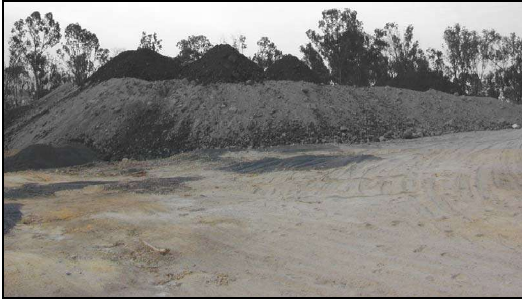
Foto 4.- Vista oriente poniente para verificar donde, va a ser desplantado el nuevo conjunto habitacional.
