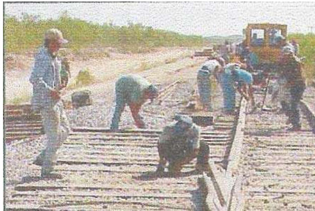
COLOCACION DE SAPO No. 10 Y CONTRARIELES
