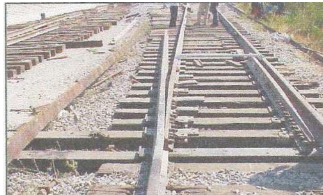
COLOCACION DE AGUJAS, PLACAS CORREDERAS, PLACS ESCANTILLON Y RIEL DE APOYO
