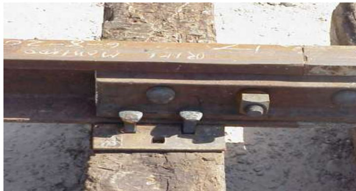
ACCESORIOS DE FIJACION DE UNA VIA CLASICA CLAVADA
