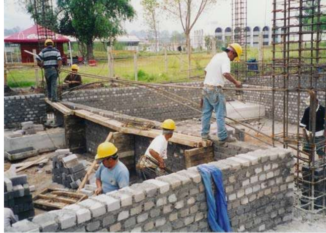
Colocación de enrase de tabicón
