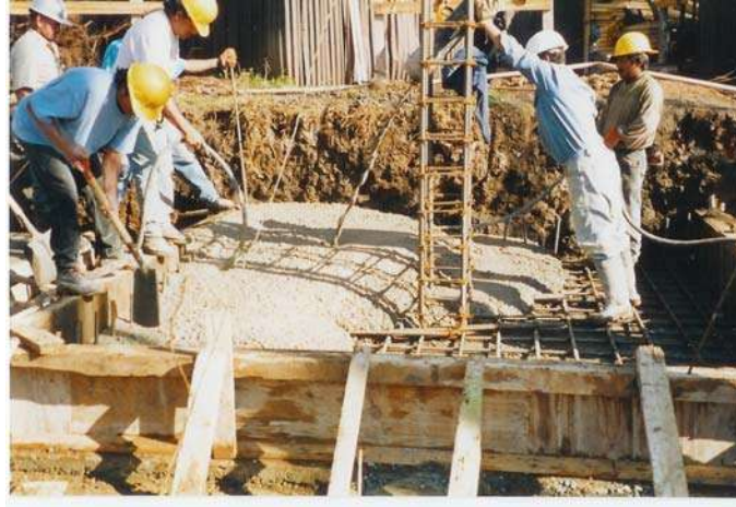
Colado de zapatas con concreto premezclado.
