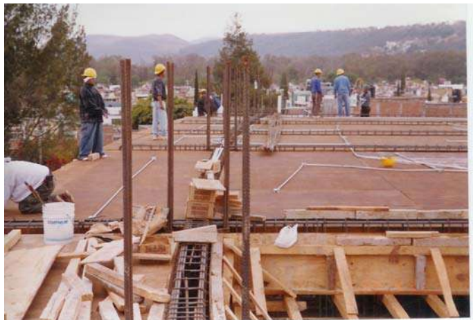
Tendido de tubería de instalación eléctrica en losa de azotea.
