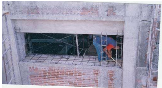
Armado de repisiones.
