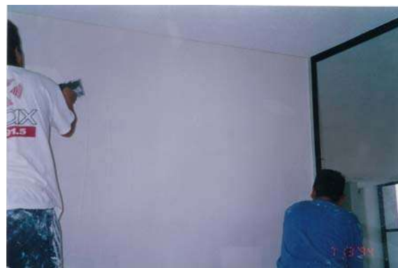
Aplicación de pasta en muros
