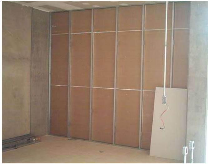
Muro de tablaroca.
