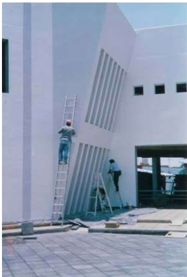
Aplicación de pintura en fachadas.
