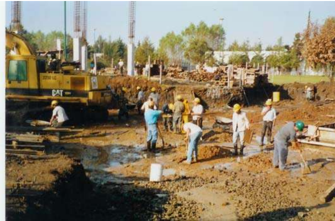
Excavación con maquinaria en área de edificios.
