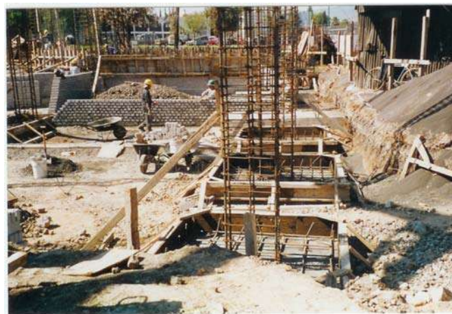
Cimbra de madera en zapatas.
