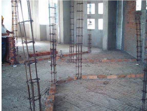
Trazo de muros en planta alta.
