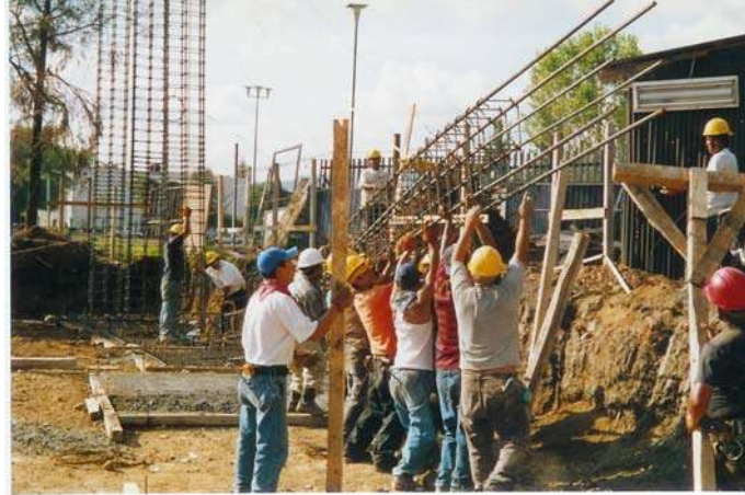
Levantamiento de columnas
