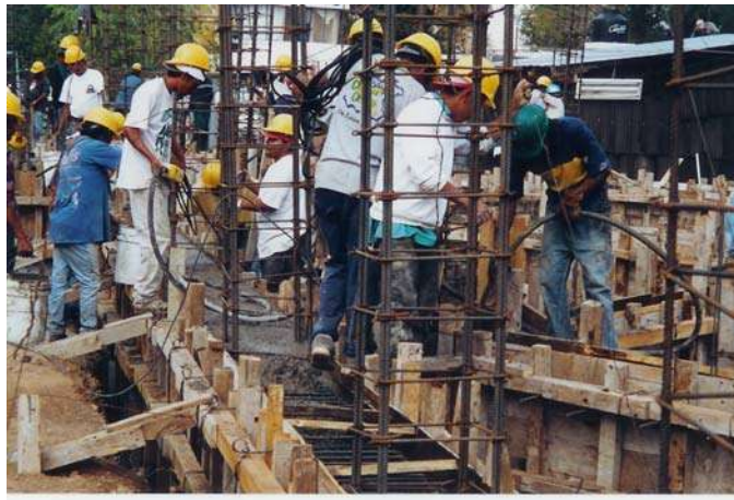
Colado de traves de cimentación, utilizando vibrador de alta frecuencia.
