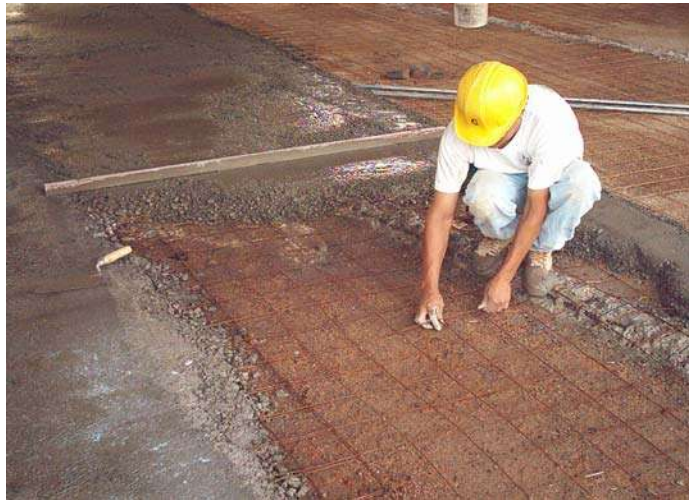
Colado de firmes de concreto en planta baja.
