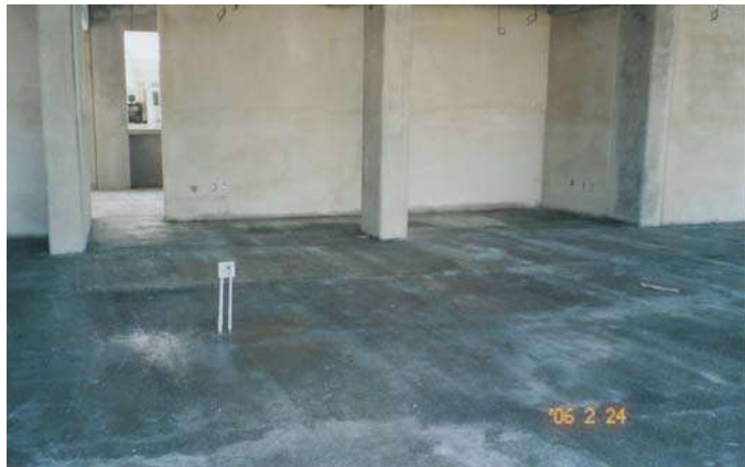
Colado de firmes de concreto en planta alta,
