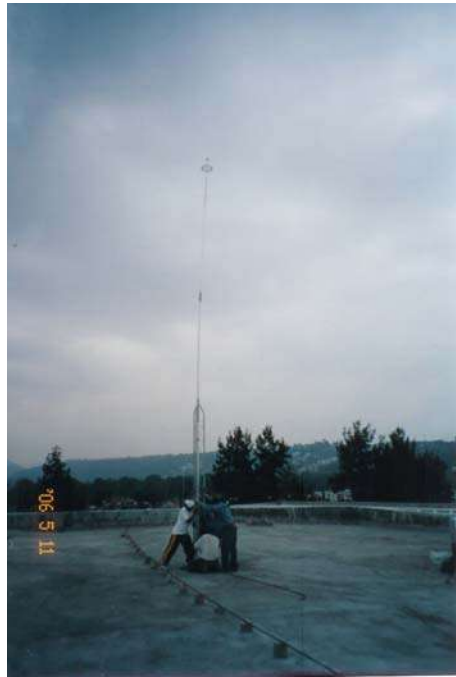
Colocación de pararrayos en azotea.
