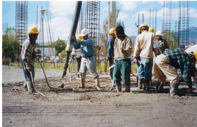
Colado de losa de entresuelo.
