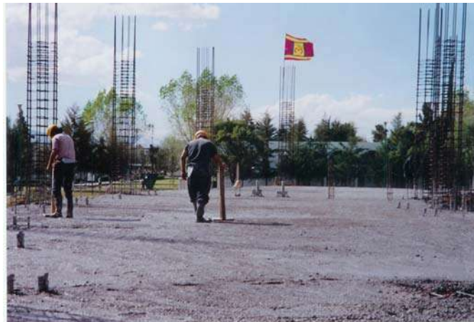
Compactación del concreto en losa de entresuelo con pisón de madera.
