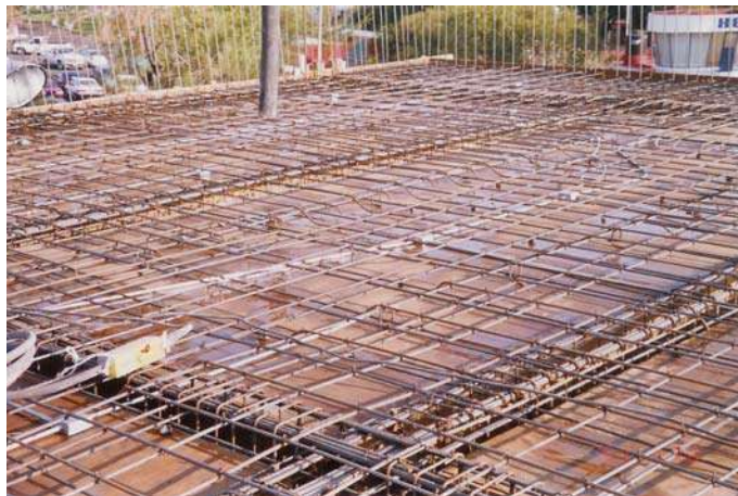
Armado de losa de entrepiso.
