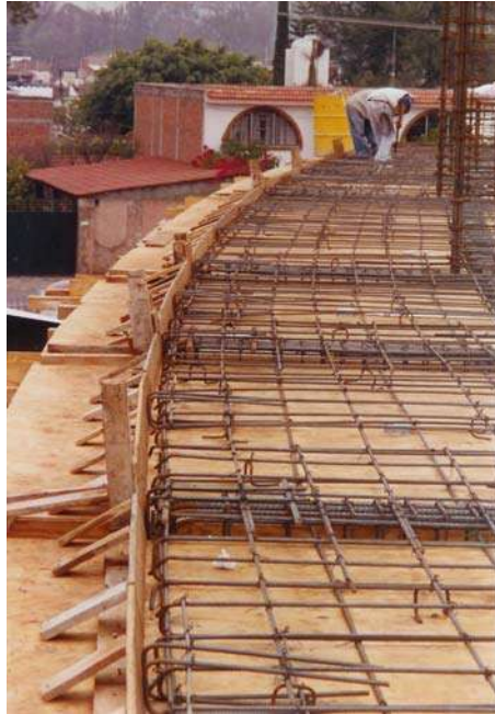
Armado de losa de entrepiso.
