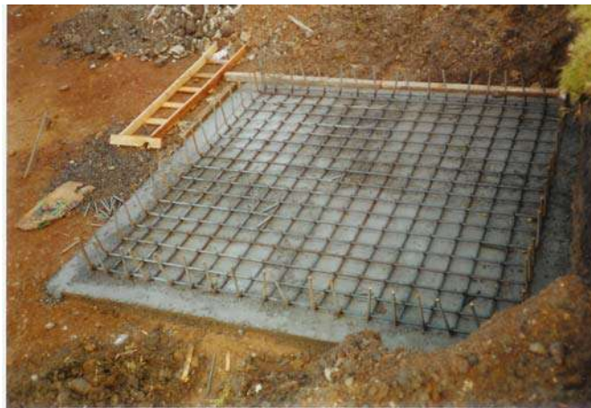
Armado de zapatas.
