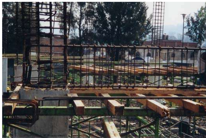
Cimbra y acero en trabes de entepiso.
