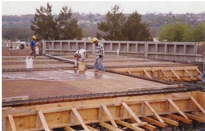
Aplicación de desmoldante en cimbra.
