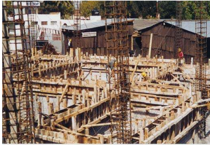
Cimbra en traves de cimentación.
