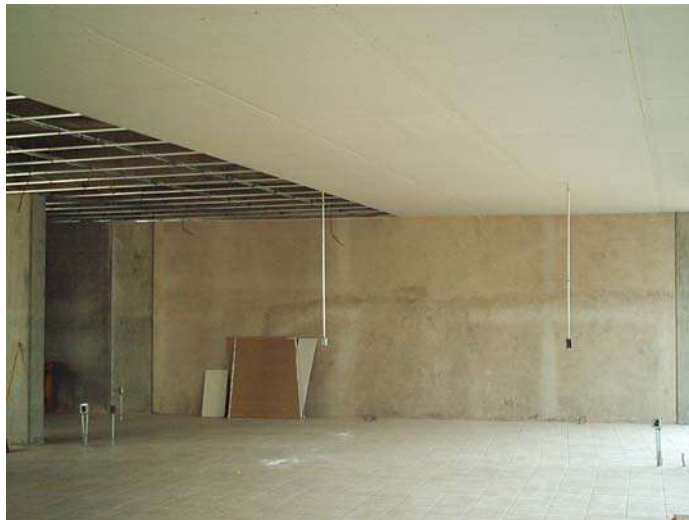
Colocación de falso plafón.
