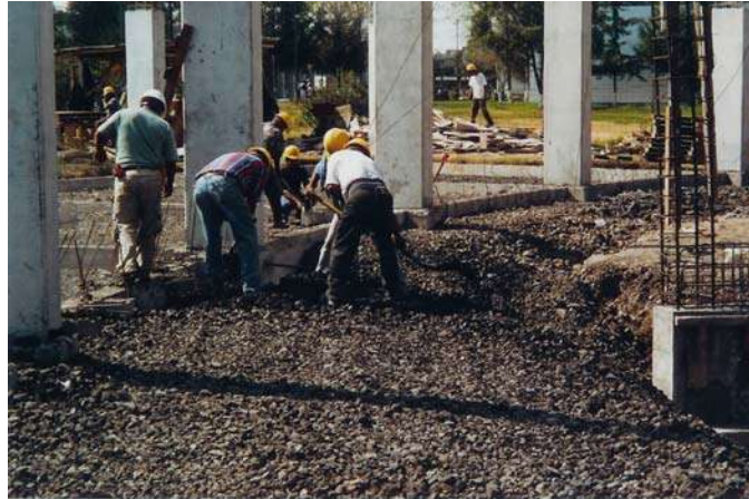
Relleno con material filtro
