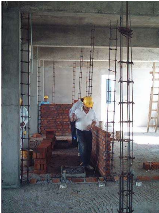
Elaboración de muros de tabique.
