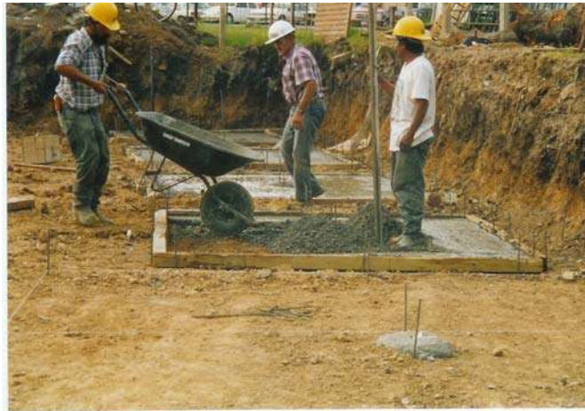
Colocación de plantilla de concreto pobre.
