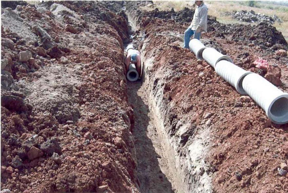
Línea de tubería sanitaria, conectado al pozo de visita
