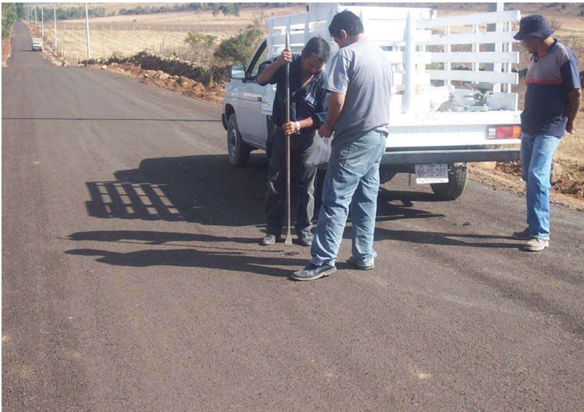
Revisión de los trabajos por medio de la ayuda de un Laboratorio de Materiales como procedimiento preventivo.
