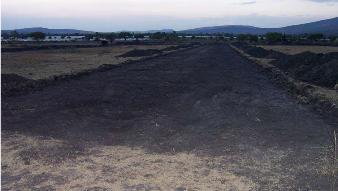
Despalme del terreno.
