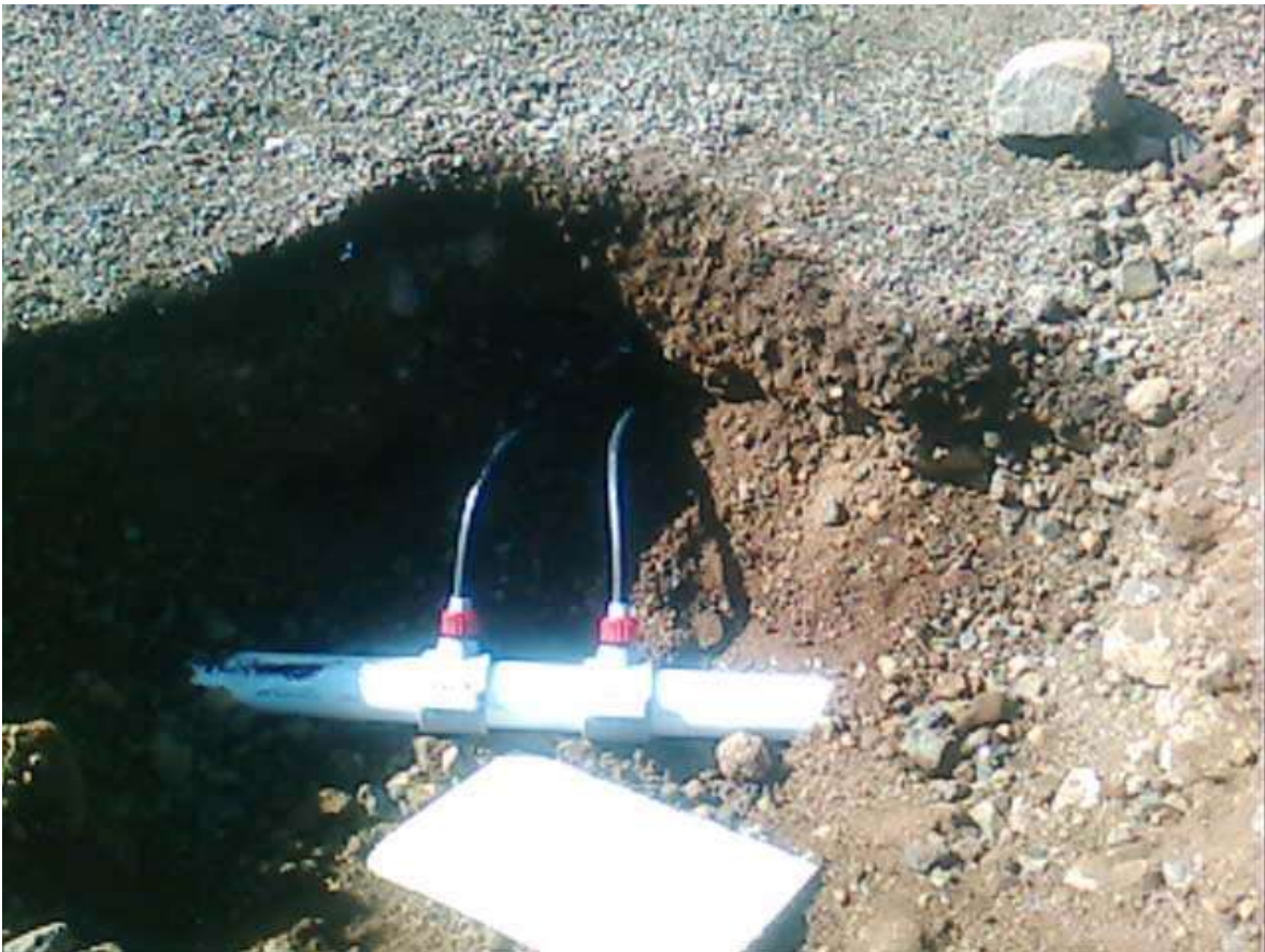
Tomas domiciliarias en línea de agua potable con tubería de PVC
