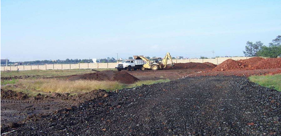
Carga mecánica y acarreo en camión
