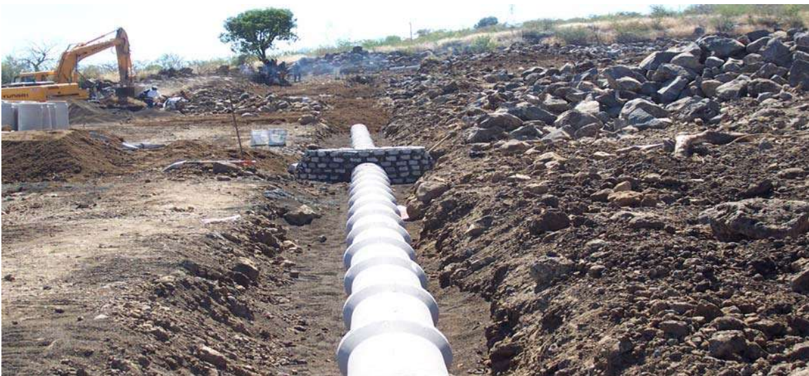
Tendido de la tubería de concreto en línea de drenaje.
