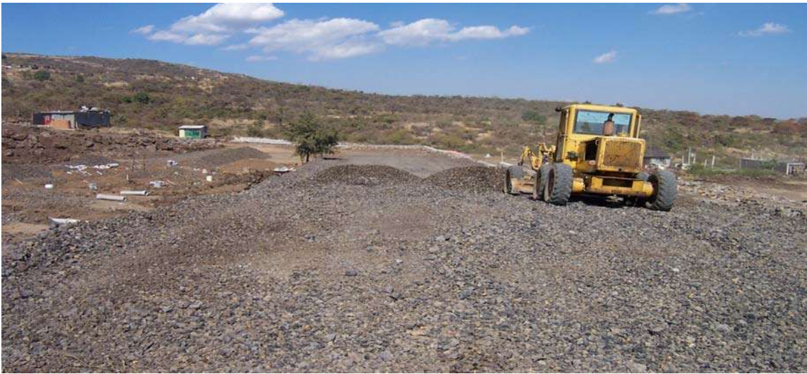
Tendido de la capa de filtro con motoconformadora Cat 12-F
