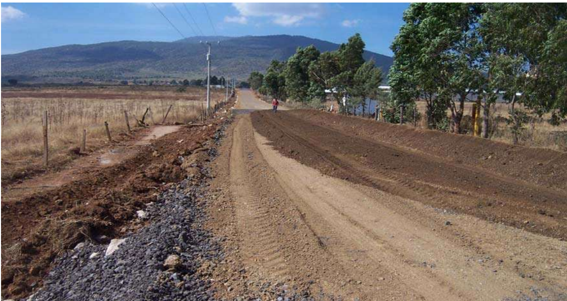
Tendido, mezclado e incorporación de agua a la capa de base hidráulica
