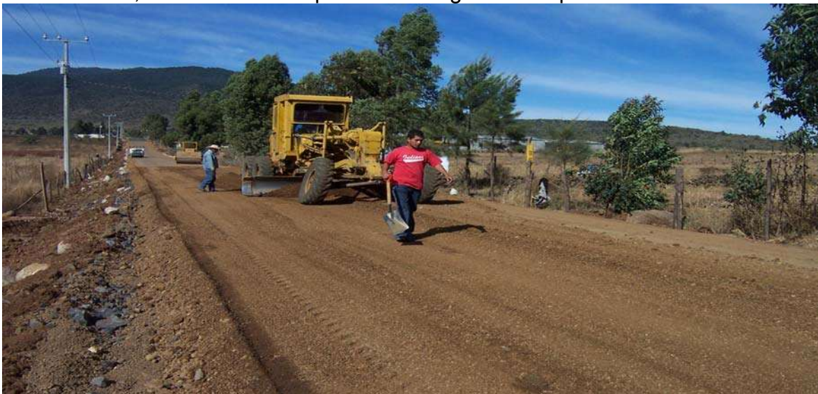
Tendido y nivelación de la capa de base hidráulica
