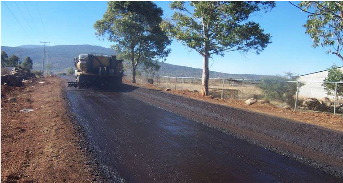
Incorporación de emulsión asfáltica al material pétreo para mezcla de carpeta
