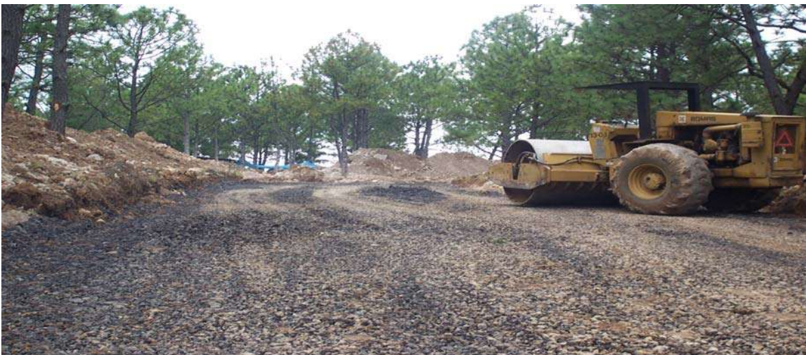
Compactación con rodillo vibratorio Bomag 210BW
