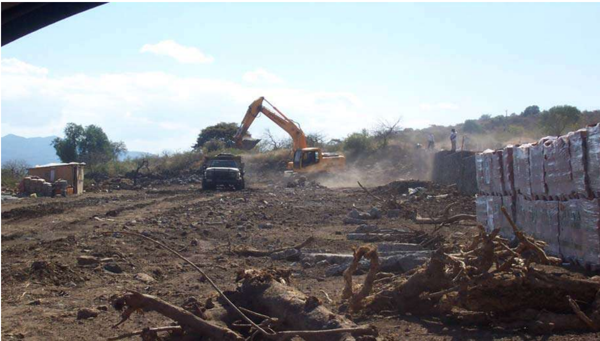
La carga mecánica se puede hacer con diferente equipo de construcción aquí con escavadora Hyundai
