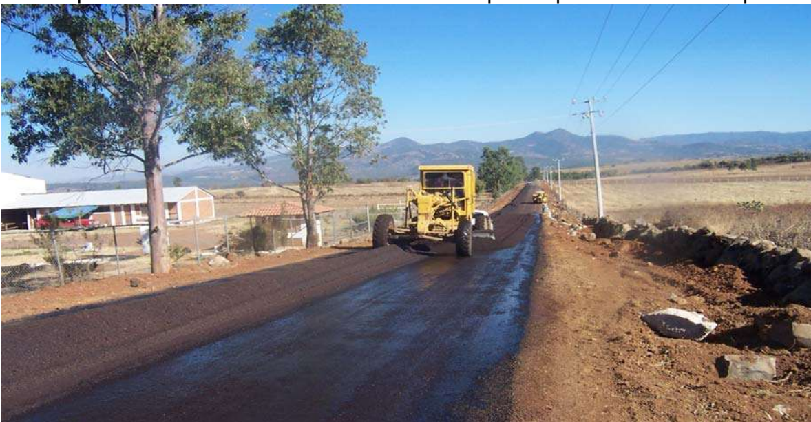
Tendido de carpeta asfáltica con motoconformadora
