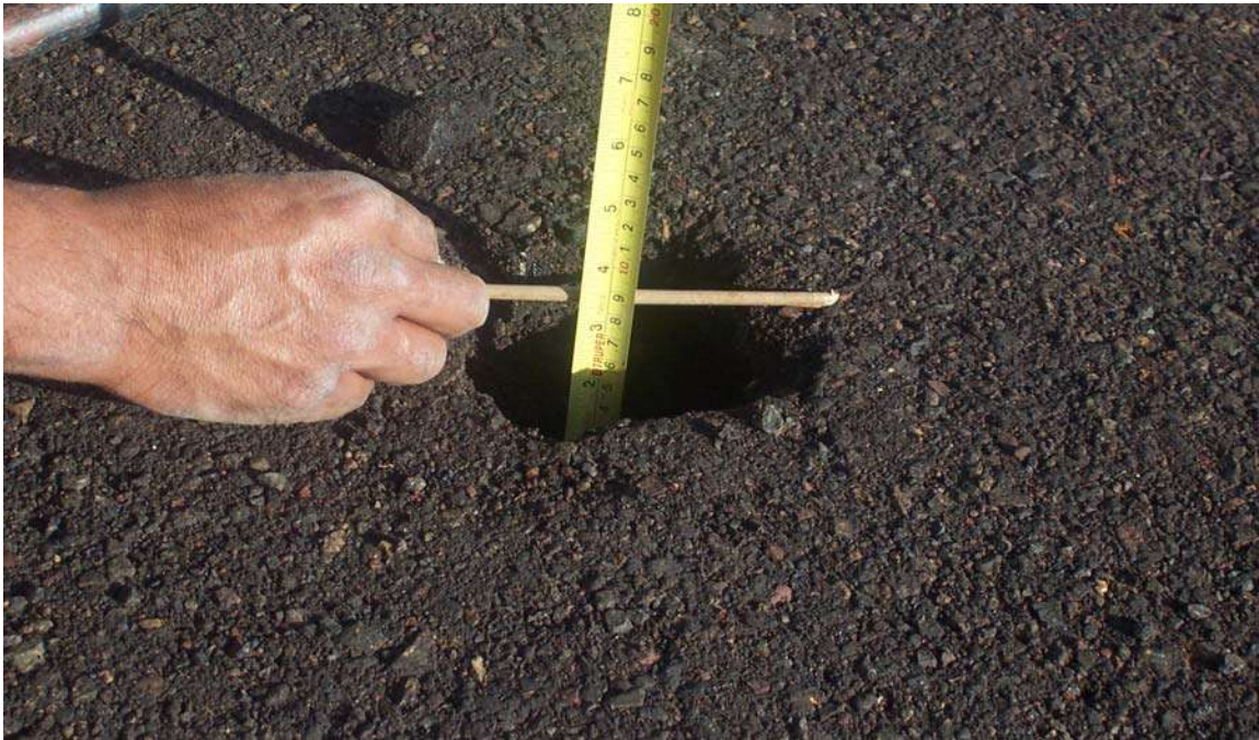
Revisando espesores de carpeta asfáltica y compactación de la misma.
