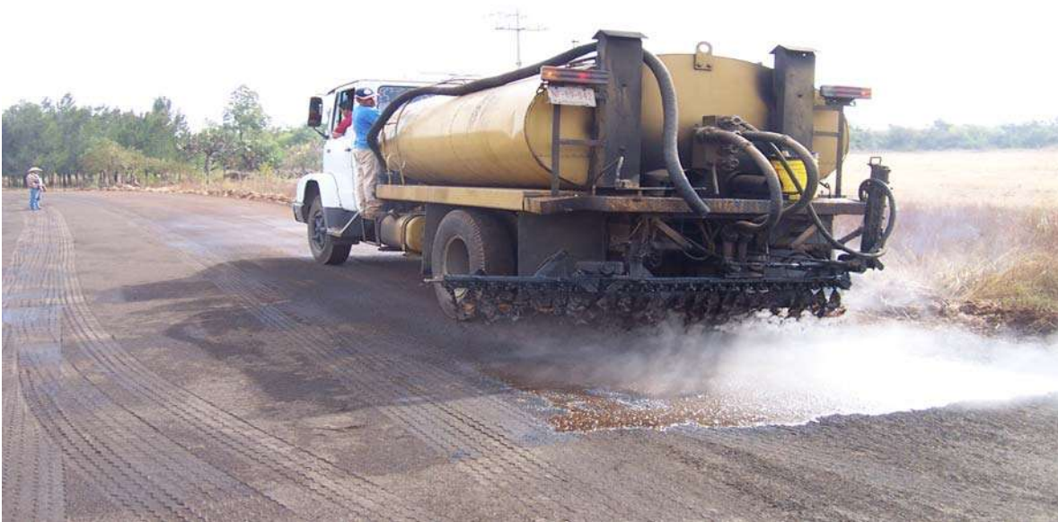
Riego de liga con emulsión asfáltica y camión petrolizadora
