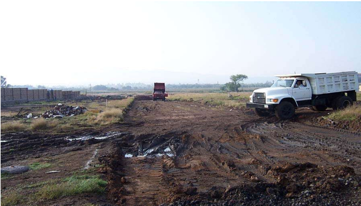
Despalme del terreno natural.
