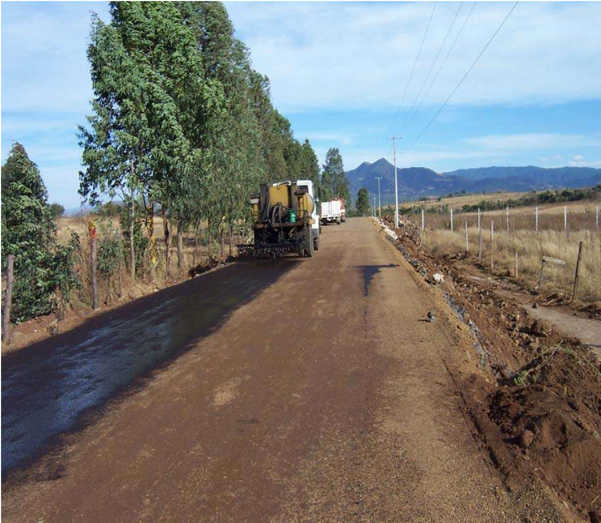
Riego con emulsión asfáltica y camión petrolizadora para proteger la capa de base hidráulica para evitar la pérdida de humedad.
