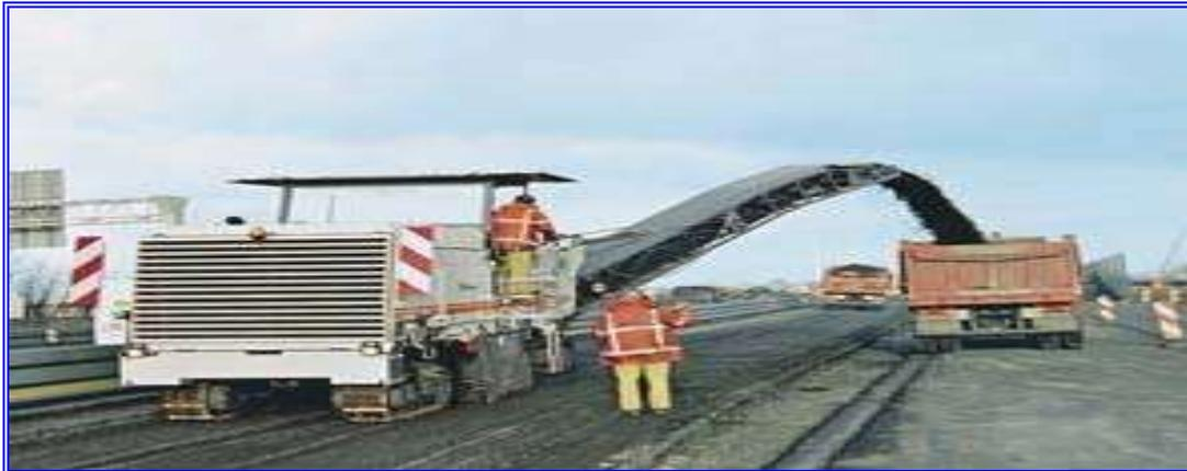
Obtención de MBR mediante el fresado de pavimentos.
