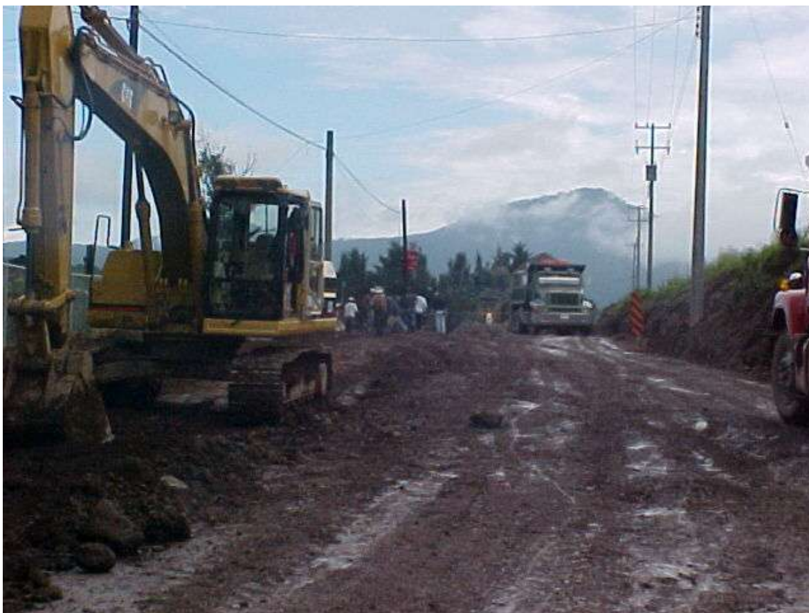
Foto No. 1.- Control de Obra.
