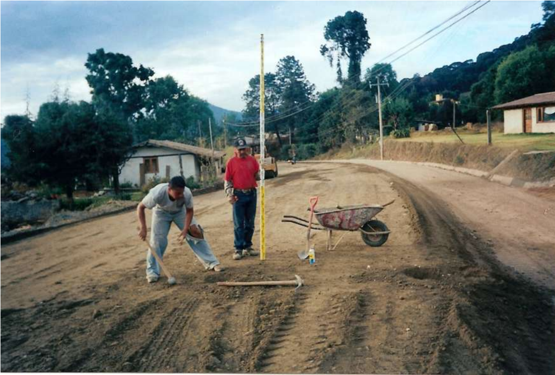
Foto No. 3.- Control Topográfico.
