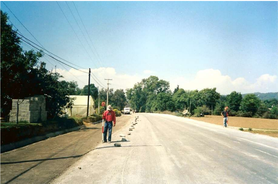
Foto No. 4.- Control Topográfico.
