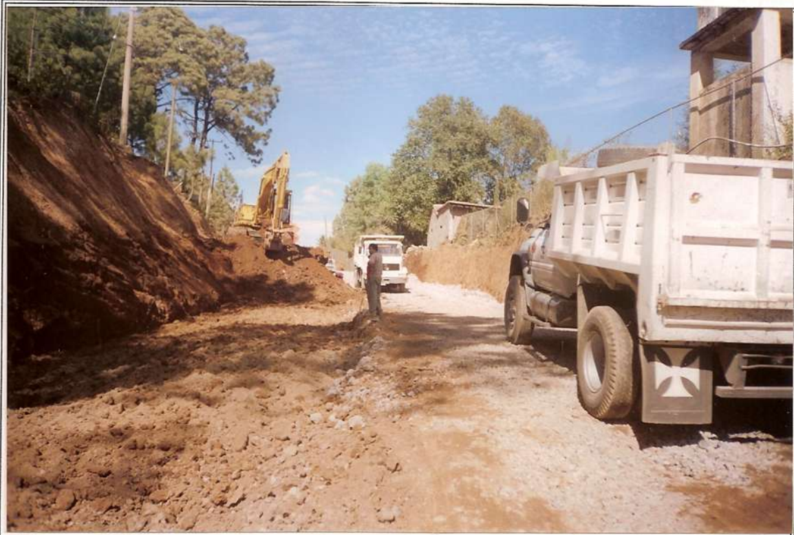
Foto No. 8.- Obra en Proceso.
