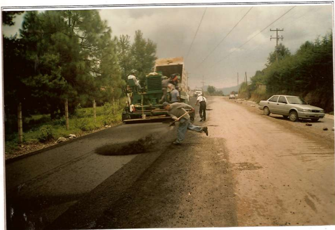
Foto No.9.- Obra en proceso.
