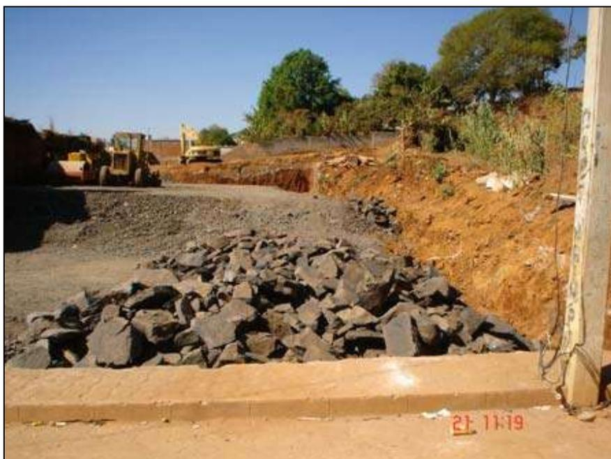
Para comenzar la excavación de la zanja en donde iría el muro de contención era necesario que se hubiera terminado de tirar filtro sobre la plataforma para tener una idea precisa de la zona en donde se colocaría el muro.
