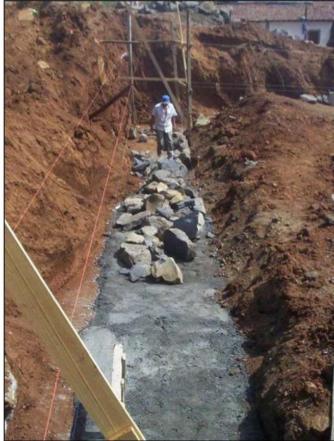
*En la foto superior podemos ver la colocación de la primera capa del muro de mampostería y en la foto inferior se ve el muro ya terminado.*
