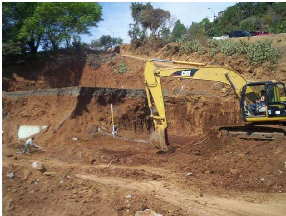
*Se pueden observar la magnitud de los cortes realizados sobre la plataforma 5 para la construcción del muro de contención, así como los trabajos de nivelación del terreno para la construcción de la plataforma 7.*
