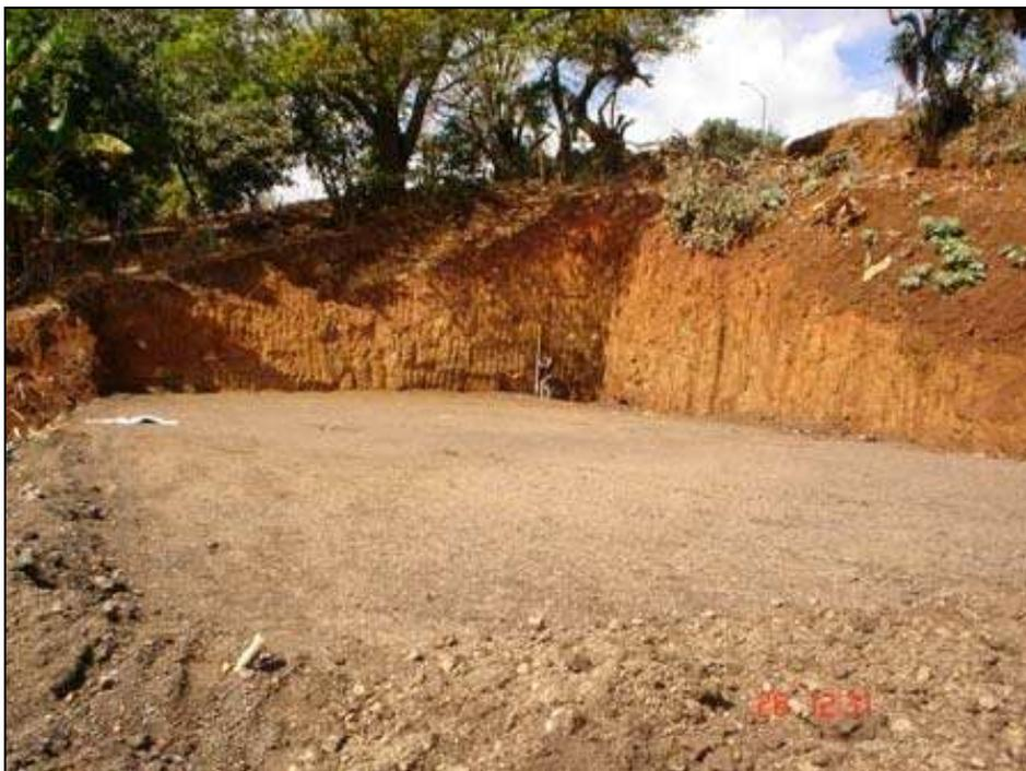
*Se puede ver el material de base ya tendido y compactado, en la parte trasera de la foto podemos ver a un trabajador con el estadal ya que se estaban revisando los niveles de la plataforma 5.*
