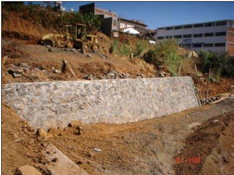
El muro de contención de la plataforma 5 fue el muro de dimensiones más grandes de todos los construidos, ya que iba a recibir el peso tanto de la plataforma 5 como del edificio académico. El muro tenía por lo menos 3 metros de altura y 2.5 metros de base.
