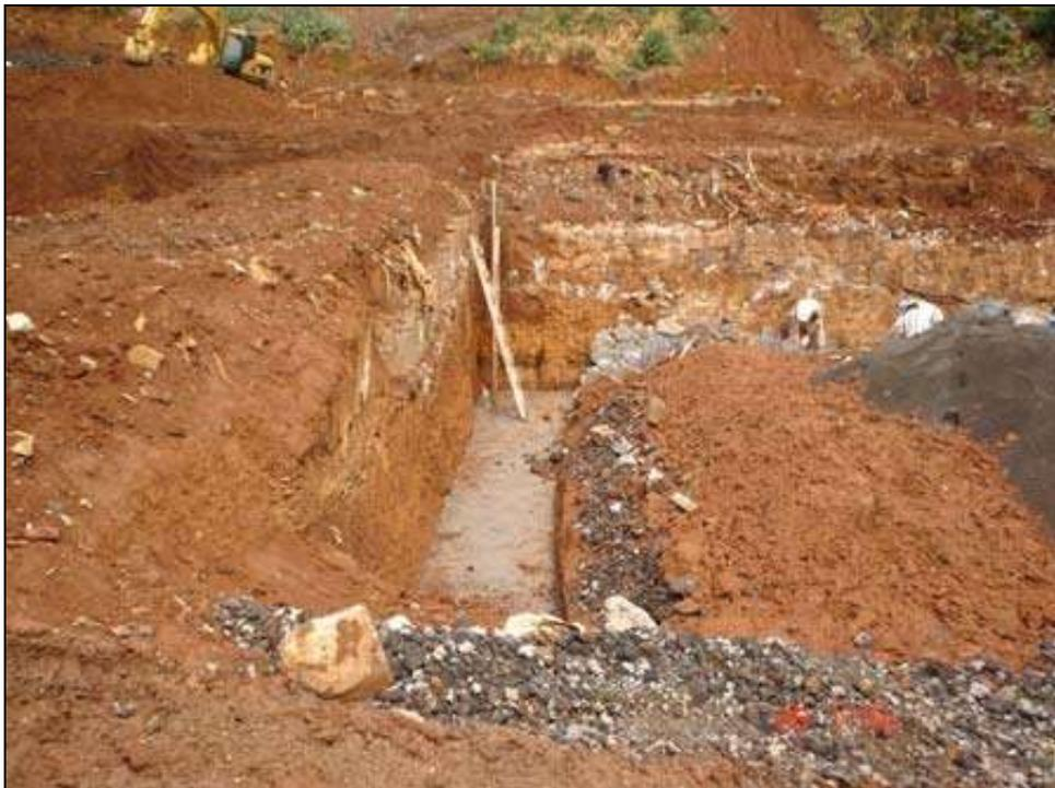
*Se puede observar la excavación para el muro de contención, así como la cama de concreto pobre que se coloca en el terreno natural.*
