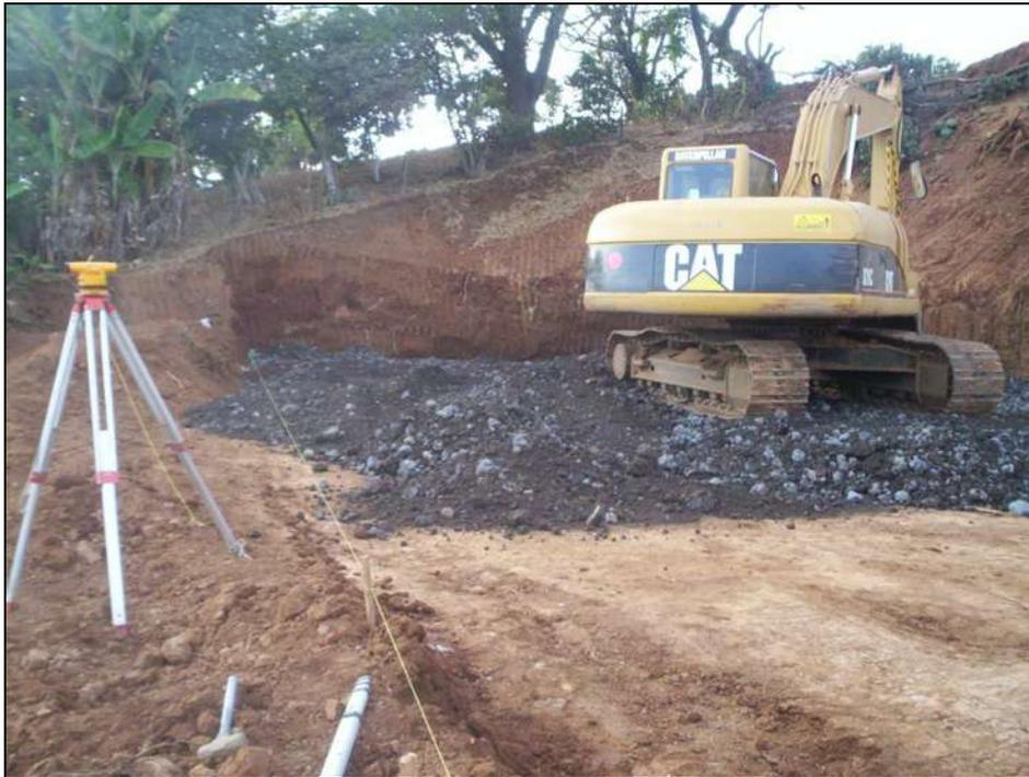
*Podemos observar a la excavadora realizando los trabajos de acomodo del filtro sobre toda la plataforma 5.*
