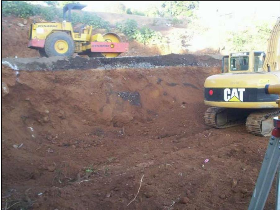
*En la foto se observa el material de la orilla de la plataforma 5 que se iba cayendo debido a las excavaciones para el muro de contención.*
