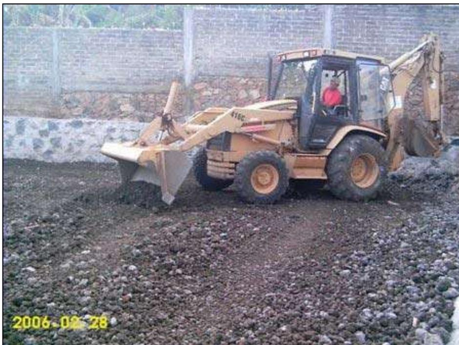
*Se observa a la retroexcavadora haciendo el tendido del filtro sobre la plataforma 6.*
