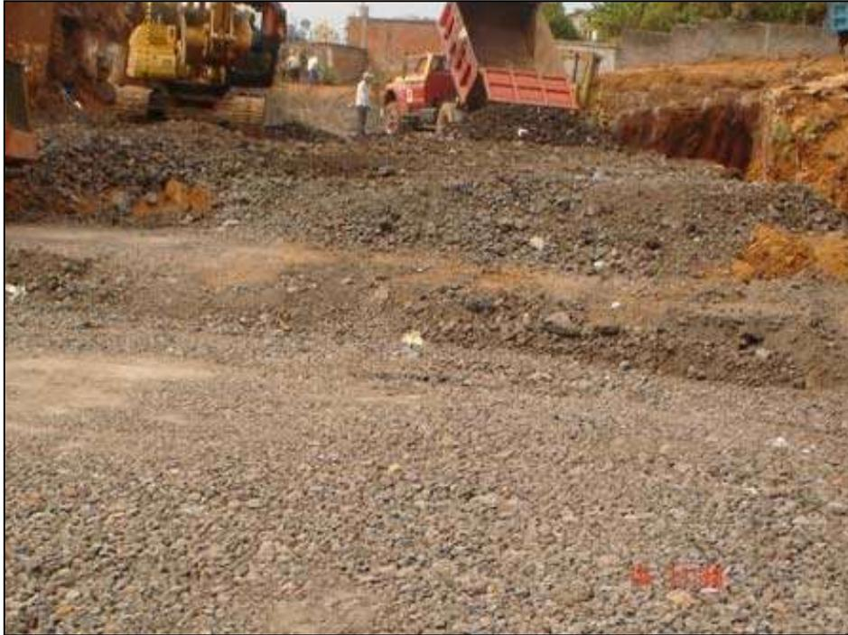
*En la foto podemos ver al fondo un camión de volteo realizando un tiro de filtro sobre la plataforma 3, así como las plataformas 1 y 2 ya con filtro tendido y compactado.*
