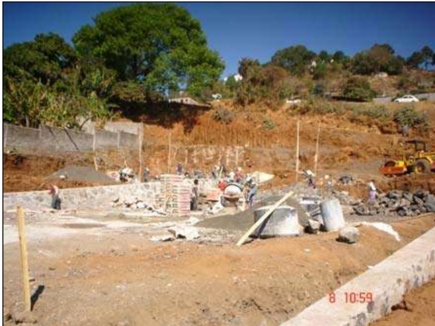
*En las fotos podemos ver los materiales empleados para la construcción de los muros (piedra, cemento, arena y agua), así como la revolvedora para realizar la mezcla.*
