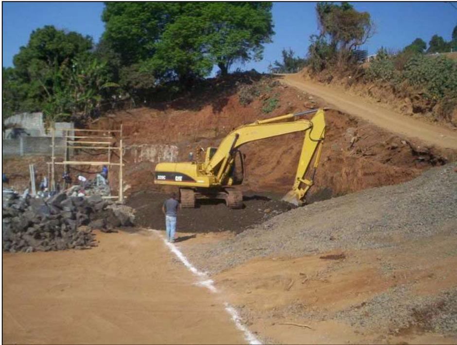
*Podemos ver a la excavadora tendiendo el filtro sobre lo que será la plataforma 5, a un costado se puede ver la piedra que formara el muro de contención.*
