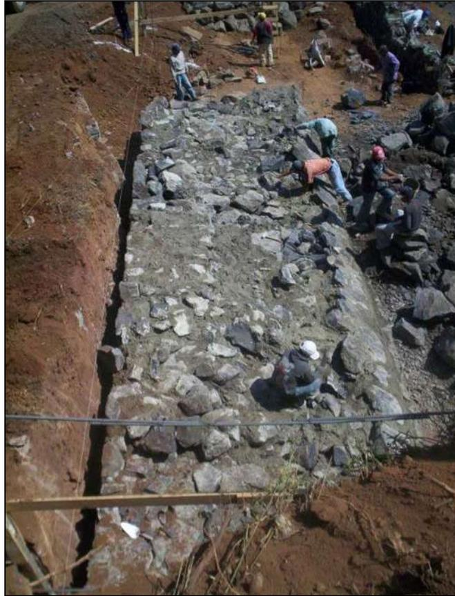
*En las imágenes podemos ver la colocación de las piedras y el avance de los trabajos en la construcción del muro de contención.*
