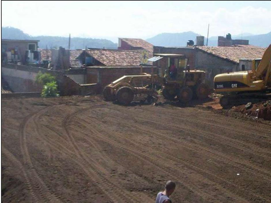
*Podemos ver a la motoconformadora nivelando el material de base en la plataforma 4.*
