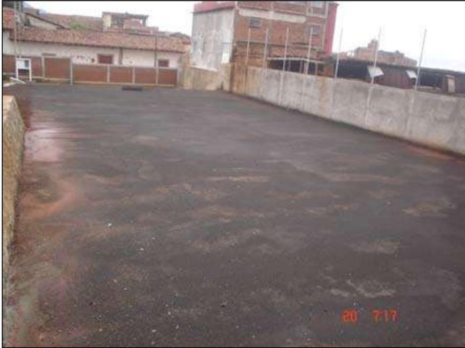
*Se observa el poreo que se realizo en la plataforma 3 para proteger la emulsión asfáltica.*
