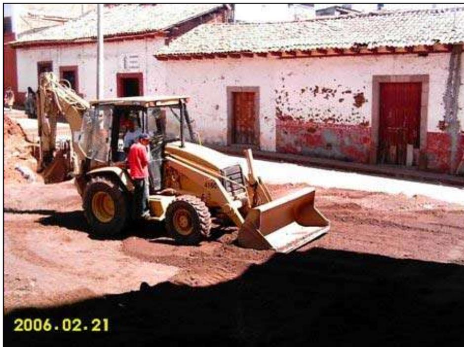
*En la foto podemos ver a la retroexcavadora realizando el tendido del material de base en la plataforma 1.*
