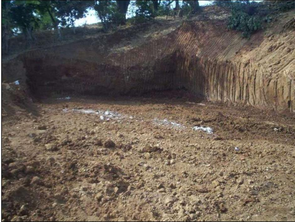
*Se pueden observar los cortes que se realizaron para dejar a piso la plataforma 5, sobre todo en la parte de atrás de la foto.*
