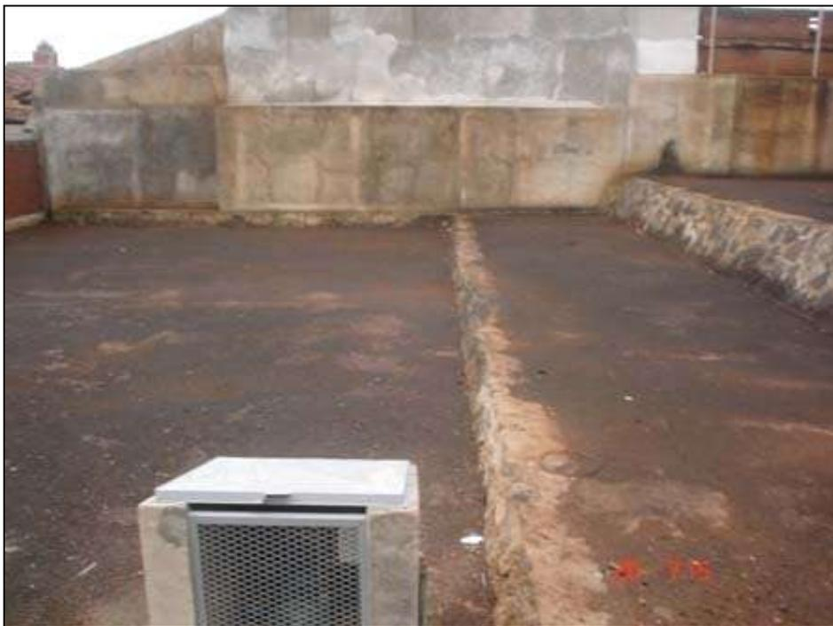
*En la foto se observan las plataformas 1 y 2, ya impregnadas y con los muros de contención ya terminados*
