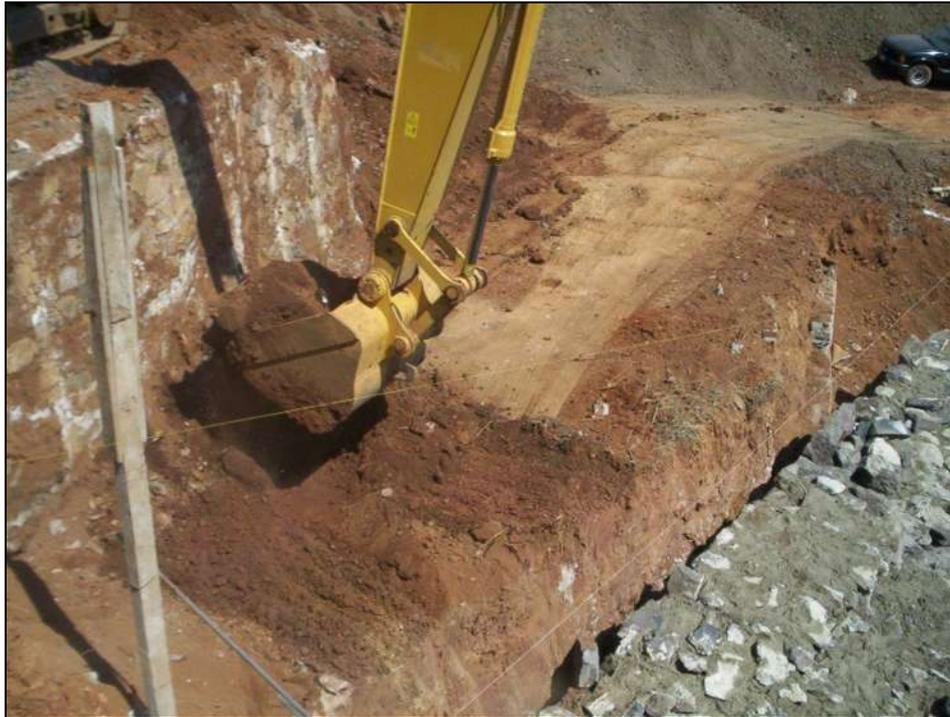
*En la foto podemos observar los trabajos que realizó la excavadora sobre el terreno natural para recibir al muro.*
