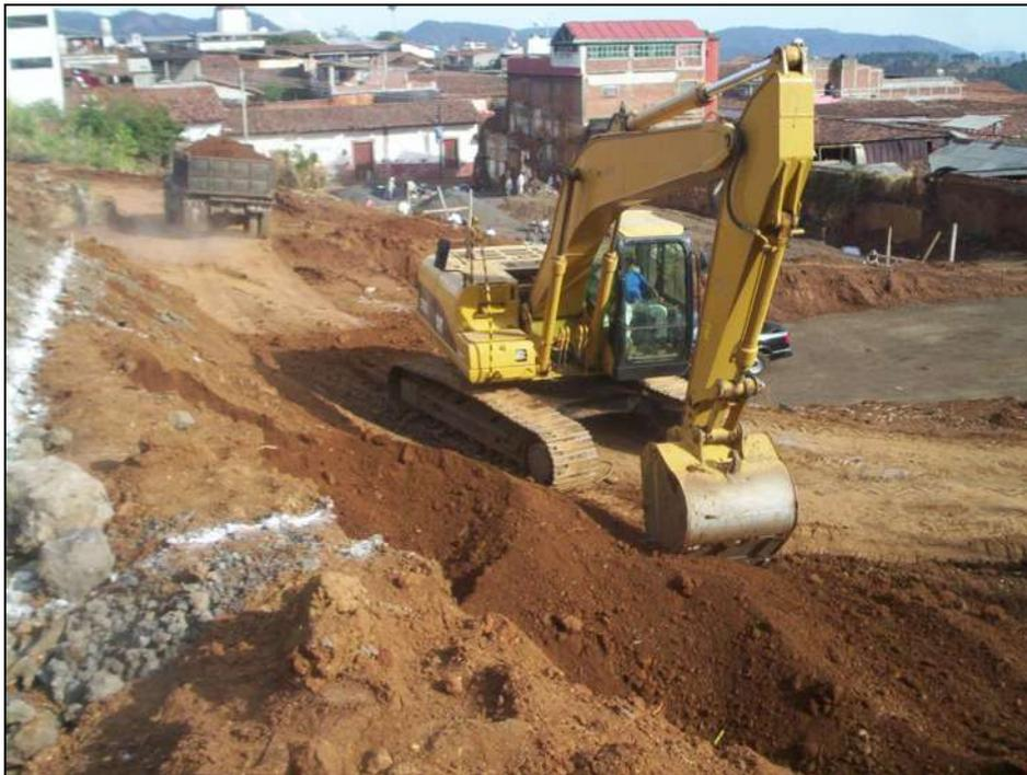
*En la foto podemos ver los primeros trabajos de excavación tanto para el muro de contención de la plataforma 5 como para la plataforma 6.*
