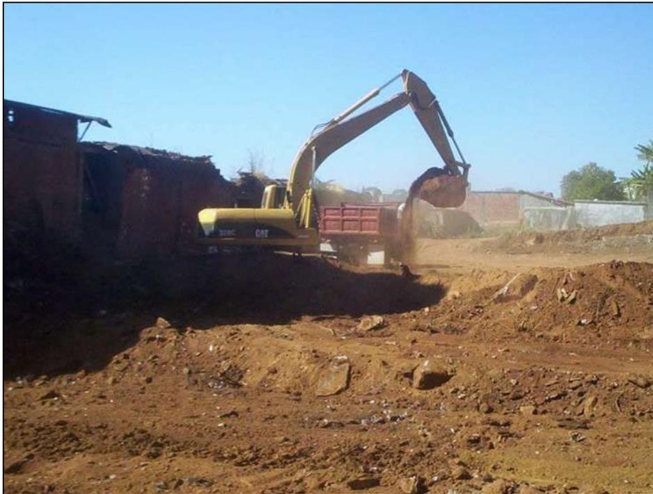
*En la foto vemos como la excavadora vacía el material producto de corte de la plataforma 3 para que sea llevado al tiradero en un camión de volteo.*
