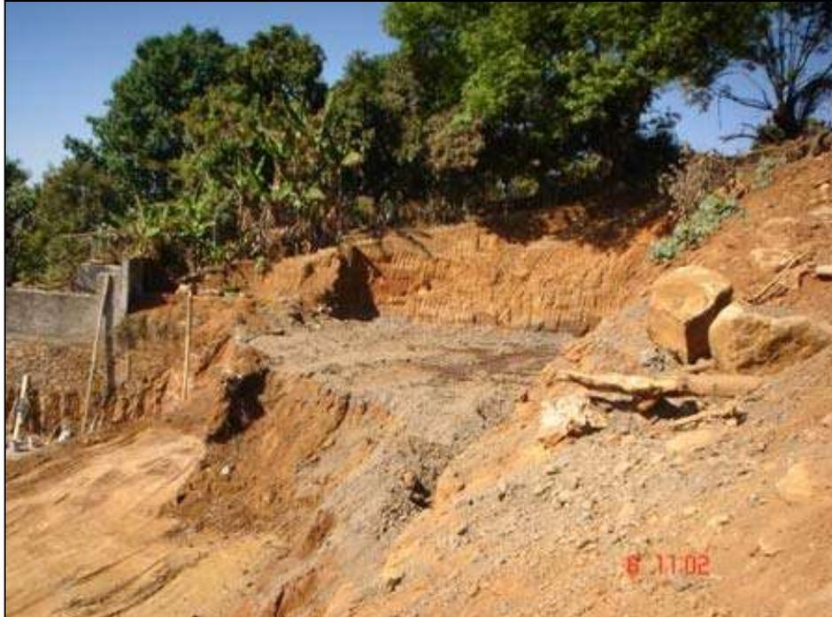
*En la foto podemos ver como iba quedando la plataforma 5 después de haber realizado algunas excavaciones para el muro de contención.*
