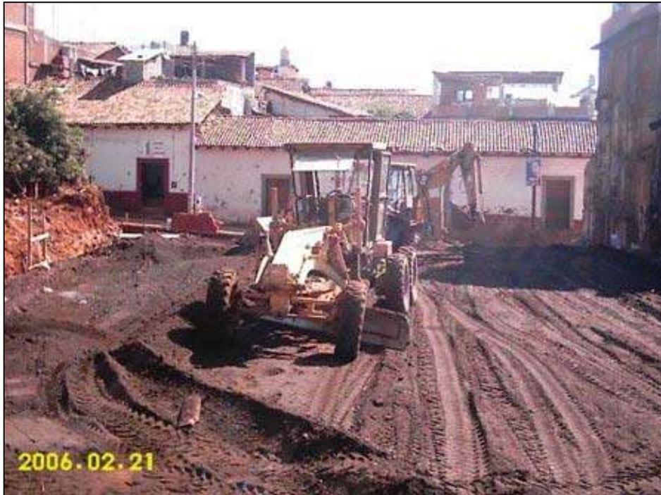
*En la imagen podemos observar a la motoconformadora tendiendo la base sobre la plataforma 3.*
