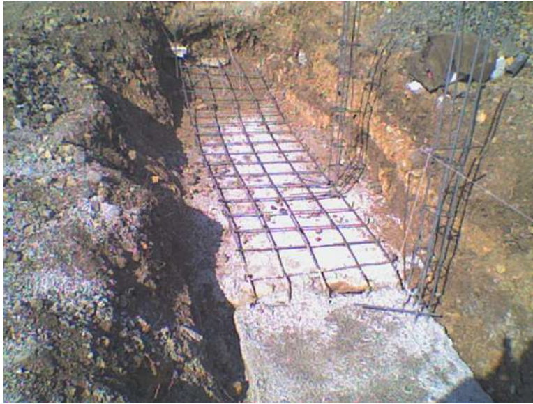
Vaciado de concreto
