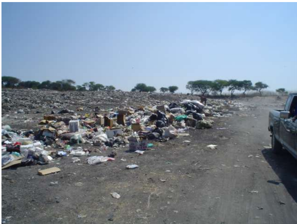
OPERACIÓN ACTUAL DEL SITIO DE DISPOSICION FINAL
