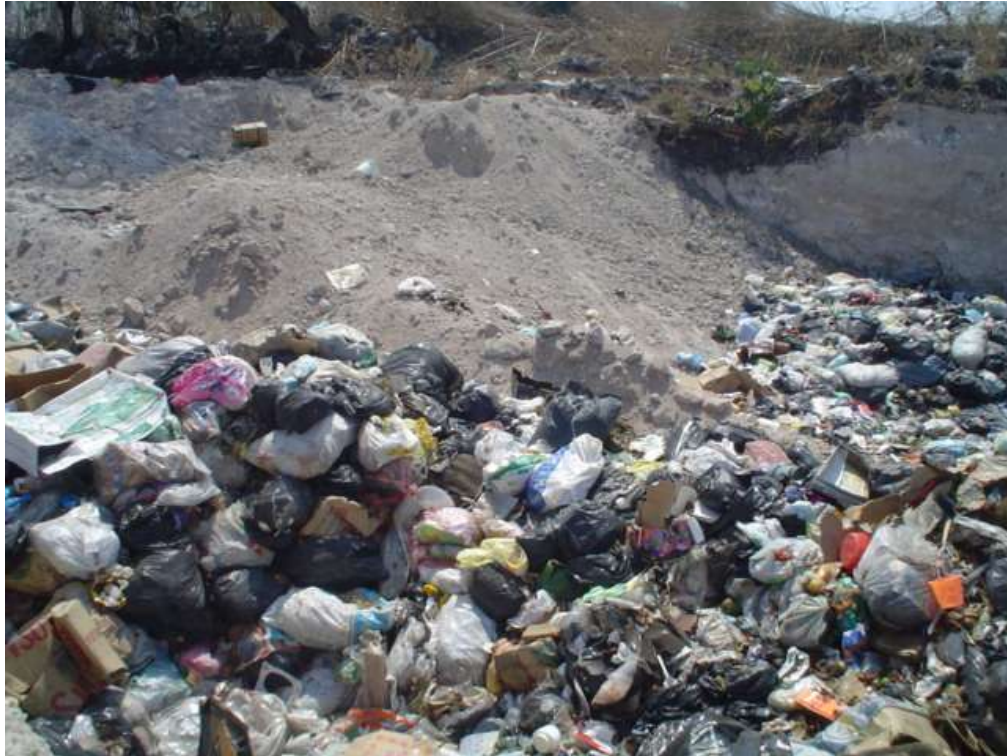
CUBIERTA DE LA BASURA CON MATERIAL DE LA EXCAVACION
