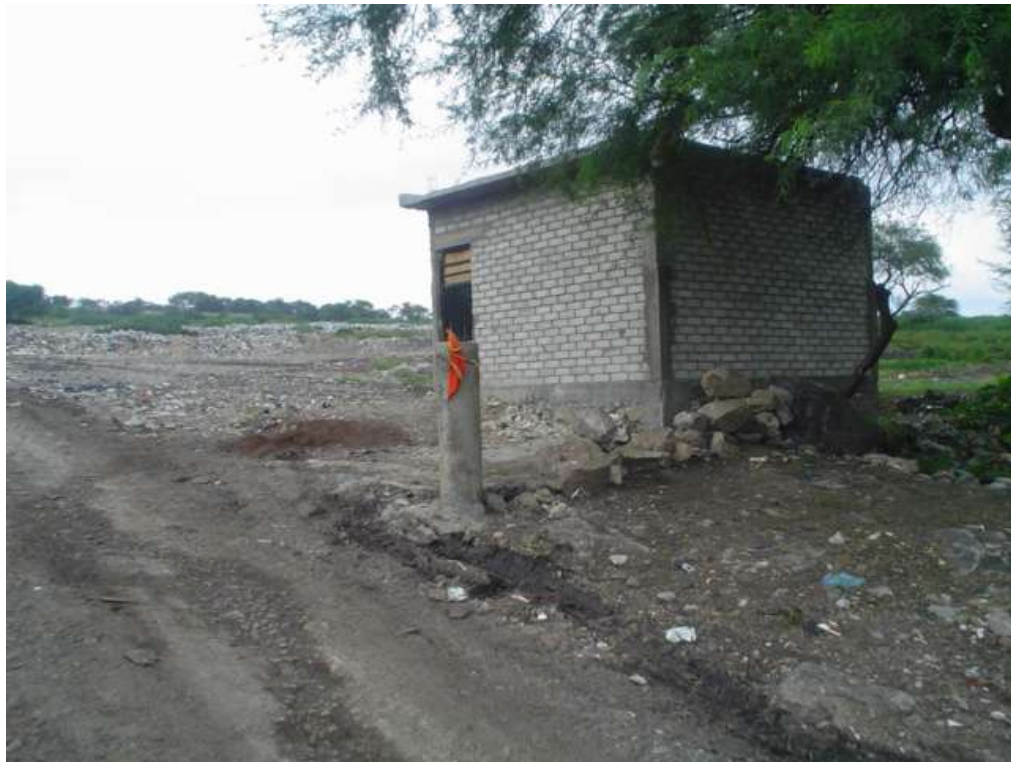
CASETA DE VIGILANCIA
