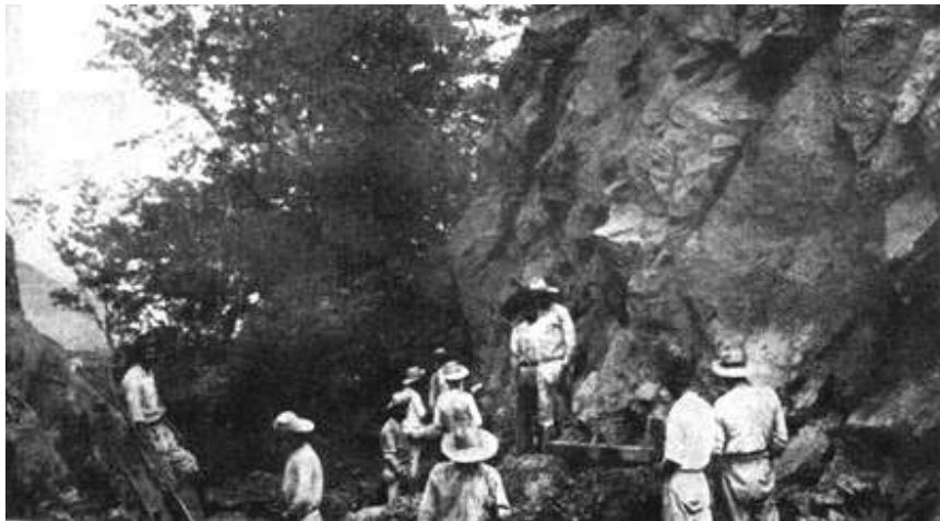
Figura 4. Excavación a mano por un paso para una carretera.
