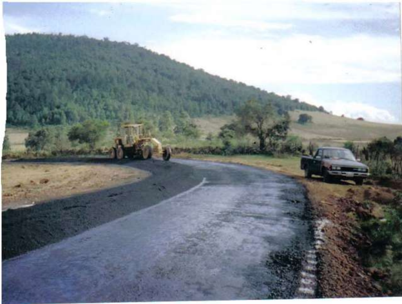
Figura 43.- Tendido de Carpeta.
