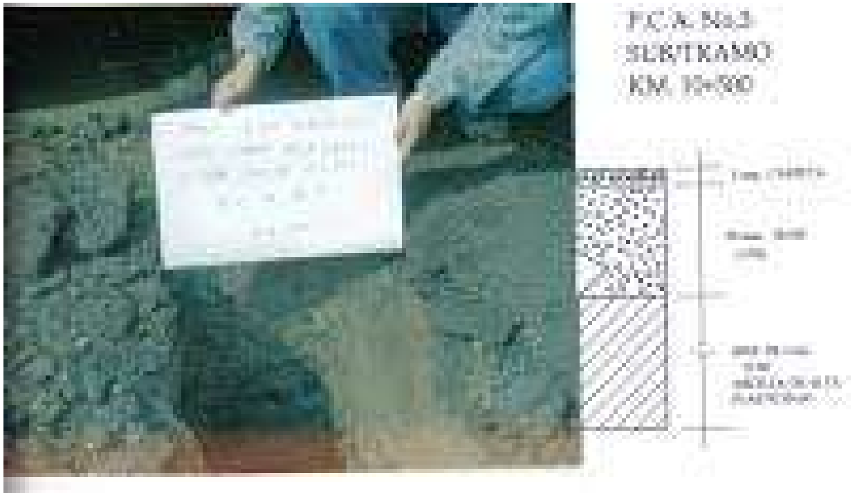
Figura 9.- Pozo a Cielo Abierto No.3
