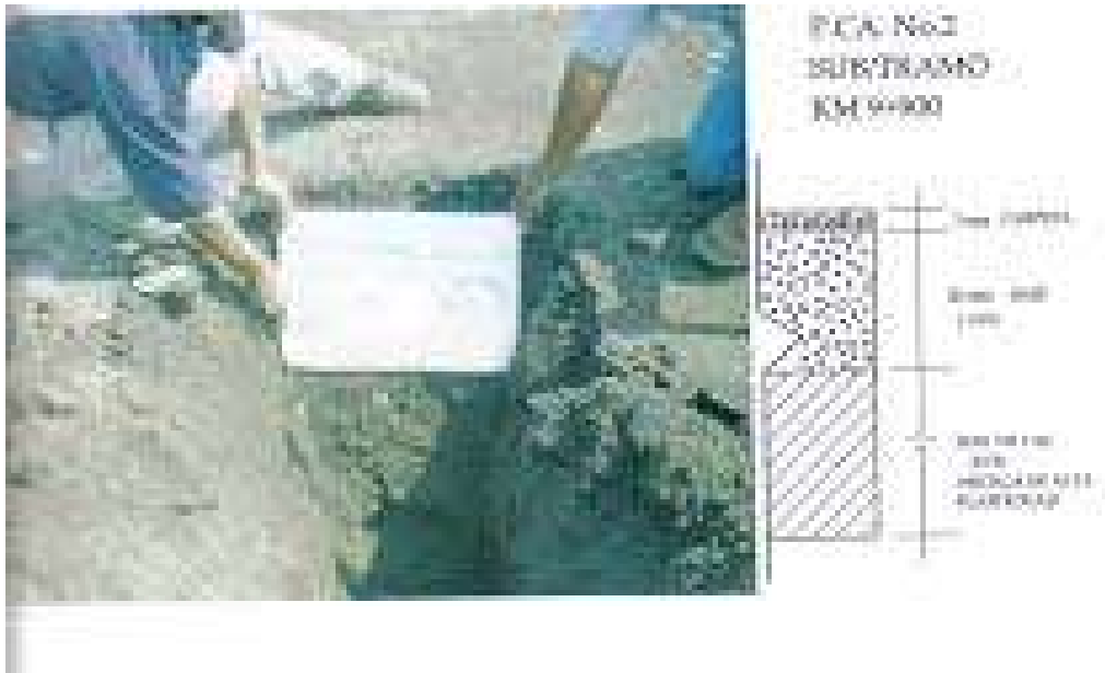
Fig. No. 8 Pozo a Cielo Abierto No. 2
