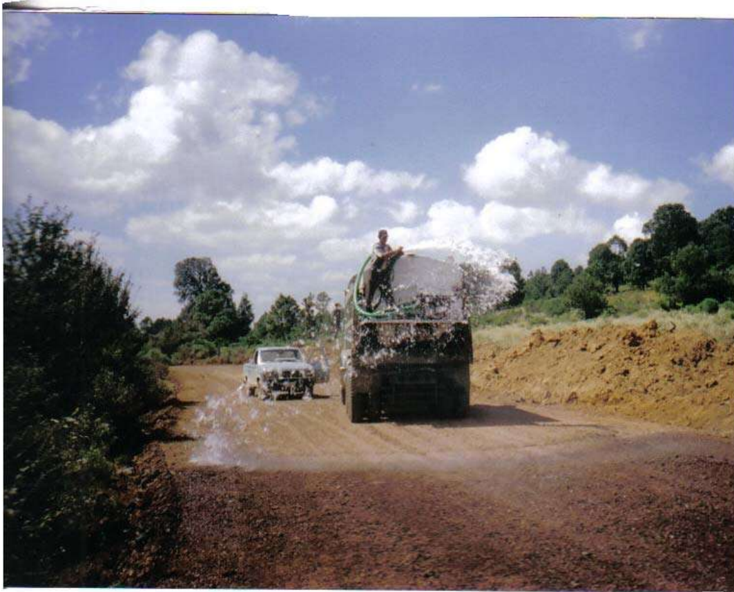
Figura 36.- Tendido de la base.
