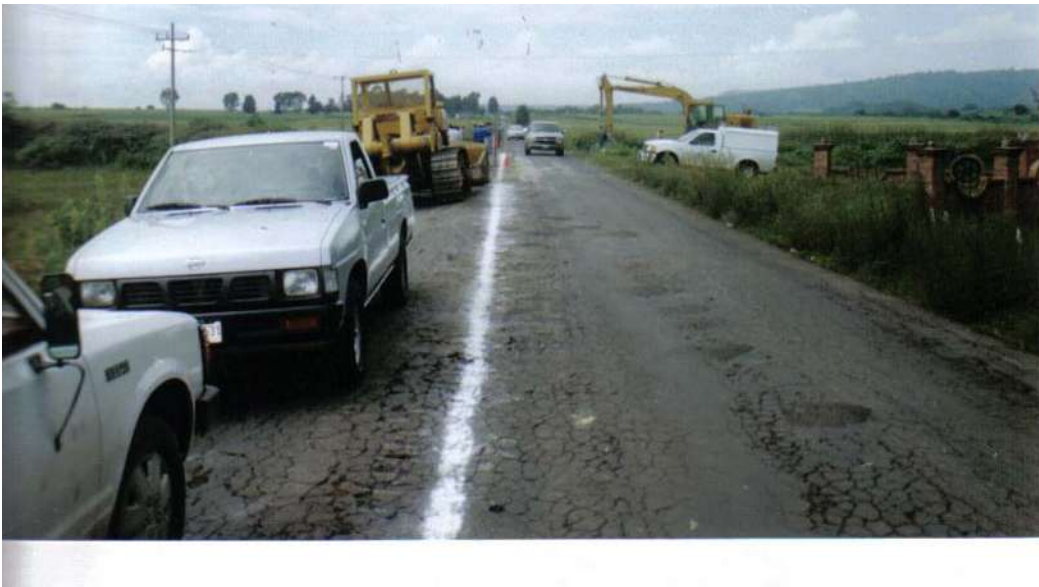
Figura 18.- Trazo e Inicio de la Excavación.
