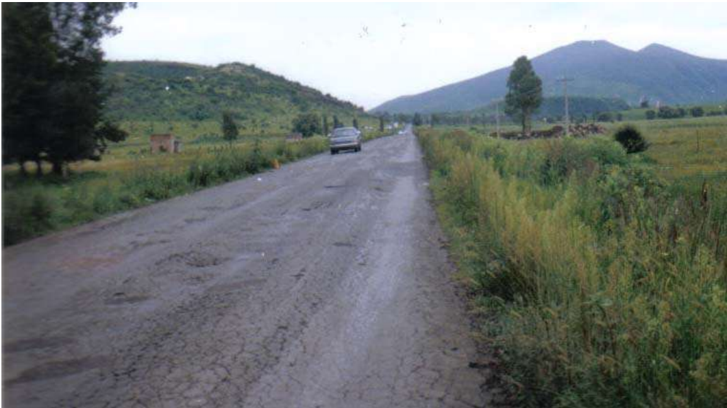
Figura.- 17 Tramo a Excavar.
