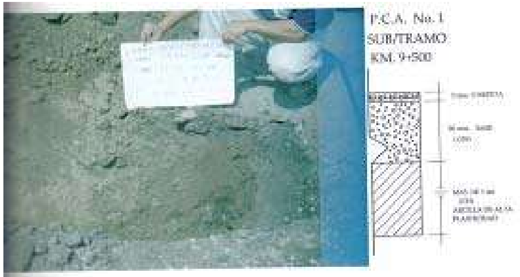
Fig. No.7 Pozo a Cielo Abierto No. 1
