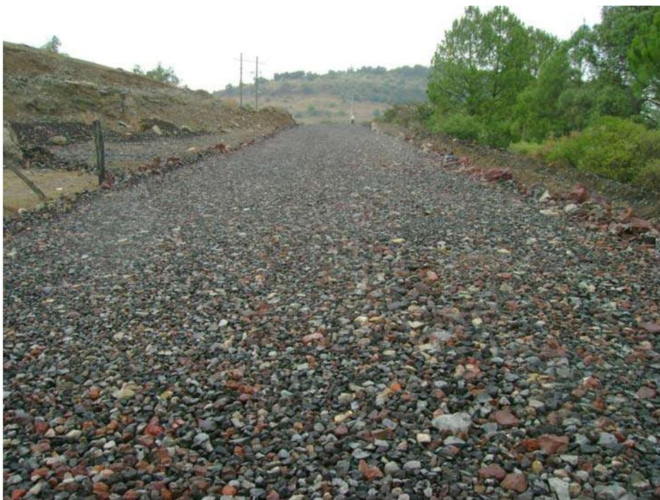
FOTO 5 Y 6 SUMINISTRO Y COLOCACION DE MATERIAL DE BANCO FILTRO PARA LA CAPA DE SUBBASE
