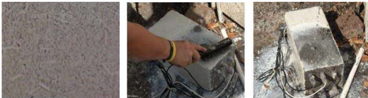
Proceso de remoción del recubrimiento acidificado.
