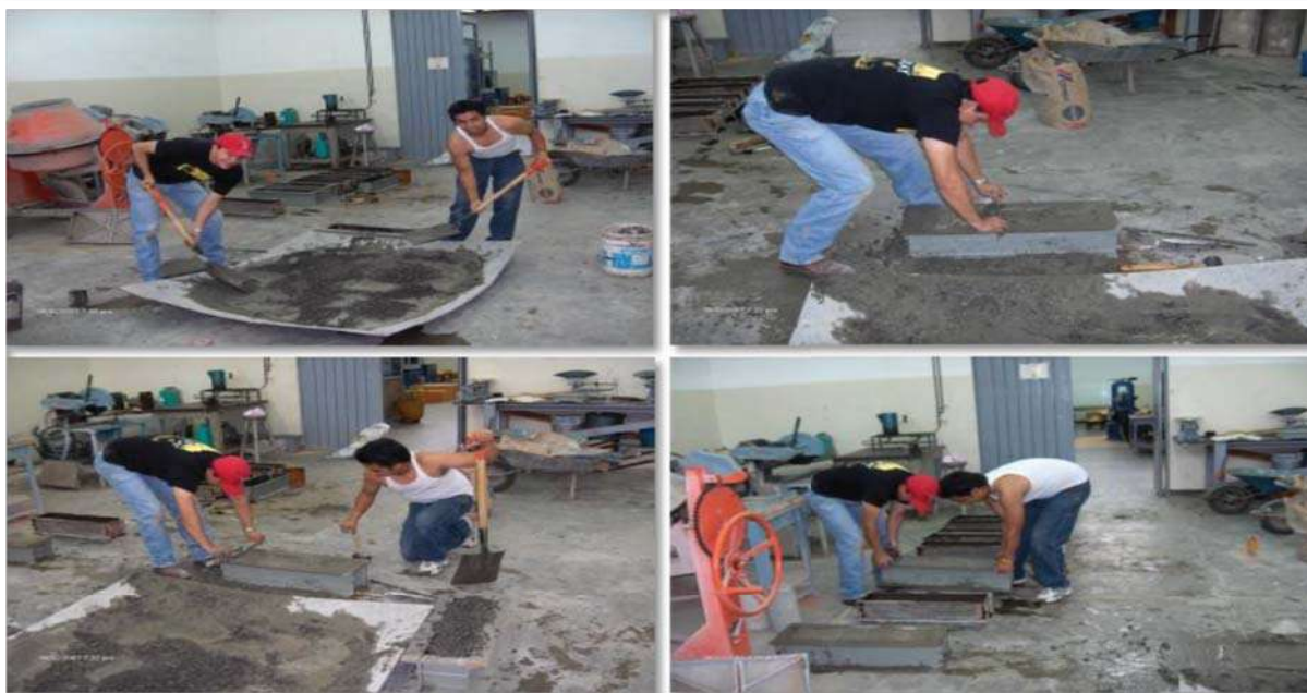
Colado de vigas
