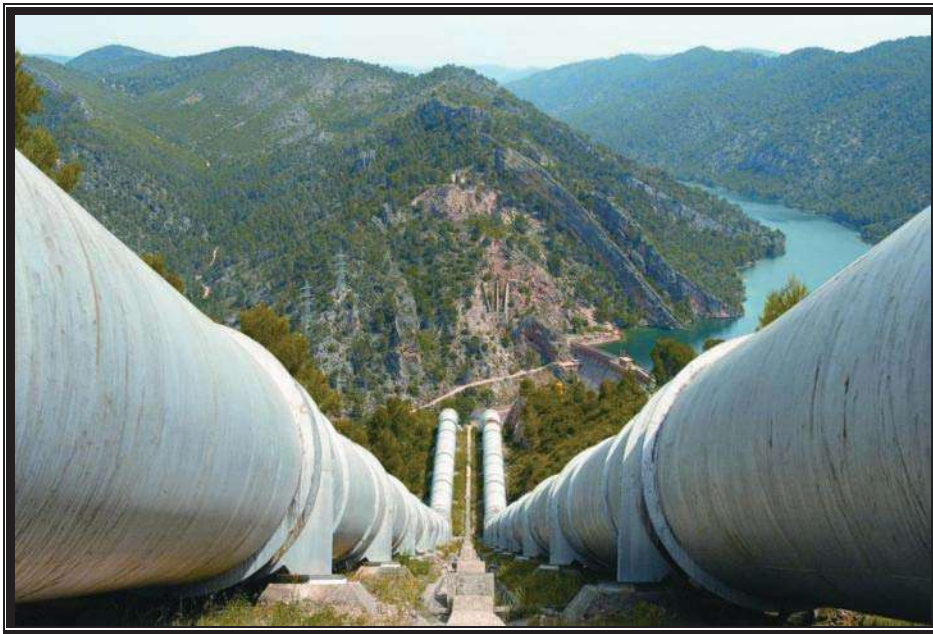
Figura 8. Ejemplo de una doble línea de conducción
