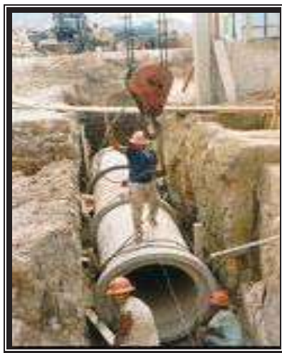
Figura 4. Instalación de tubería de concreto
