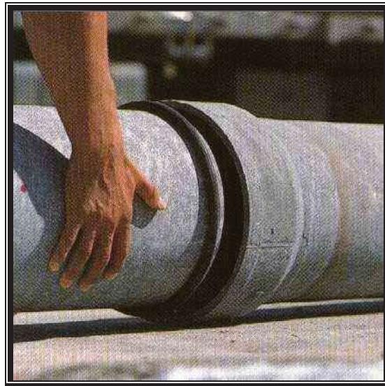
Figura 5. Instalación de tubería de asbesto-cemento (junta hermética)
