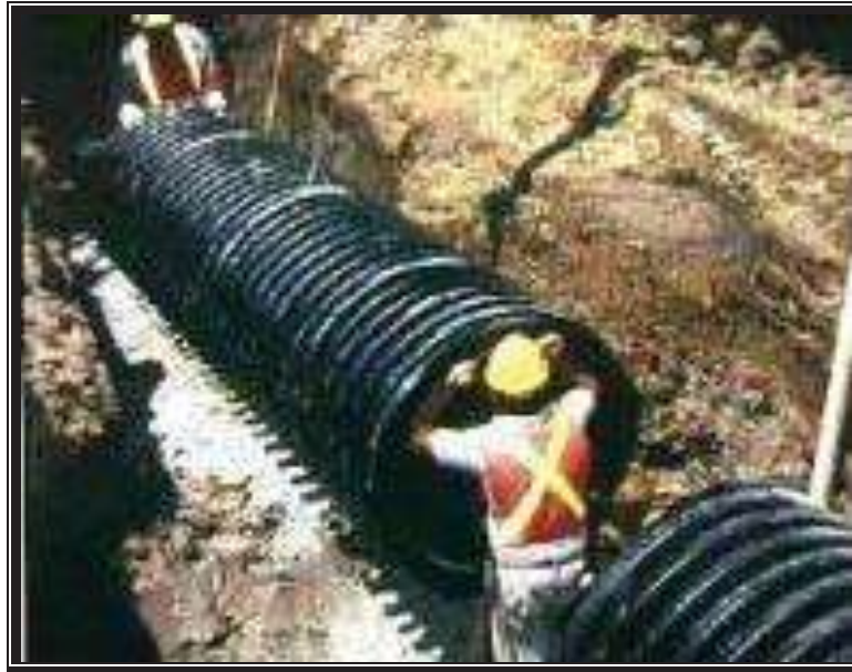
Figura 7. Implementación de tubería de polietileno en campo abierto
