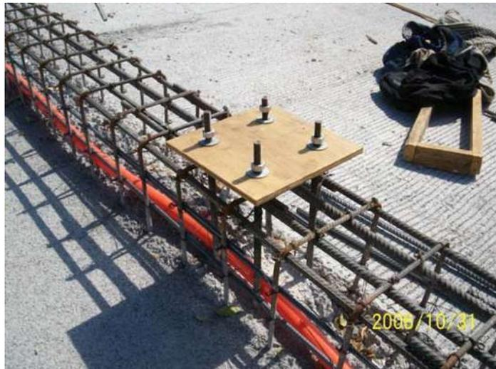
Foto 3: Anclas para sostener los postes del alumbrado publico sobre el Puente Vehicular.
