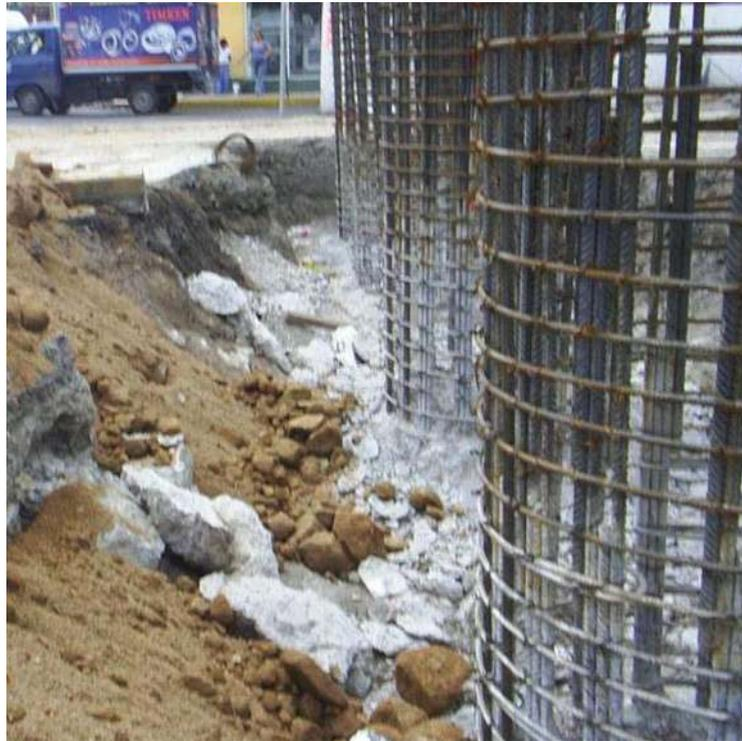
Foto 13: Pilas descabezadas para continuar con la construcción de las columnas.
