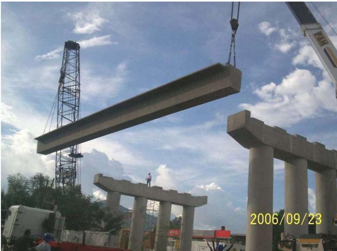
Foto 27. Montaje de traveses sobre el río entre ejes 7 y 8.
