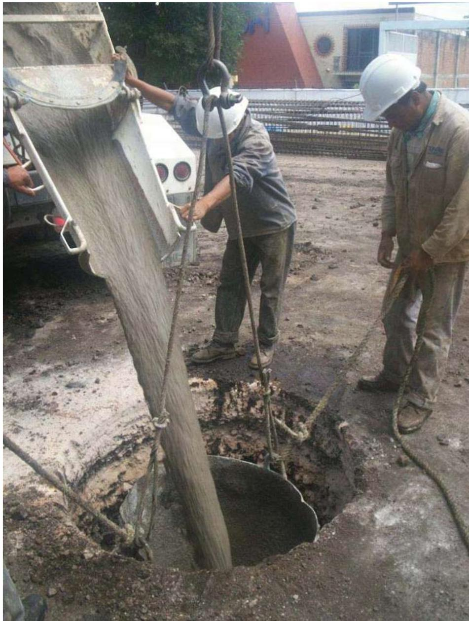
Foto 4: Suministro de fluido en perforación con problema de derrumbes.
