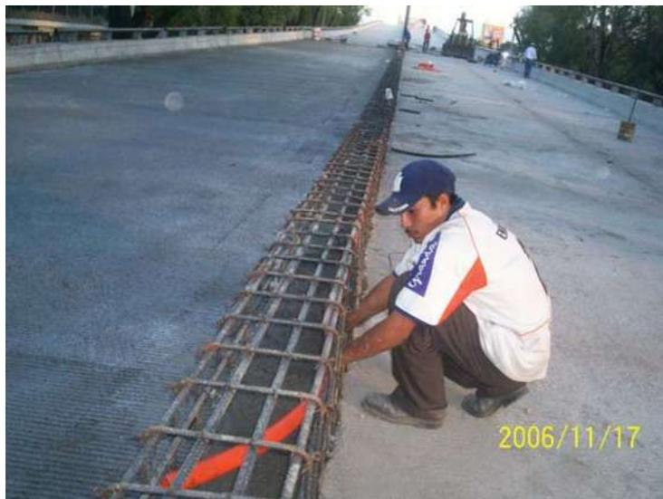
Foto 1. Instalación Eléctrica oculta en guarnición central.
