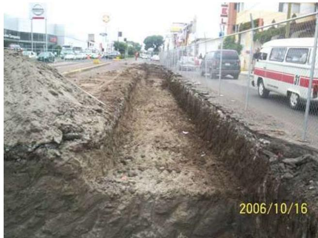
Foto 11: Zanja para plantilla de desplante de zapata.
