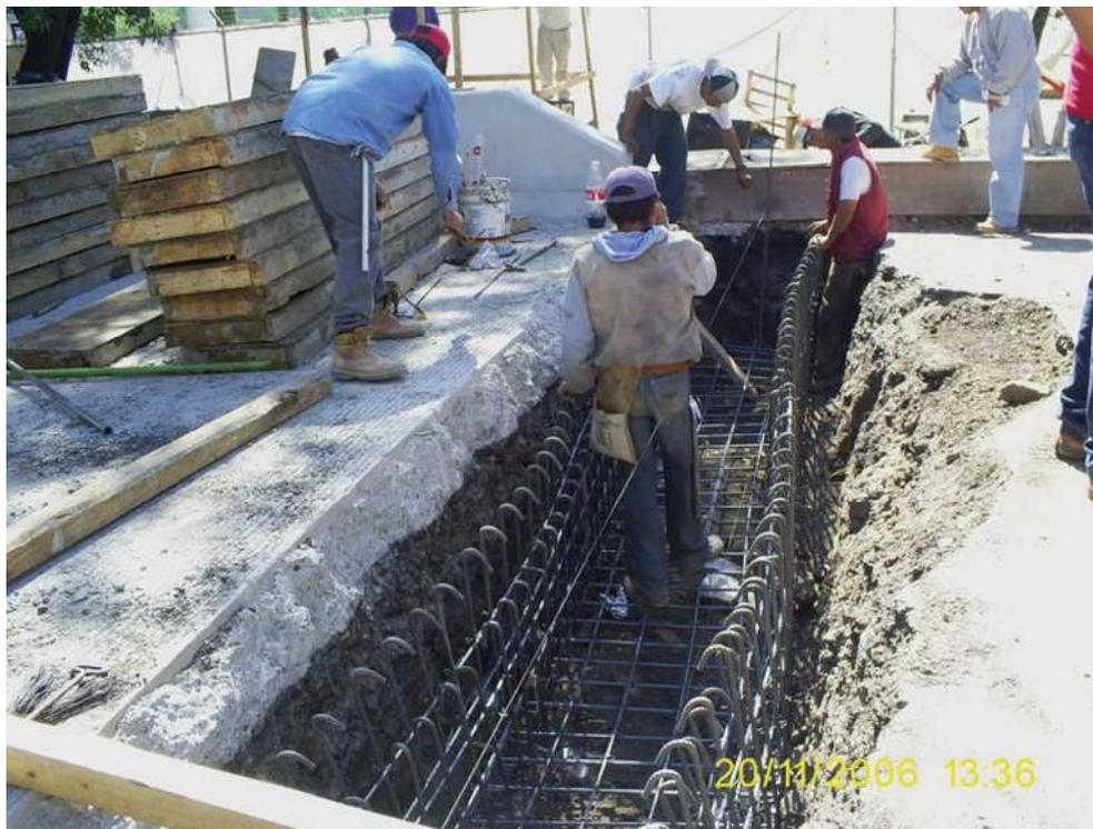
Foto 3: Preparación de zanja y acero de refuerzo para construcción de rejilla pluvial.
