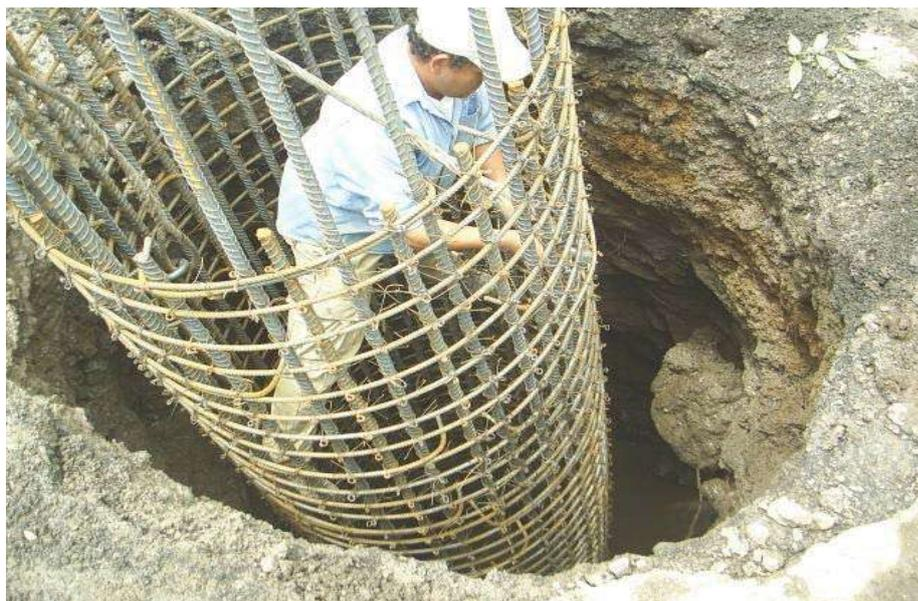
Foto 3: Colocación del acero de refuerzo en la perforación.
