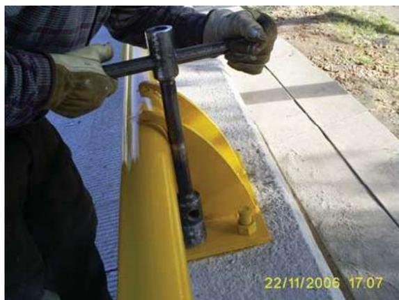
Foto 7: Sujeción de parapeto a las anclas con tuercas.
