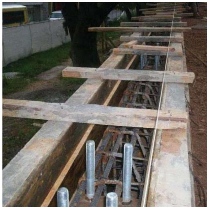
Foto 4: Guarnición lateral con placas para colocar parapeto y cimbra.
