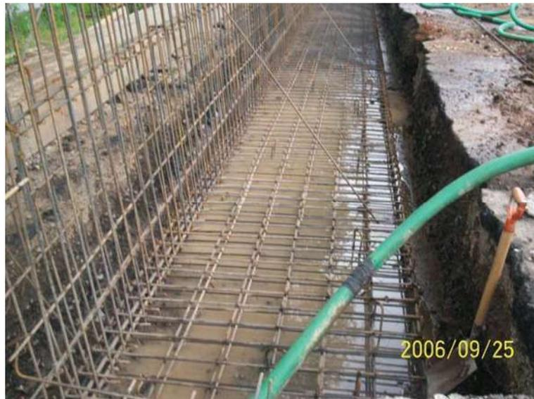
Foto 14: Extracción del agua en zanja para zapata.
