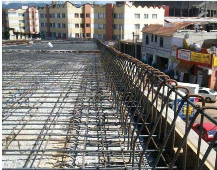
Foto 3: Acero de refuerzo vertical en guarnición lateral.
