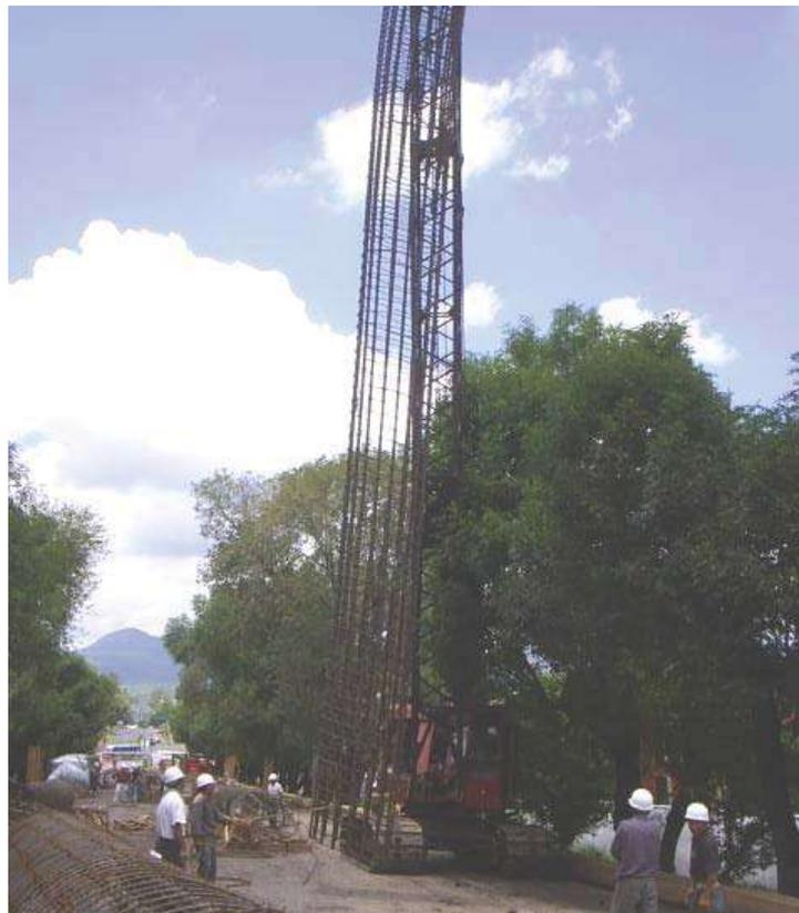
Foto 3: Maniobra de izado y colocación del armado de refuerzo para pilas.
