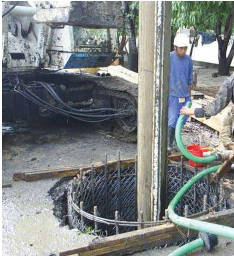
Foto 2: Ademe de varillas y malla ciclónica.
