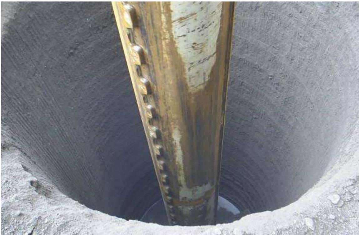
Foto 3: Perforación en mezcla fluida.
