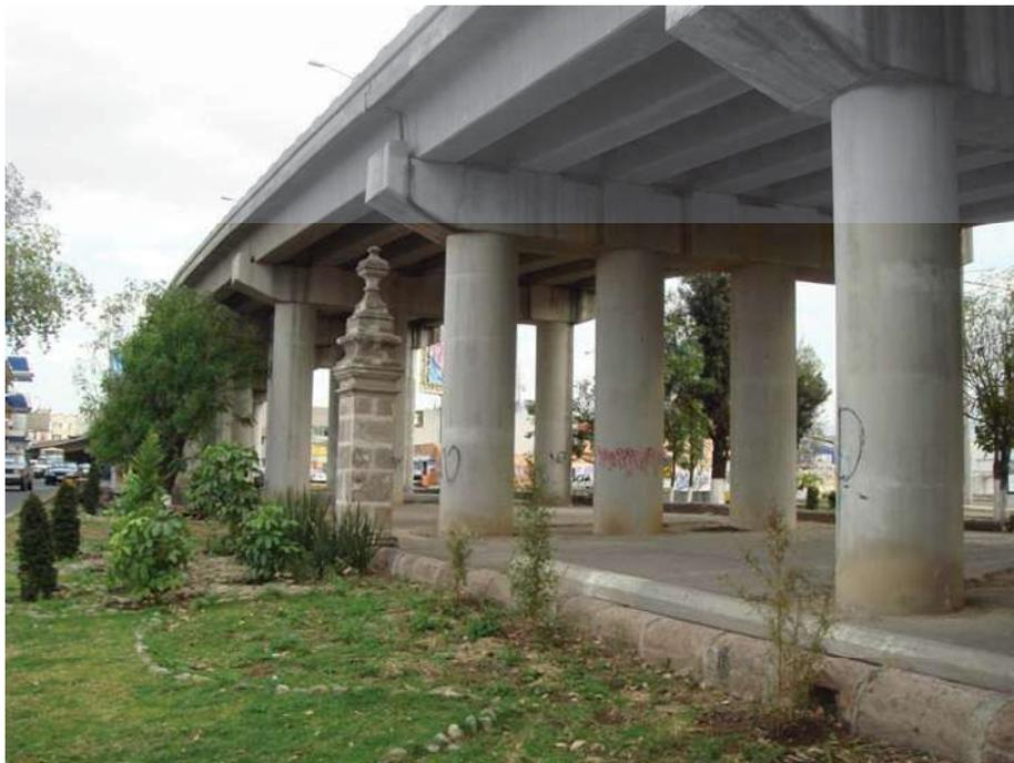
Foto 3: Elementos de cantera sin daños producidos durante la ejecución de la obra.
