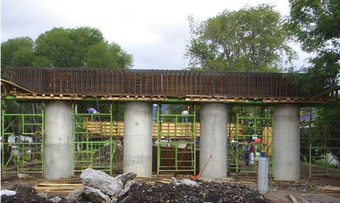
Foto 17. Acero de refuerzo y cimbra lateral en cabezales.
