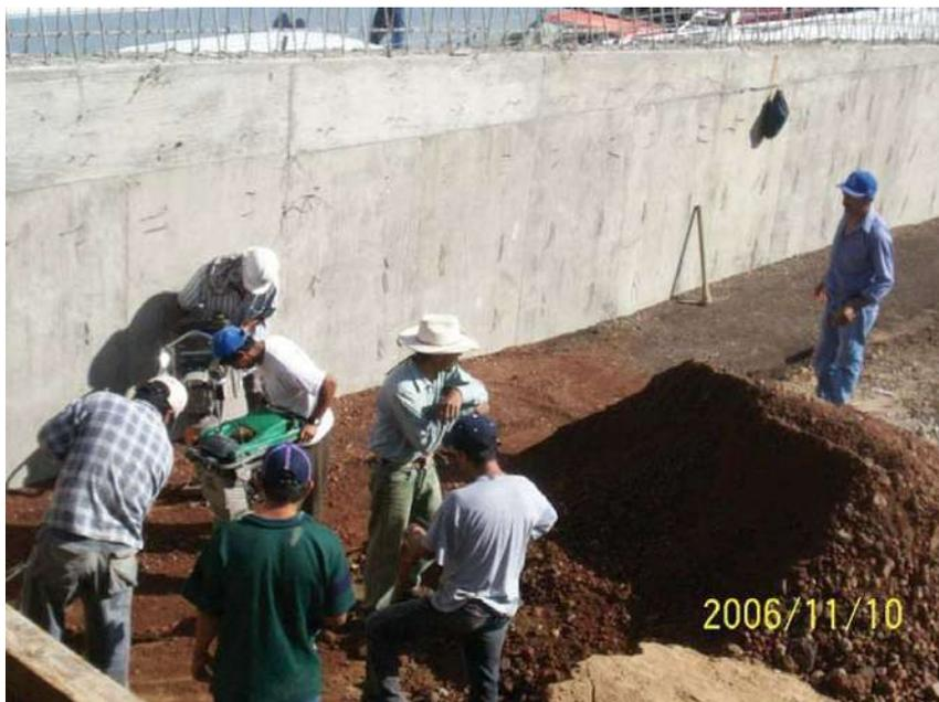
Foto 4: Relleno sobre zapata de muros, compactado con "bailarina".
