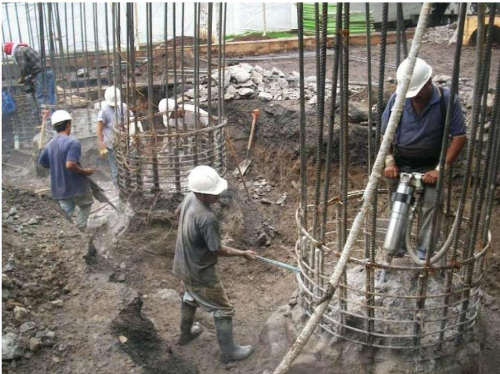
Foto 12: Descabece de pilas con "martillo hidráulico manual".
