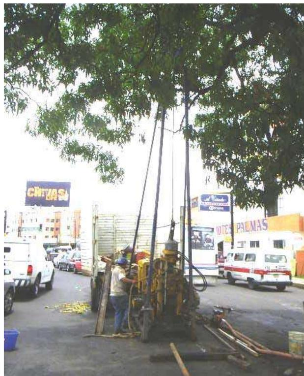
Foto 2: Instalación de maquina para realizar Sondeo.
