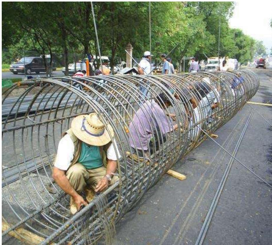
Foto 1: Habilitado del acero de refuerzo para pilas
