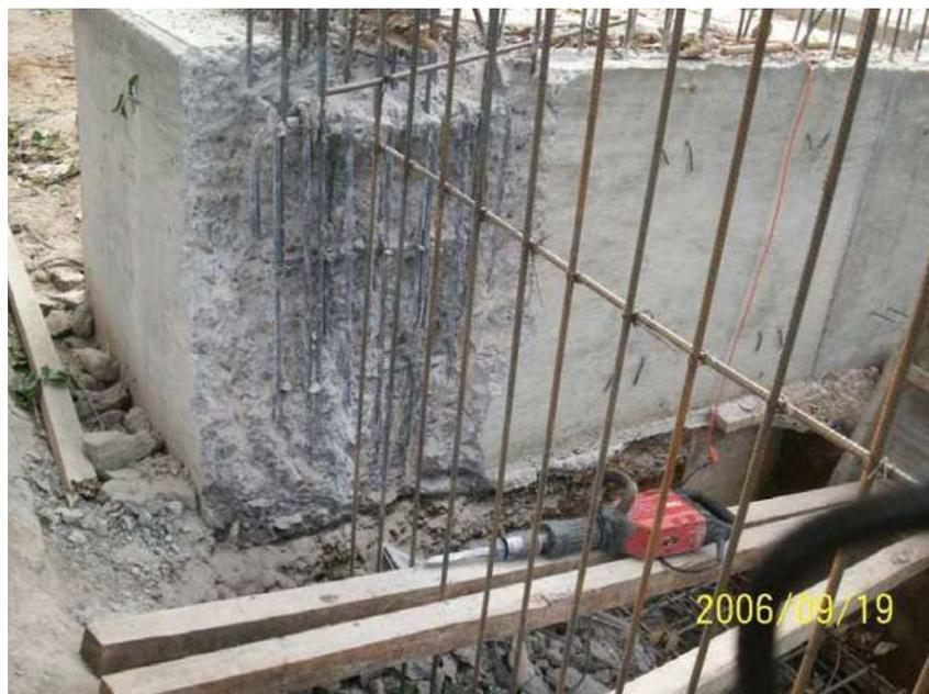
Foto 23. Demolición parcial del elemento para liga de muros de contención.
