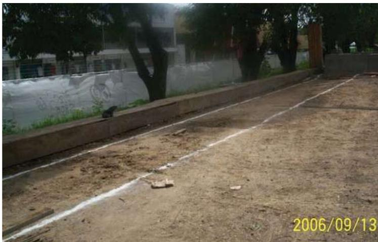
Foto 1: Trazo de la zapata sobre la calzada.
