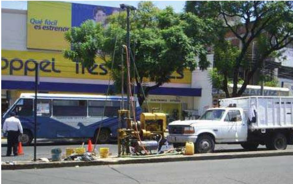
Foto 1: Realización de Sondeo con una maquina perforadora para determinar propiedades de los estratos.
