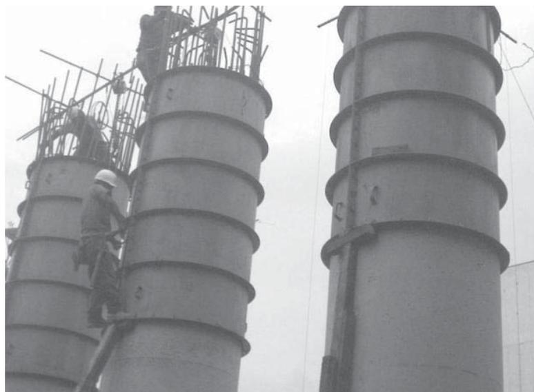
Foto 14: ajuste de cimbra deslizante con tornillos y puntales.
