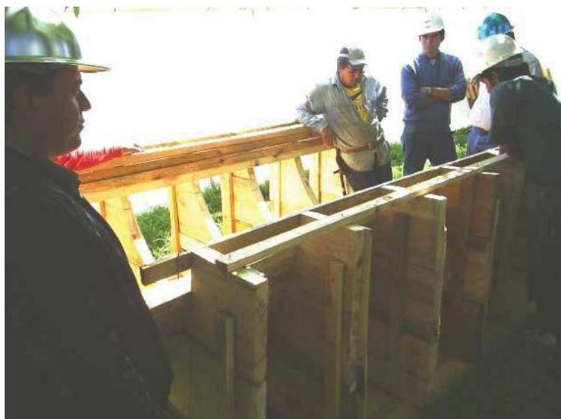
Foto 2: Construcción de cimbra de madera para colado de columnas.
