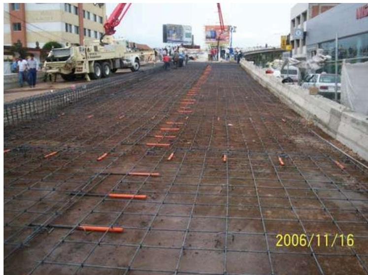
Foto 9: Preparación de parrillas y "pasa juntas" para colar losa.
