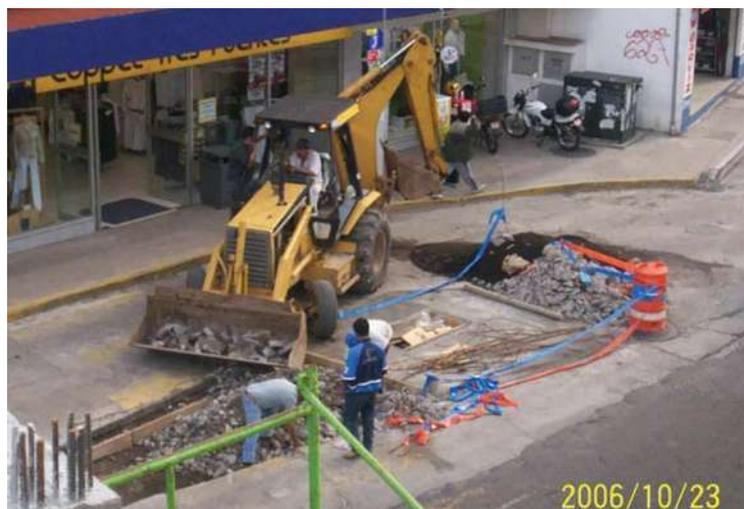
Foto 2: Retiro de material producto de demolición para ampliación.
