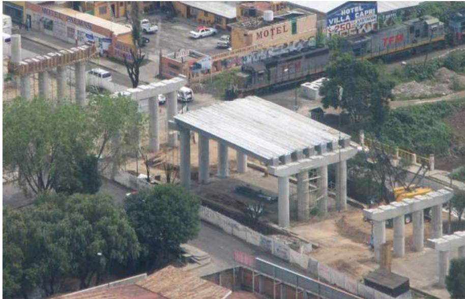
Foto 25: Claros de 7 traves montadas y grúa sobre rampa de material de banco (tepetate).
