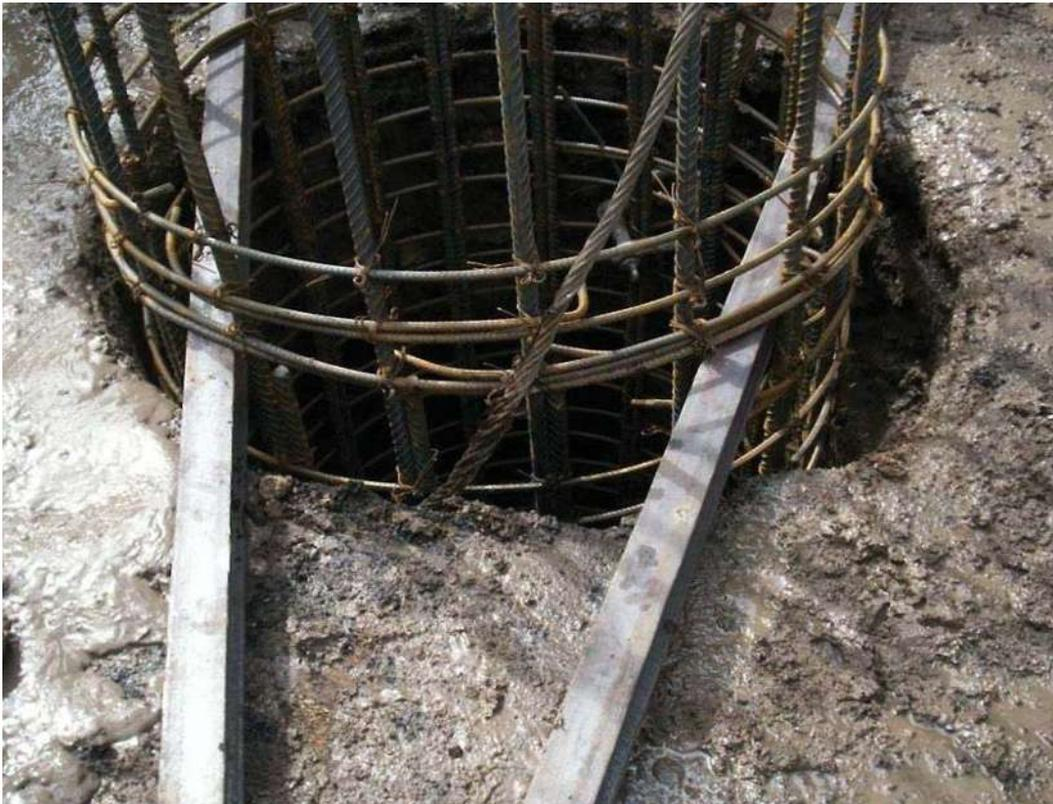
Foto 4: Acero sostenido en posición con vigas I.
