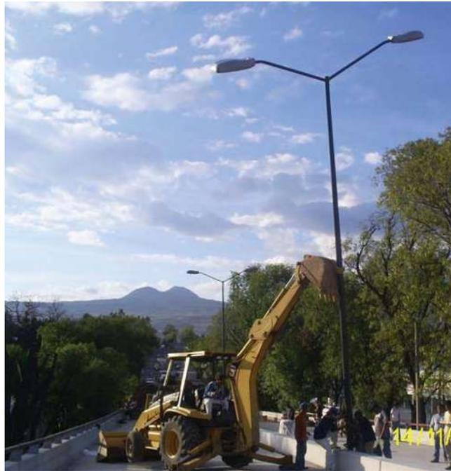
Foto 5. Maniobra de izado y colocación de luminarias.
