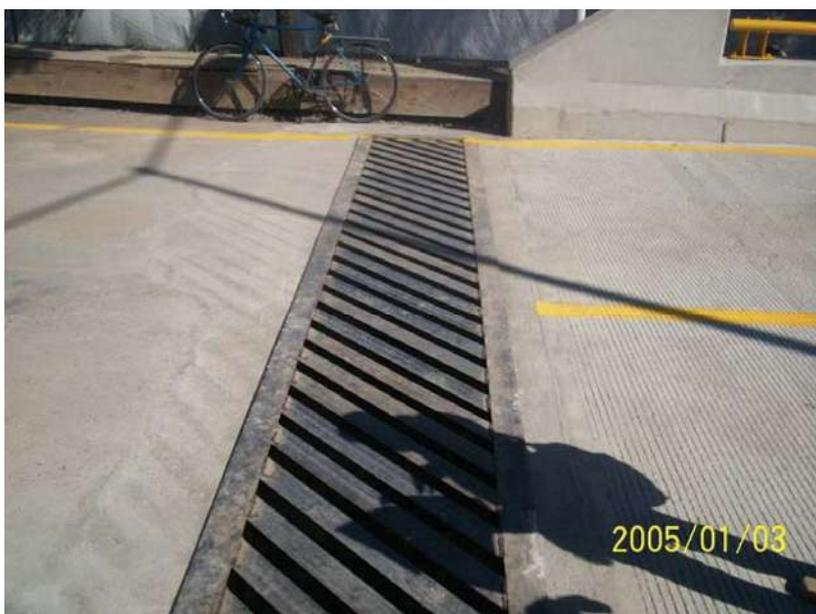
Foto 1: Rejilla pluvial en extremo poniente del paso a desnivel.
