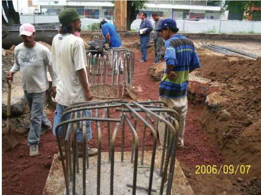
Foto 20. Construcción de plantilla compactada con material de banco.
