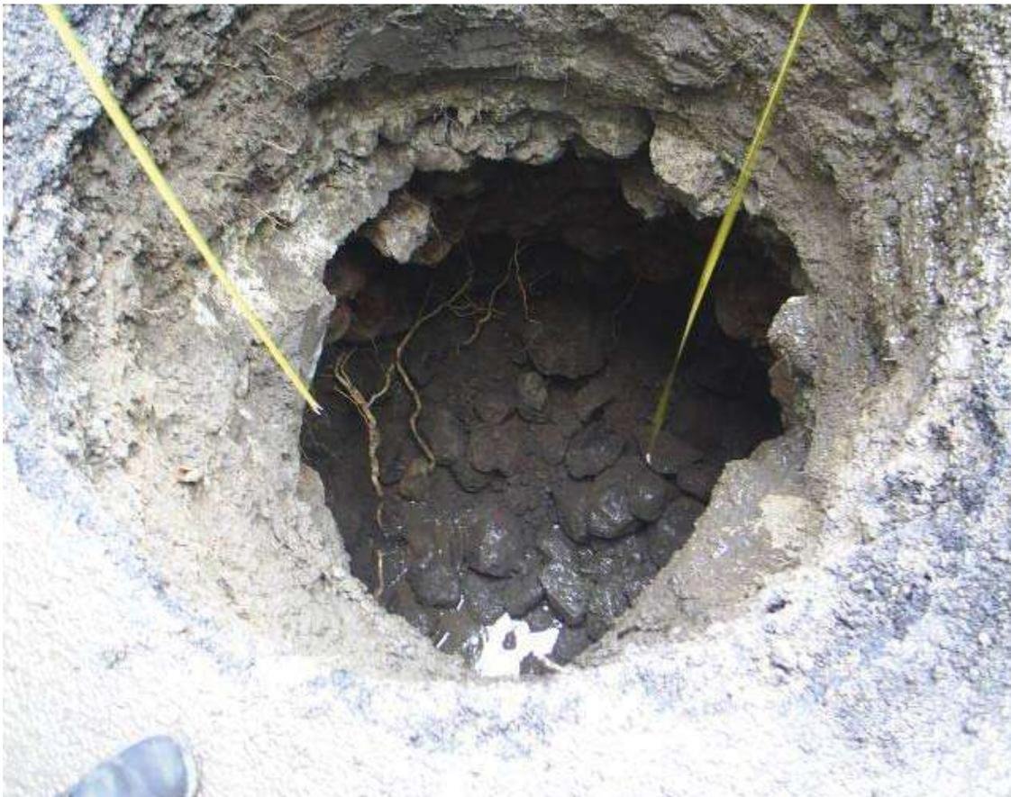
Foto 1: Derrumbes por inestabilidad en pedraplén o capa rompedora de capilaridad.
