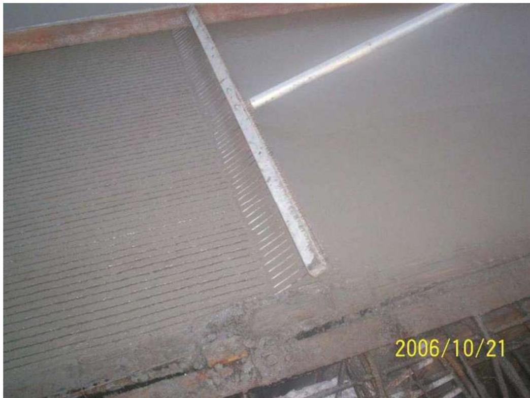
Foto 32: Terminado de superficie de rodamiento, rayada con peine.
