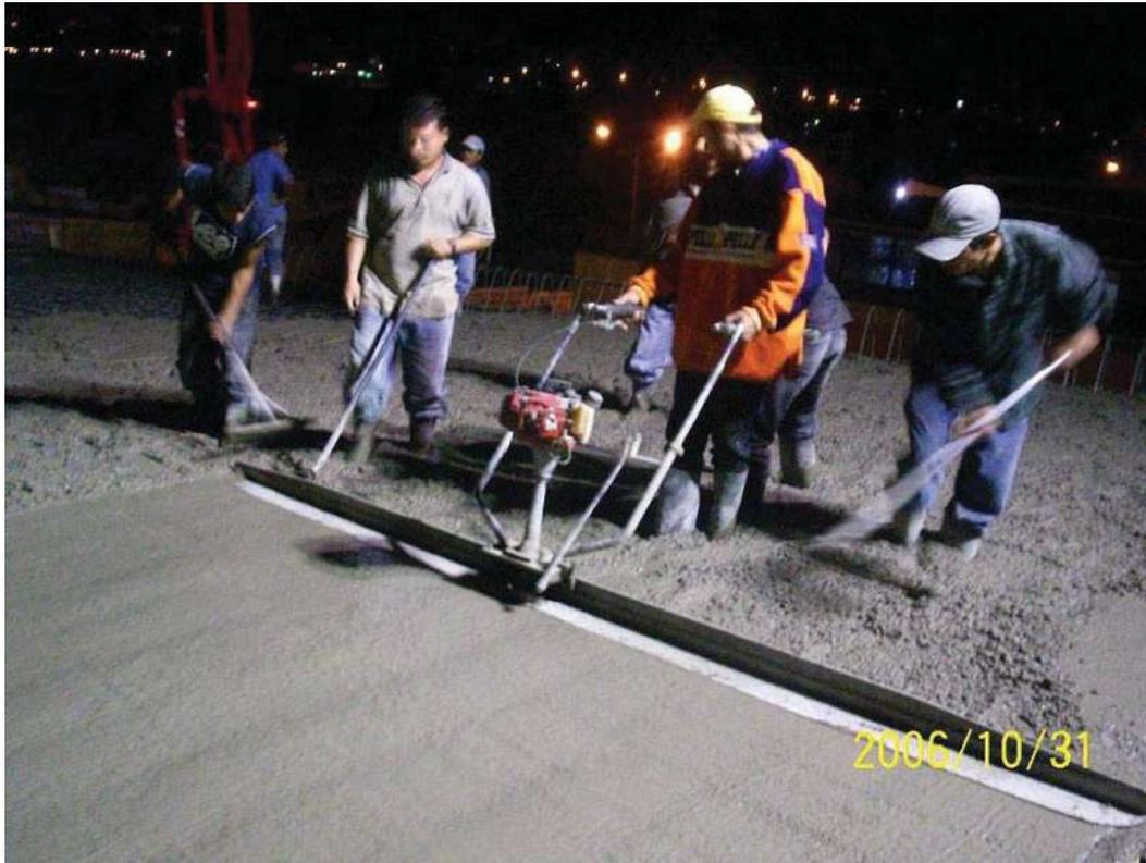
Foto 31: Regla vibratoria, para acomodo del concreto.
