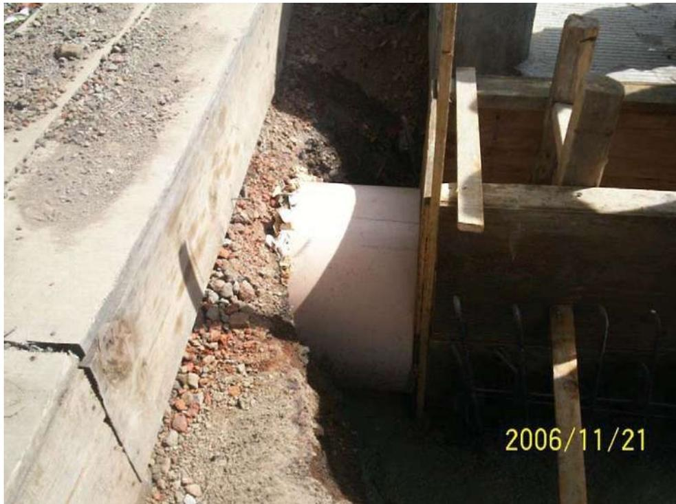
Foto 2: Unión de rejilla pluvial al colector pluvial.
