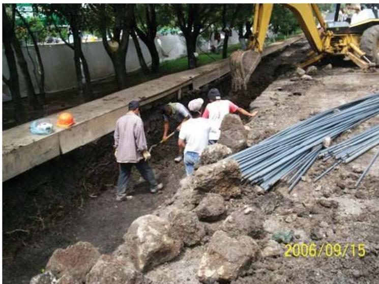
Foto 2: Excavación con la retroexcavadora para alojar la cimentación.
