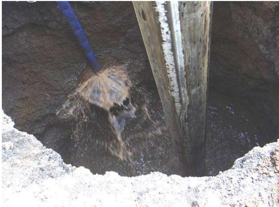
Foto 2: Suministro de Bentonita para estabilizar las paredes de la perforación.
