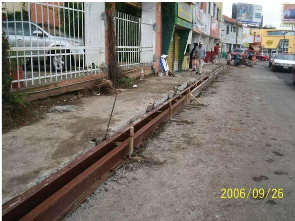
Foto 4: Construcción de guarnición en calle por ampliación en carriles laterales.
