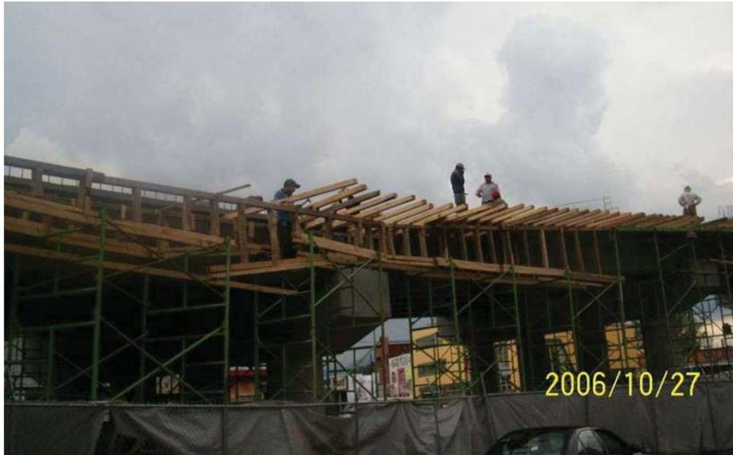
Foto 38: cimbrado de la parte interna de la curva.
