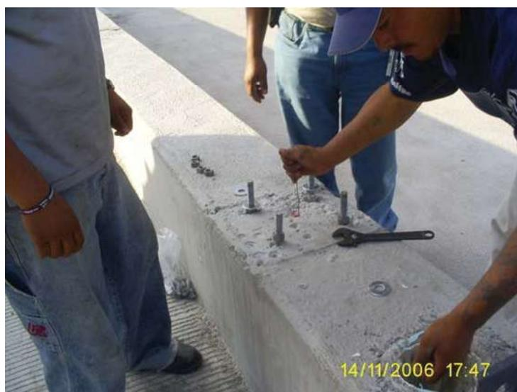
Foto 2. Cableado para las luminarias.
