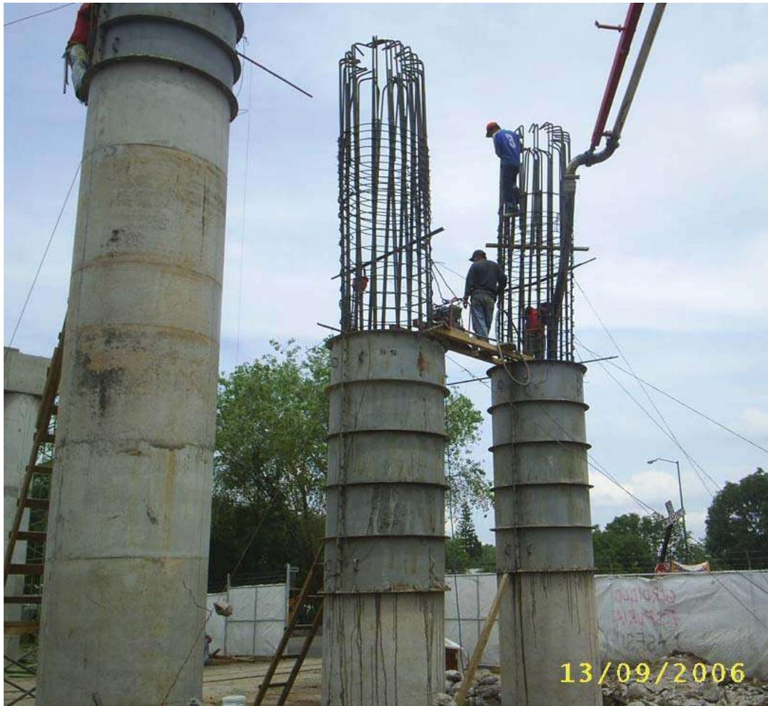
Foto 15: Colado de columnas por secciones.
