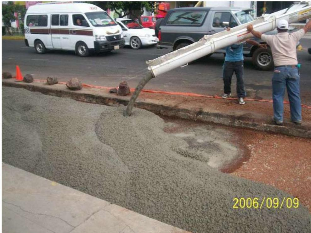
Foto 3: Colocación de concreto en terreno mejorado.
