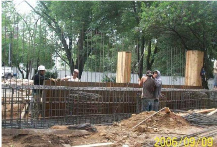
Foto 22. Armado y cimbra del cabezal del eje 1.
