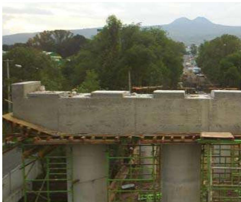
Foto 8: *Torretas*: elemento auxiliar en la construcción de los cabezales.
