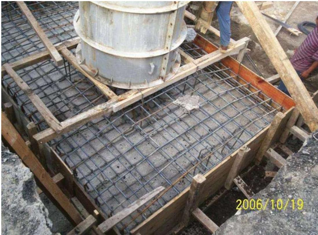
Foto 2: Parrillas de armado de zapata corrida.
