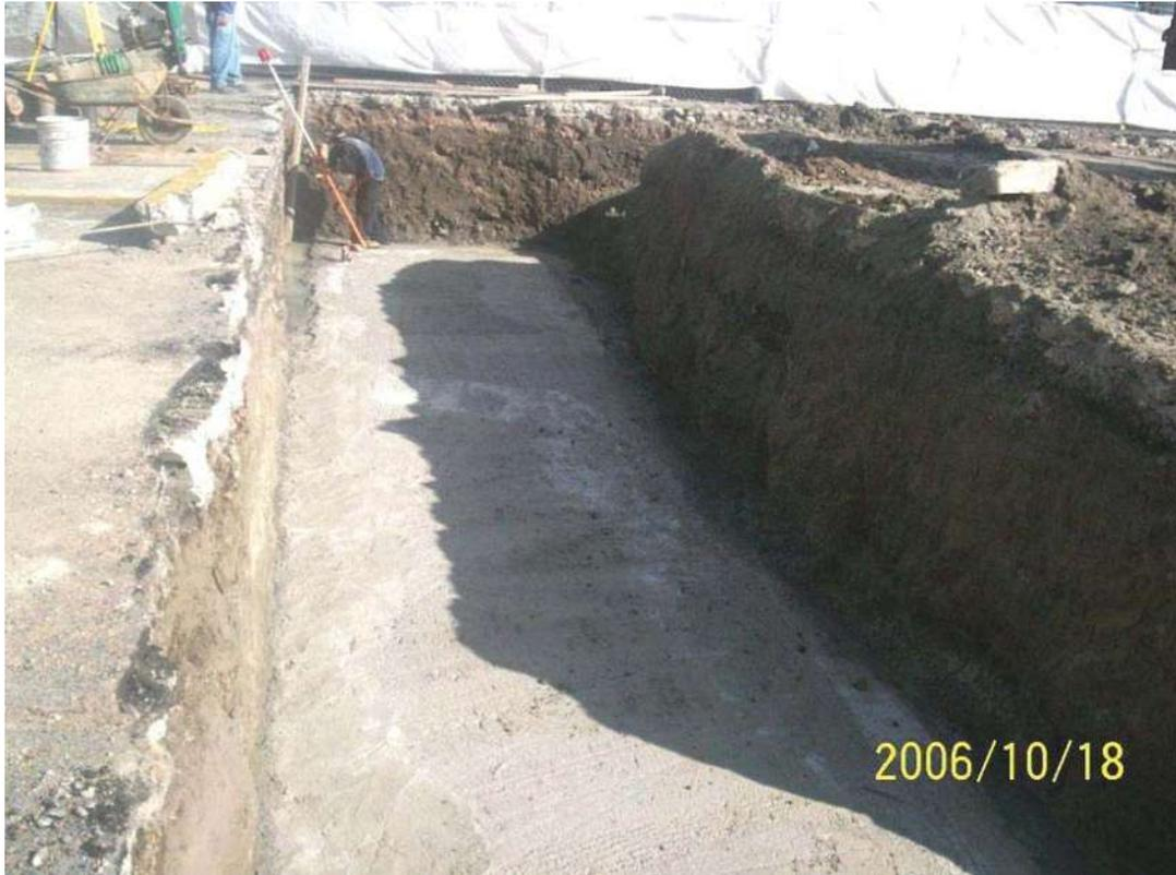
Foto 1: Zanja con plantilla de desplante para cimentación del eje 17.
