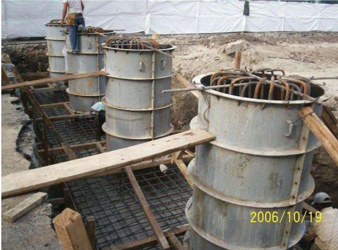
Foto 3: Cimbrado para columnas de eje 17.
