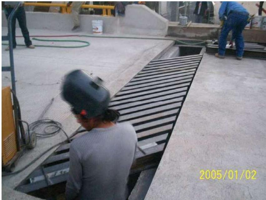
Foto 6. Construcción de reja con vigas I en extremo poniente del paso a desnivel.
