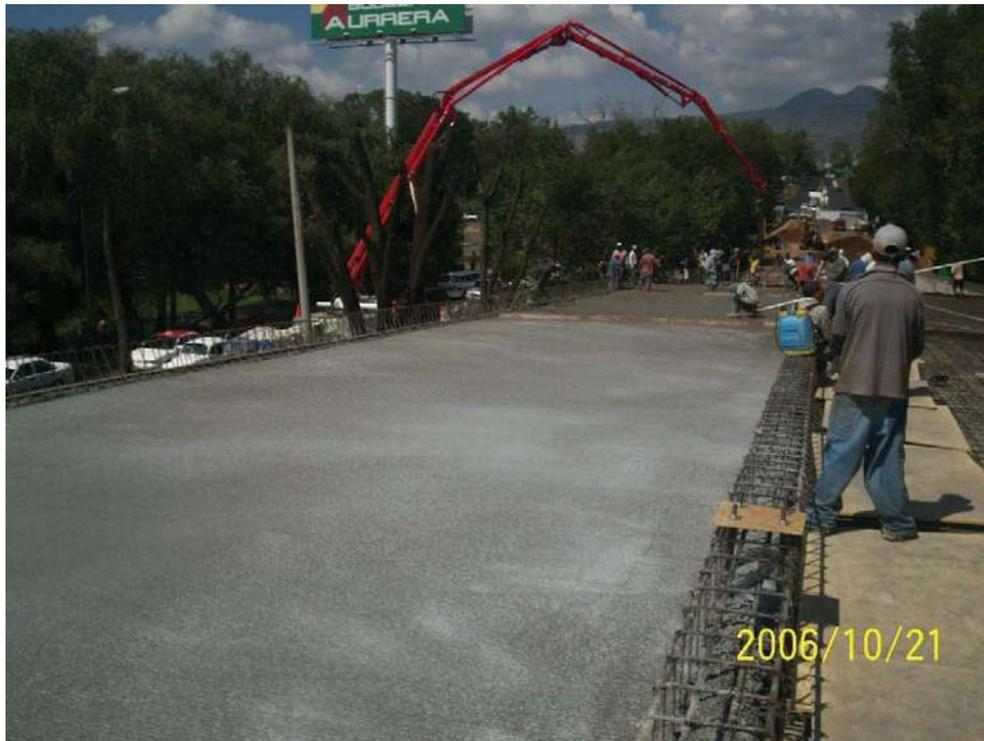
Foto 33: Membrana de curado aplicada con aspersor agrícola.
