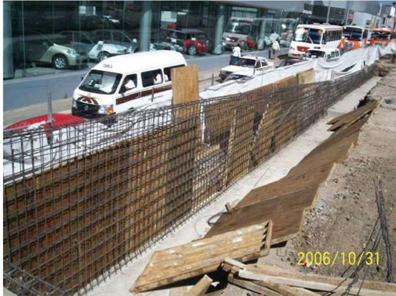
Foto 5: Cimbra y acero de refuerzo en muros.
