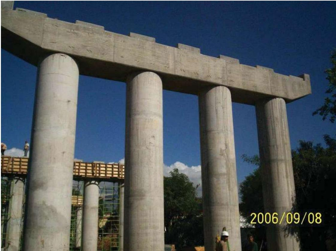
Foto 6: Cabezal con topes y bancos para apoyo de traveses.
