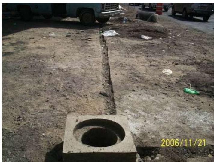
Foto 2: Corte en pavimento y preparación para instalar semáforos.
