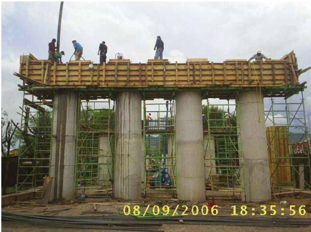
Foto 18. Colocación de concreto hidráulico.
