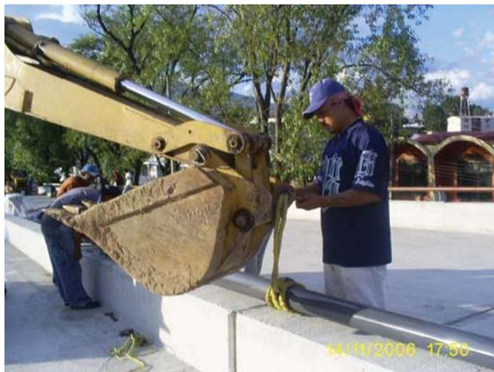
Foto 4. Sujeción de poste de alumbrado al brazo mecánico de la retro.
