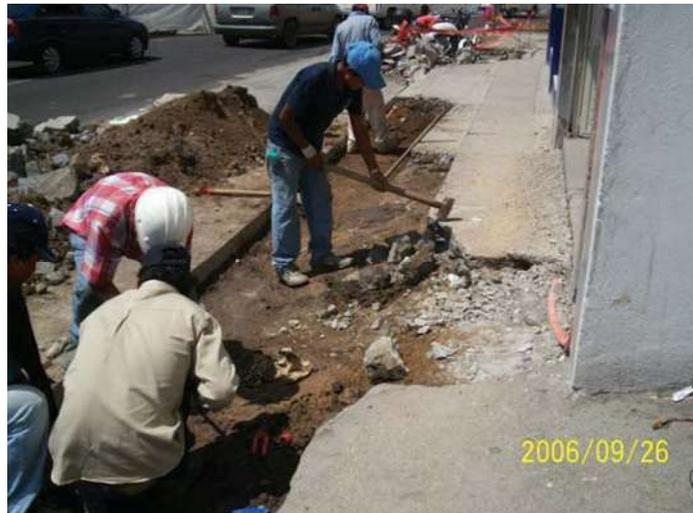
Foto 1: Demolición de concreto hidráulico en banquetas para ampliación lateral.
