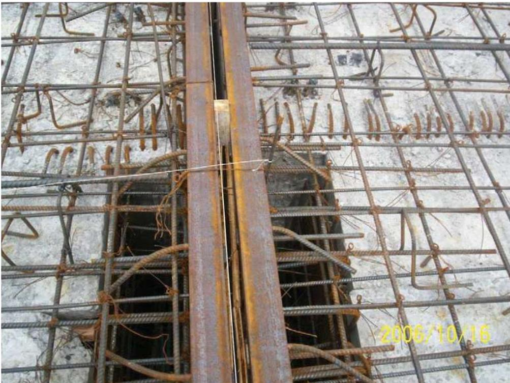
Foto 37: Junta de dilatación o "Peines" en extremos de losas.
