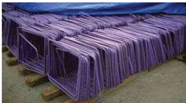
Fotografía 2.2. Cercos Recubiertos preparados para su colocación. 1
