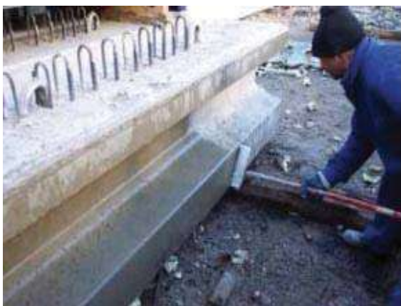
Fotografía 2.4. Aplicación mediante Rodillo y Pistola de los Inhibidores MCI. 1
