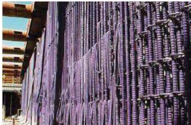
Fotografía 2.3. Aplicaciones de los aceros recubiertos con epoxi en muros. 1
