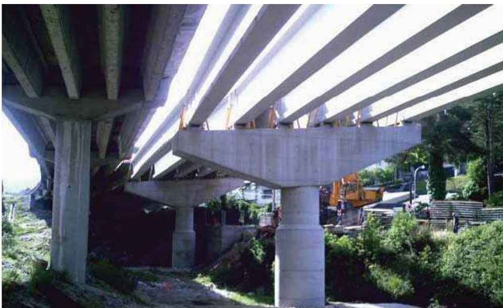
Fotografía 2.5. Aspecto de una estructura tras la aplicación superficial de los inhibidores MCI (Autopista de peaje A-6) 1
