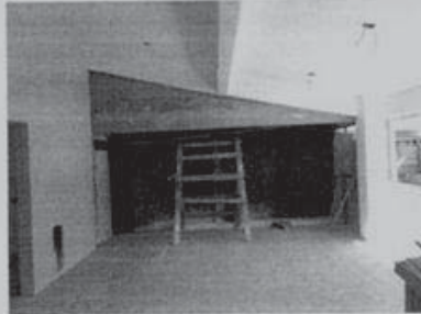
Imagen 29.- Muros y Losa de Sala de Espera; con dirección hacia el área existente. Se presenta la unión del área existente y el área de Ampliación.
