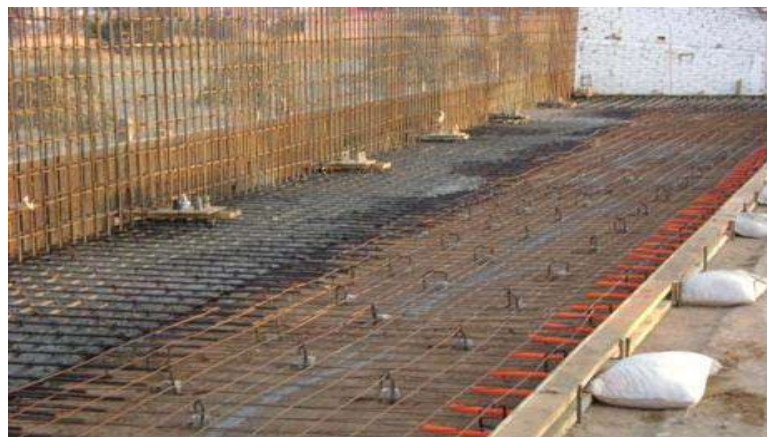
Fot. 49 Colocación de los capuchones y la frontera a nivel.
