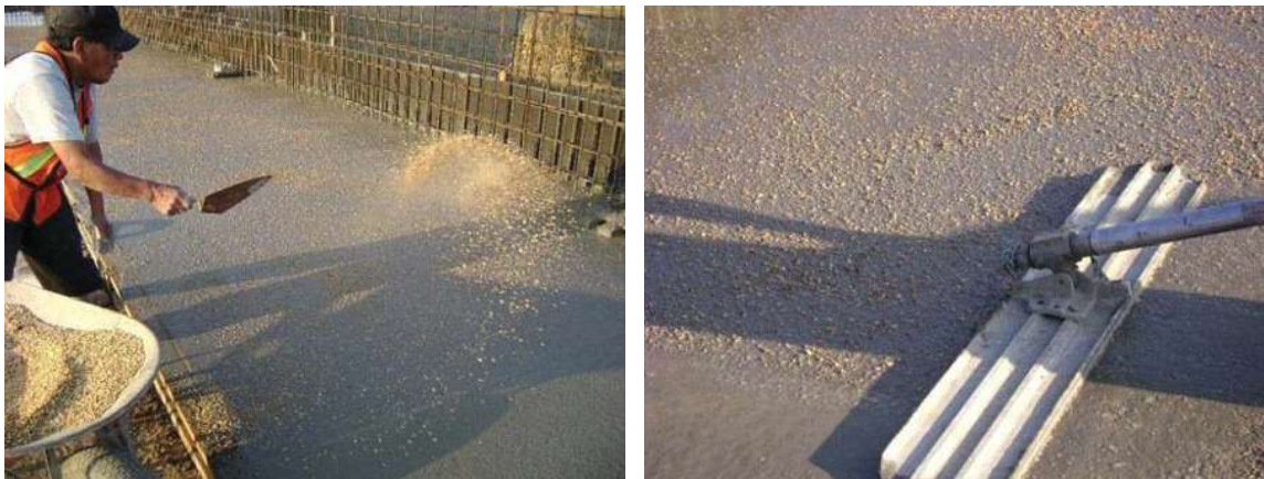
Fot. 53 y 54 muestran la aplicación de endurecedores minerales.
