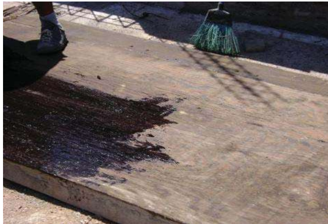
Fot. 33 Madera en proceso de lubricación con aceite quemado.
