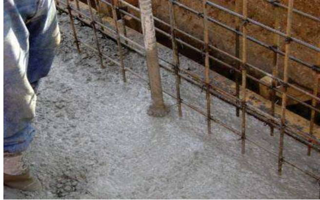
Fot. 36 Vibrado del concreto, usando el vibrador en posición vertical a cada 40 cm.
