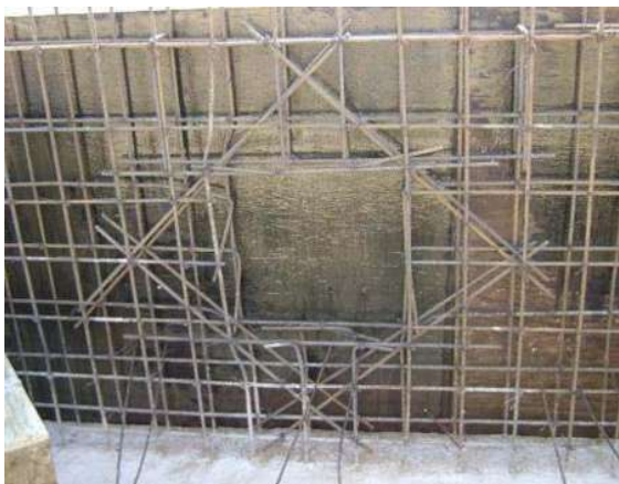
Fot. 64 y 65 Preparación cuadrada para la introducción de albañales.
