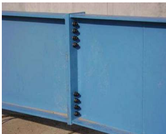
Fot. 79 Atornillado entre dos piezas
