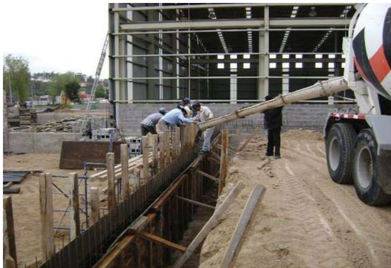
Fot. 34 Preparado para recibir el concreto premezclado.
