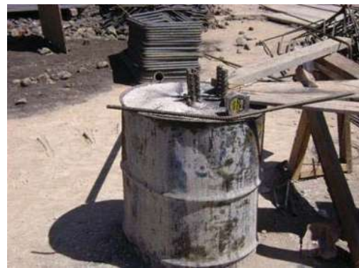
Fot. 28 Banco de concreto
