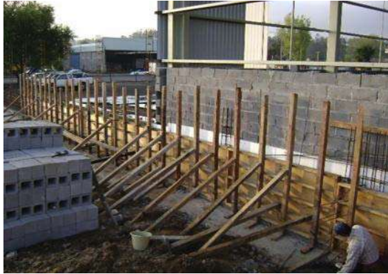
Fot. 38 muestra el cimbrado del muro
