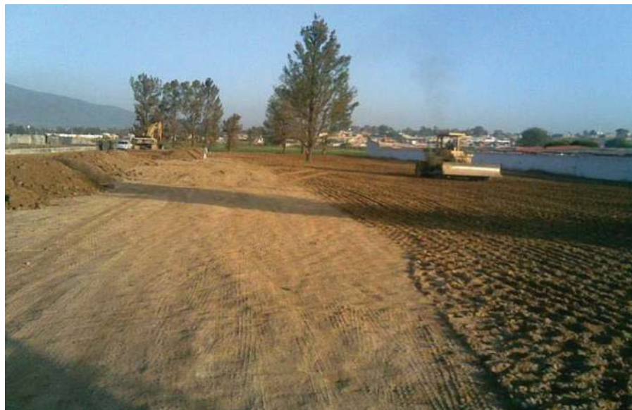
Fot. 8 Compactación del rodillo pata de cabra y a un lado la compactación del rodillo liso.
