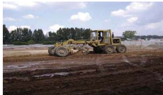
Fot. 15 Motocomformadora homogenizando el material.
