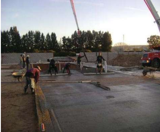
Fot. 55 uso de la flota “bullfloat”
