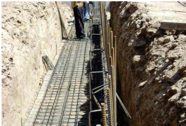
Fot. 37 muestra el uso de las orquillas
