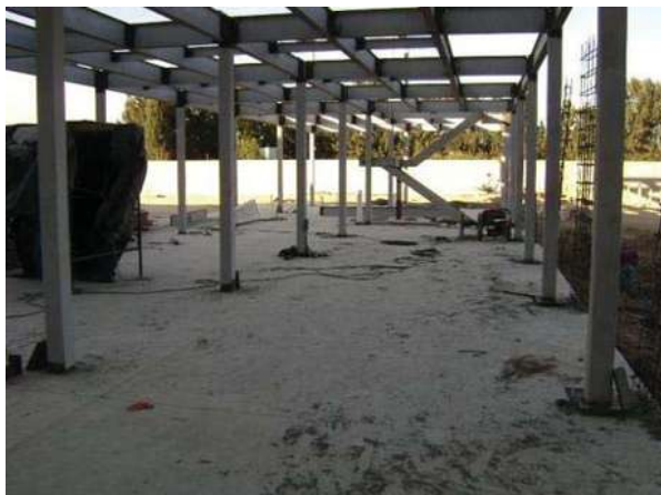
Fot. 77 Estructura soldada
