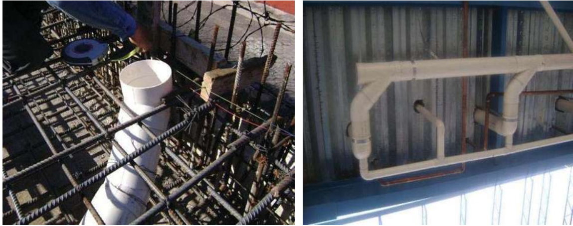
Fot. 68 y 69 uso de las piezas codos y “yes”
