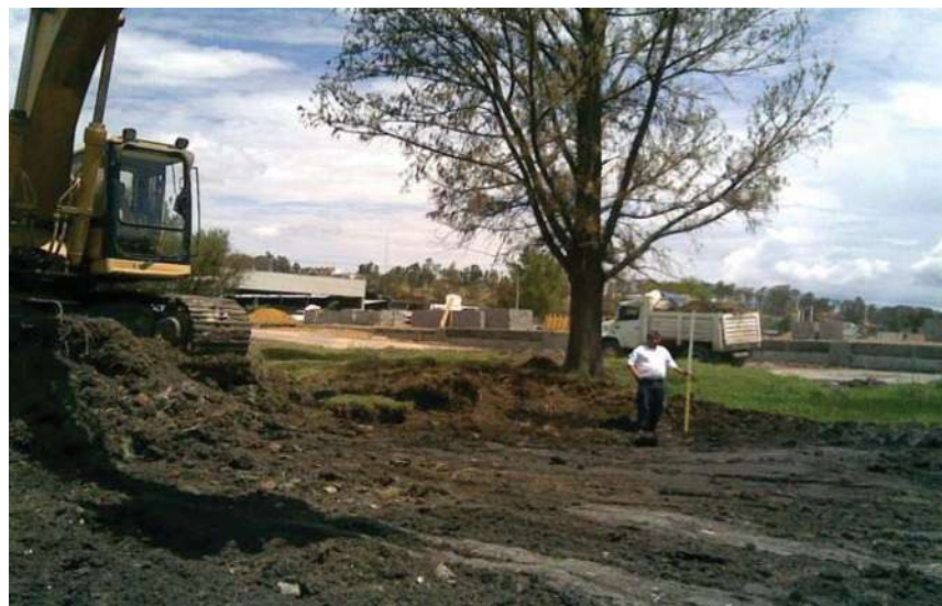
Fot. 5 Muestra la profundidad de excavación
