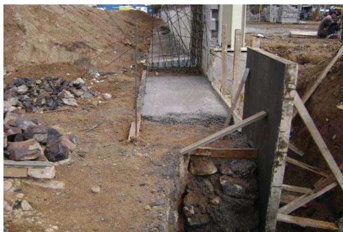
Fot. 16 Muro de contención para detener caídos de paredón.
