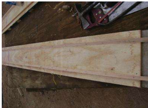
Fot. 47 Colocación de chaflán
