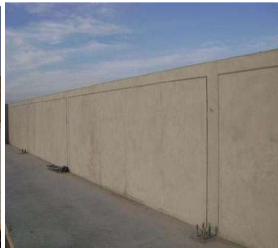
Fot. 48 muestra muro de concreto terminado.
