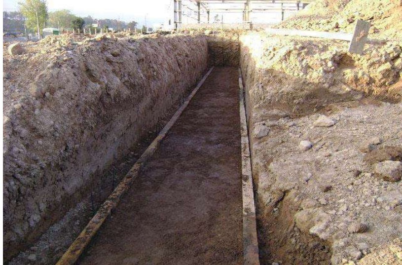
Fot. 17 Afine del terreno y preparación de frontera para la plantilla pobre de F'c = 100 \text{ kg/cm}^2 .
