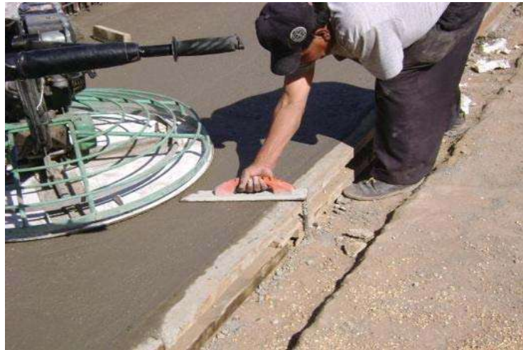
Fot. 61 Remate de las orillas con llanas manuales.
