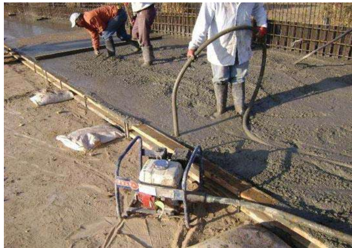
Fot. 51 extendido y vibrado del piso.
