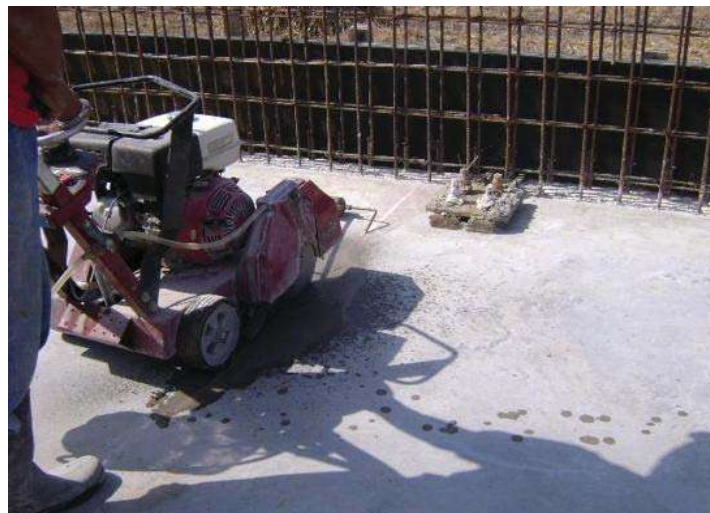
Fot. 63 corte del concreto mediante disco de diamante.
