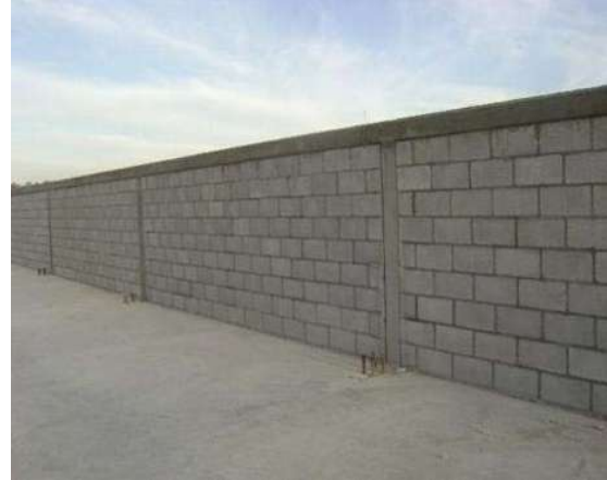
Fot. 45 muro terminado con castillo y dala.
