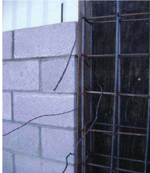
Fot. 49 muestra una junta de construcción, entre muro de concreto y muro de block.
