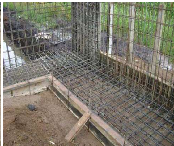
Fot. 31 zapata armada lista para colar.
