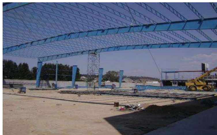
Fot. 88 Colocación de Joist y contravientos
