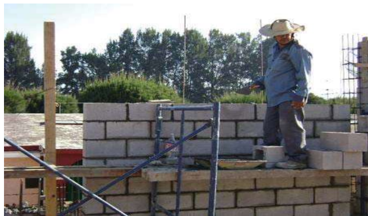
Fot. 46 muestra el uso de andamios e hiladas de block a reventón.
