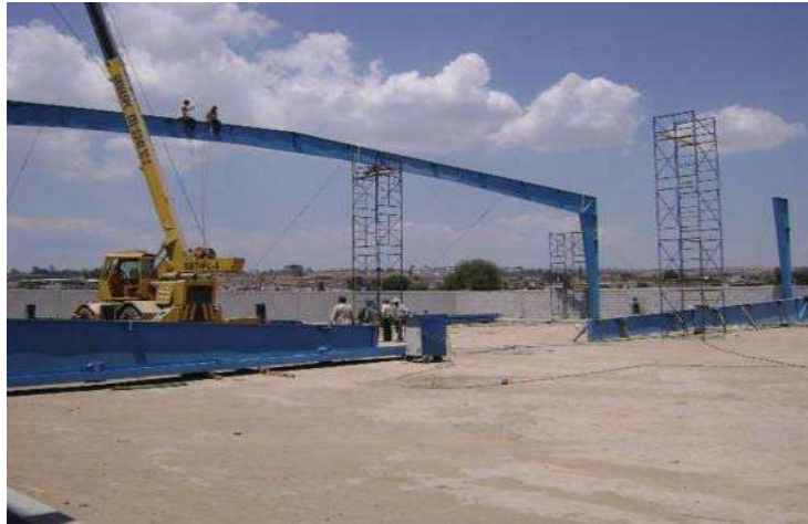
Fot. 86 Alineamiento de la trabe
