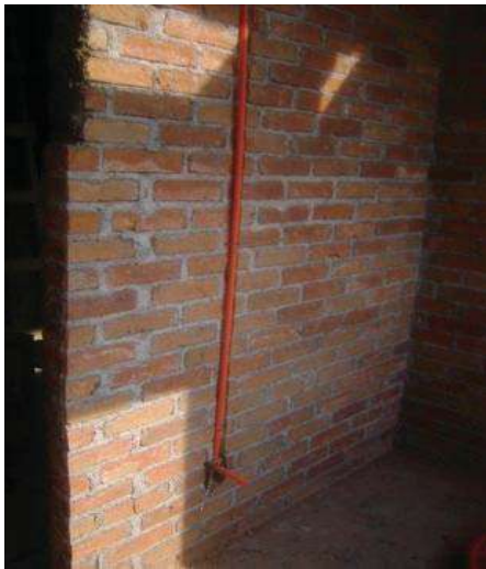
Fot. 76 Colocación de chalupas
