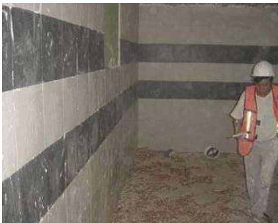
Fot. 91 Colocación de vítreos en muros
