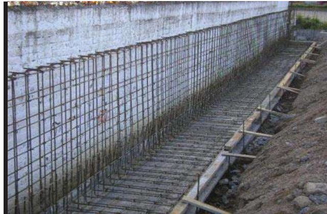
Fot. 32 Colocación de cimbra en la primera etapa de cimentación (Zapata para muros de contención)
