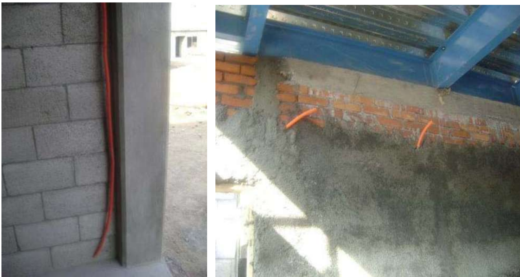
Fot. 74 y 75 Colocación de tuberías conduit
