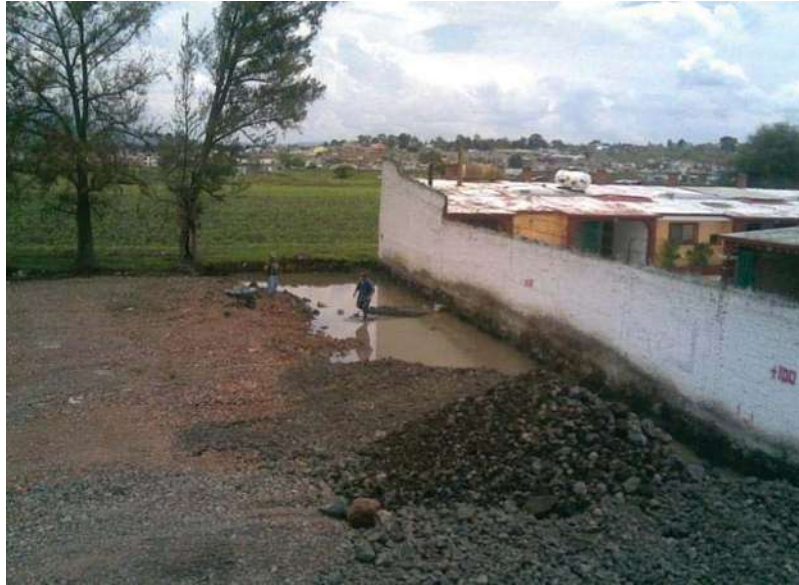
Fot. 6 Se puede observar el vaciado del filtro para resolver los problemas que se presentan con el agua.
