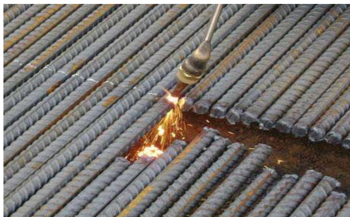
Fot. 26 Corte de varillas haciendo uso del equipo de corte.
