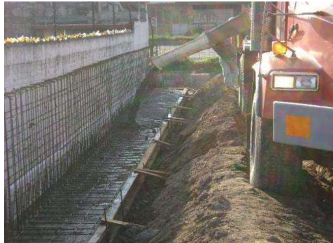
Fot. 35 Vaciado del concreto
