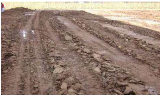
Fot. 14 Escarificación del terreno.
