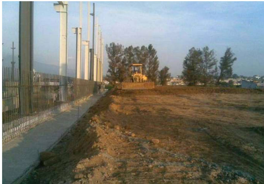
Fot. 10 En el margen izquierdo se puede observar la zapata corrida y las varillas que sobresalen para construir el muro de contención.
