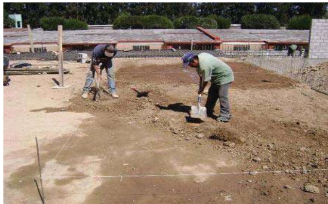
Fot.11 afine de terreno a pico y pala.
