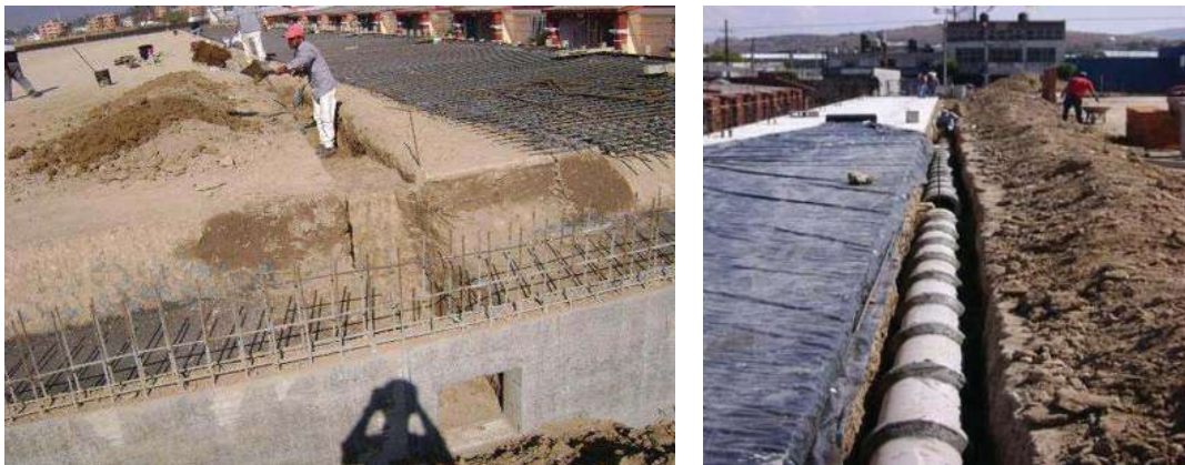
Fot. 70 y 71 Preparación y colocación de albañales.
