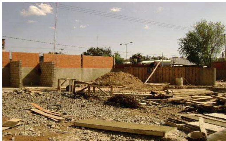
Fot.43 Muros de bloques huecos sobre uno de concreto armado.
