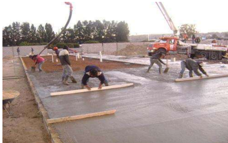
Fot. 52 muestra el reglado del concreto.
