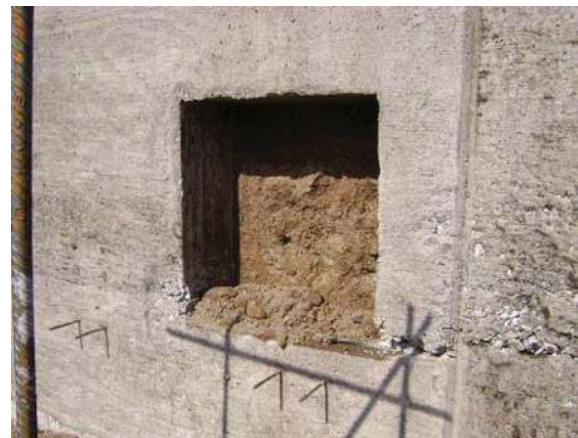
Fot. 64 y 65 Preparación cuadrada para la introducción de albañales.
