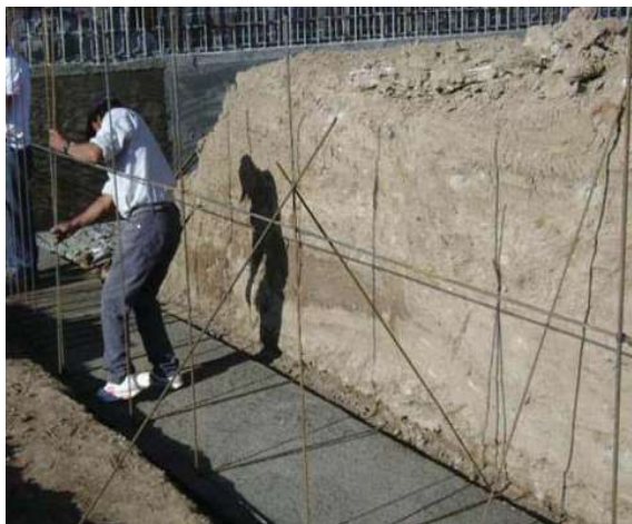
Fot. 30 Colocación de las piezas clave para dar forma a la zapata.
