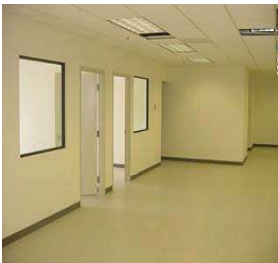
Fot. 93 Piso terminado pulido
