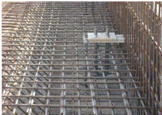
Fot. 82 Colocación de Anclas
