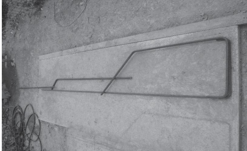
Fot. 29 Tablero para realizar el trazo de las piezas necesarias para el armado.
