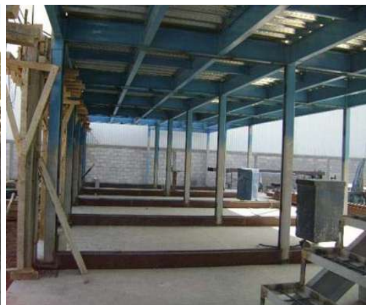
Fot. 78 Estructura con losa-acero
