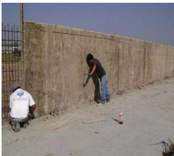
Fot. 47 muro de concreto recién descimbrado
