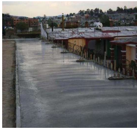
Fot. 60 acabado del piso (pulido).
