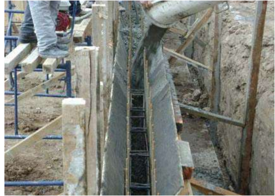
Fot. 39 Muestra el colado del muro.
