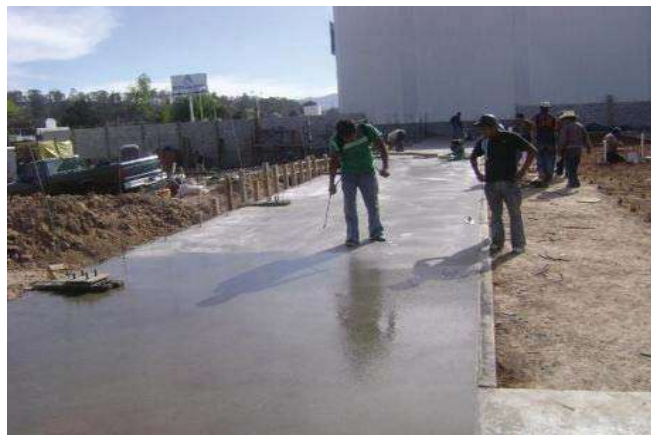
Fot. 62 muestra el curado del cemento con aspersor.
