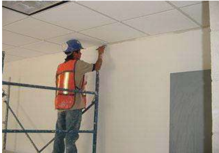
Fot. 95 Techo suspendido mediante estructura metálica
