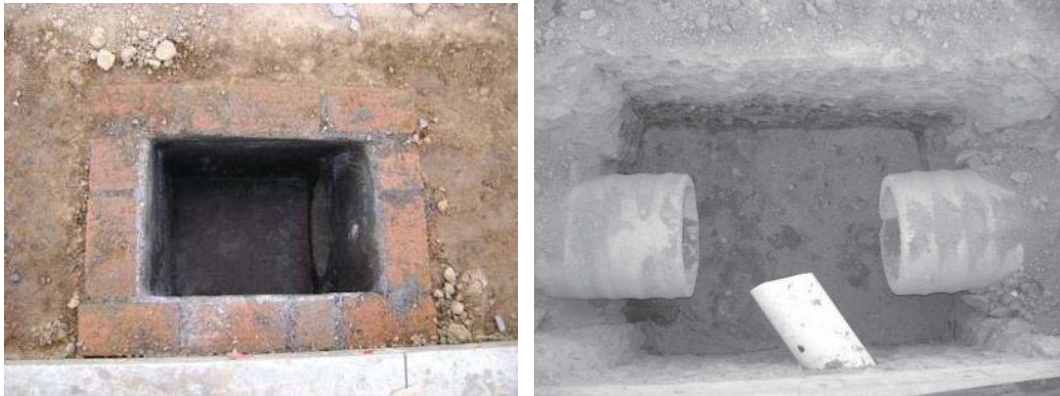
Fot. 72 y 73 Muestran la excavación y el interior del registro.
