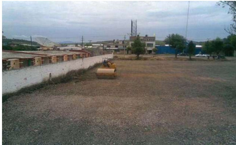
Fot. 7 Rodillo liso compactando ó reacomodando el material para recibir la siguiente capa de material de tezontle.
