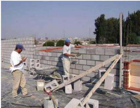
Fot. 44 se puede observar la colocación del block
