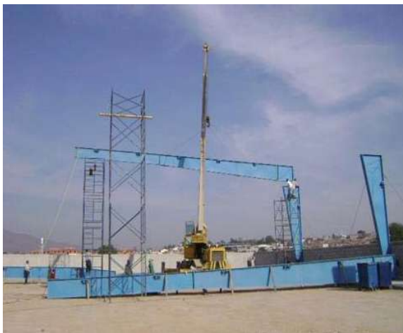
Fot. 84 1ra. Parte de la colocación
