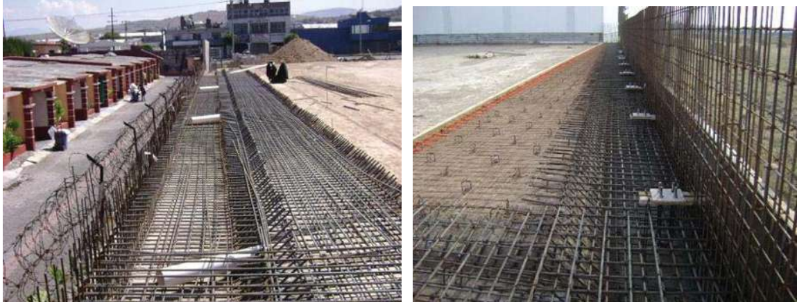
Fotos 41 y 42 muestran el drenaje de agua pluviales y la colocación de capuchones y anclas.
