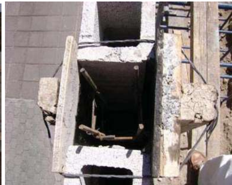
Fot. 48 cimbrado de castillo
