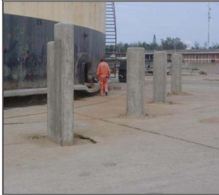
Fig. 8.24.- Relleno con material producto de la excavación.
