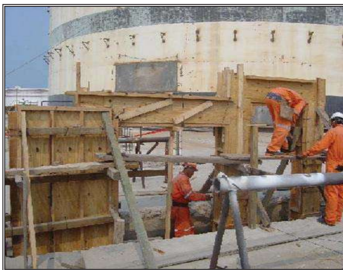
Fig. 8.21.- Cimbrado de dados de mochetas.
