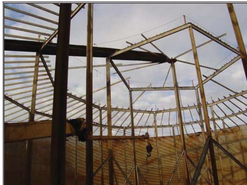
Fig. 3.6.- Apuntalamiento de columnas de la estructura del tanque vertical.
