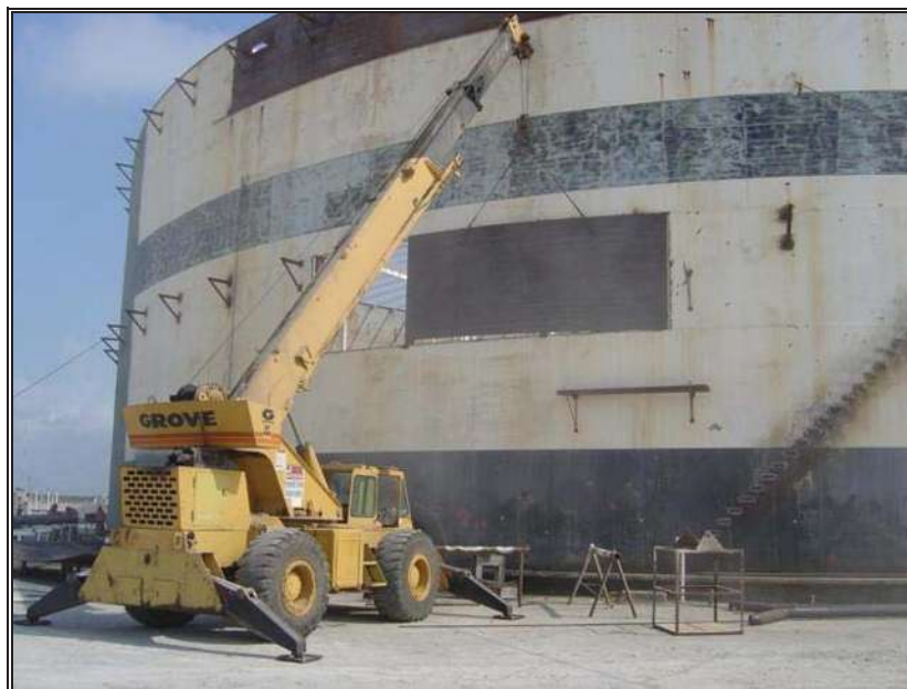
Fig. 6.5.- Maniobras para el montaje de las placas.
