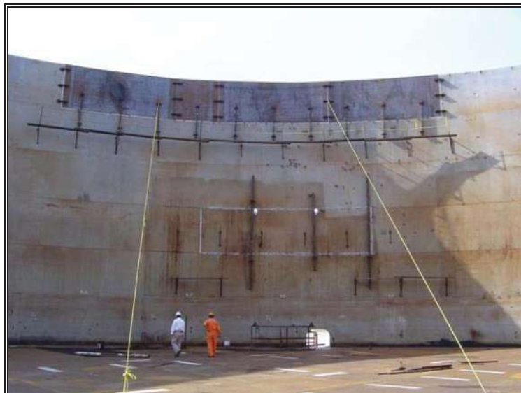
Fig. 6.12.- Colocación de herrajes de sujeción del sexto anillo.
