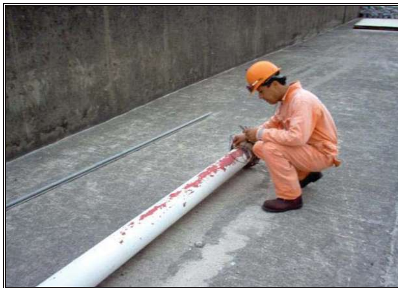
Fig. 3.14.-Calibración de tubería desmantelada.
