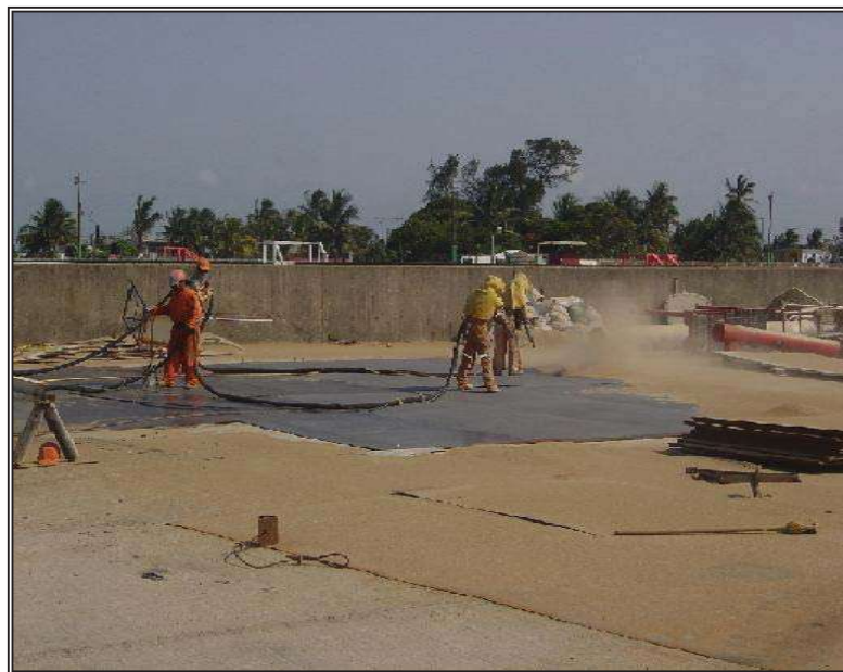
Fig. 7.12.- Limpieza mecánica con equipo de sand-blast en Placas de la cúpula antes de su colocación
