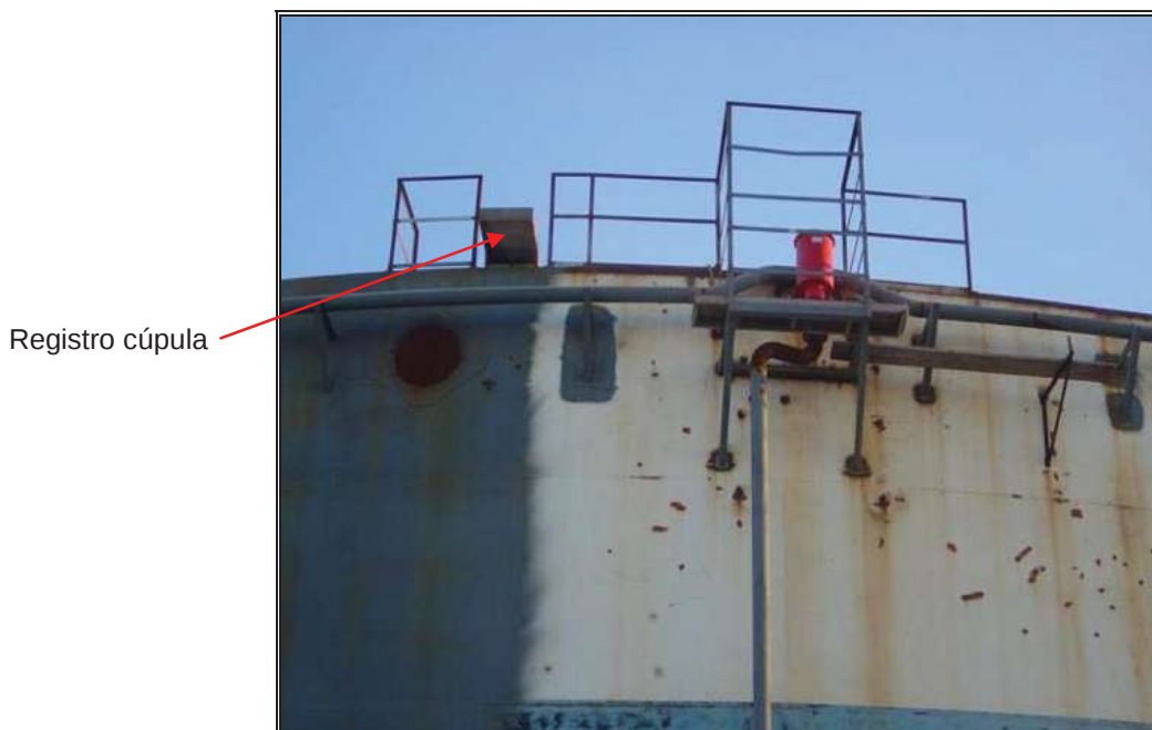
Fig. 8.14.- Registro en cúpula.
