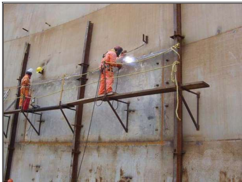
Fig. 6.6.- Aplicación de soldadura en juntas horizontales por el interior.
