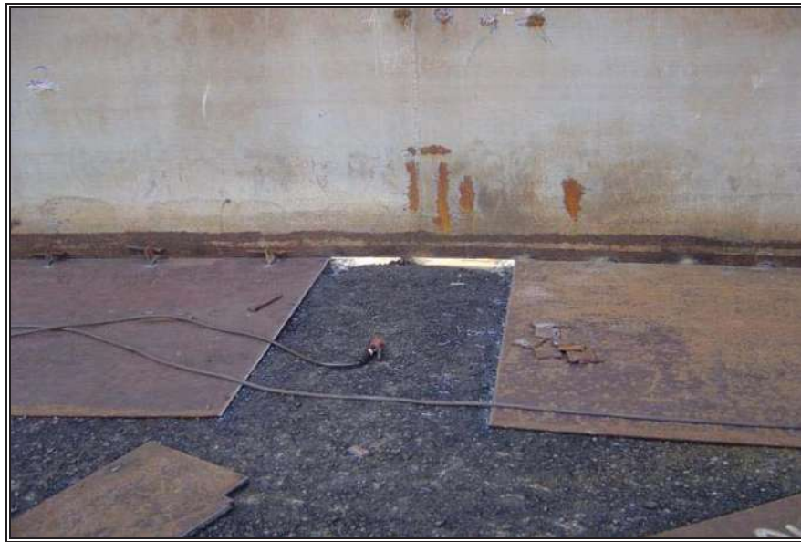
Fig. 5.11.- Tendido y ajuste de placa anular del fondo.
