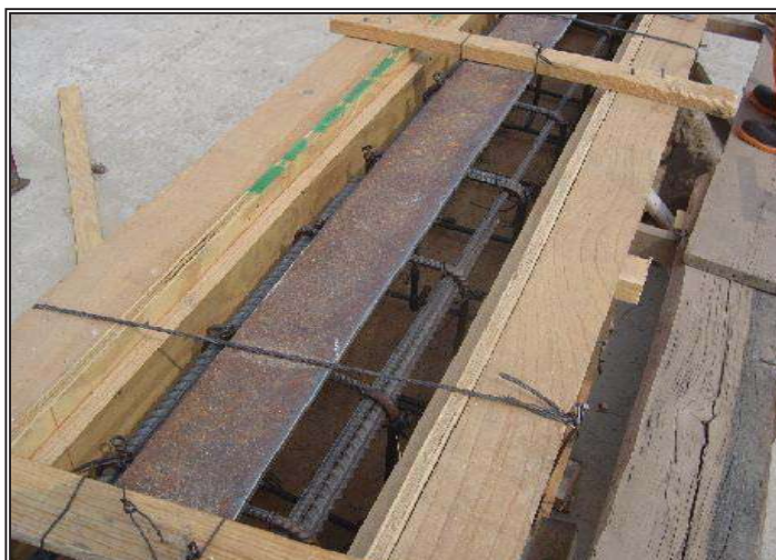
Fig. 8.22.- Colocación de placa niveladora.
