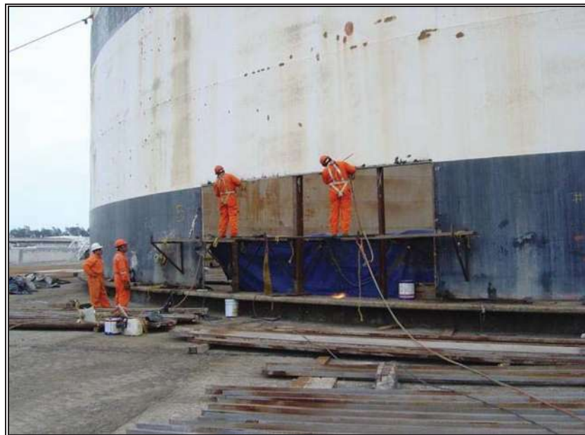
Fig. 3.11.- Escuadrado y nivelado de placas de la envolvente.
