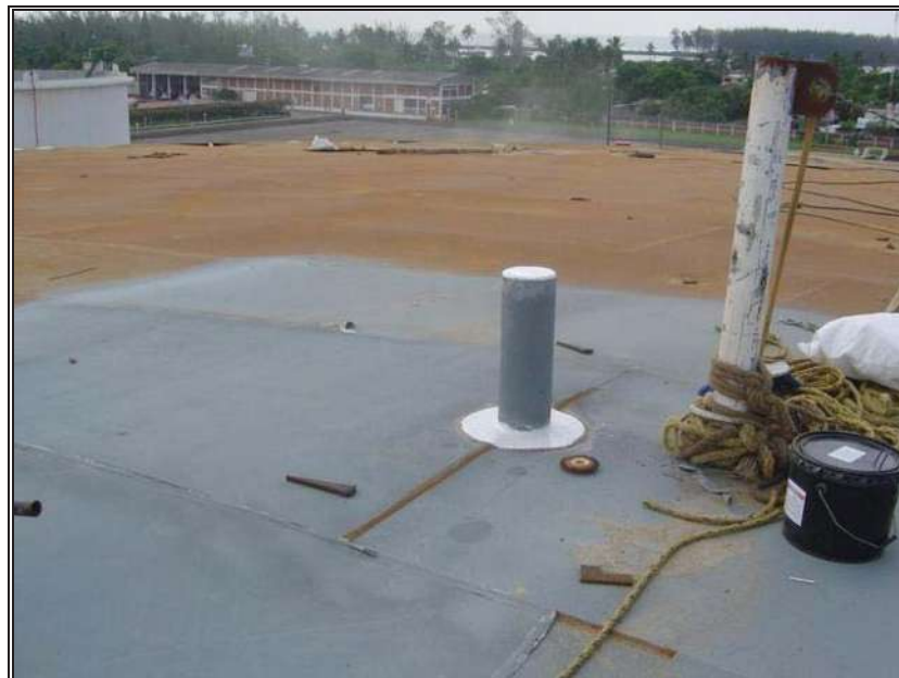
Fig. 7.21.- Limpieza mecánica y aplicación de primario por el exterior de la cúpula
