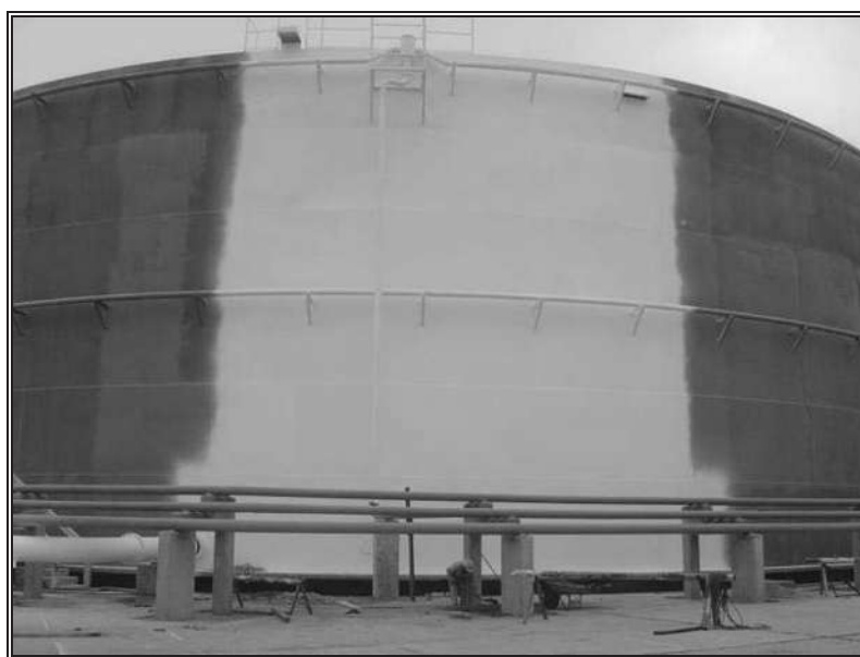
Fig. 6.19.- Aplicación de pintura en exterior del tanque.
