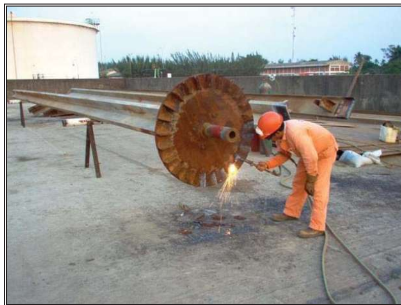
Fig. 7.3.- Sustitución de cartabones en capitel de columna central
