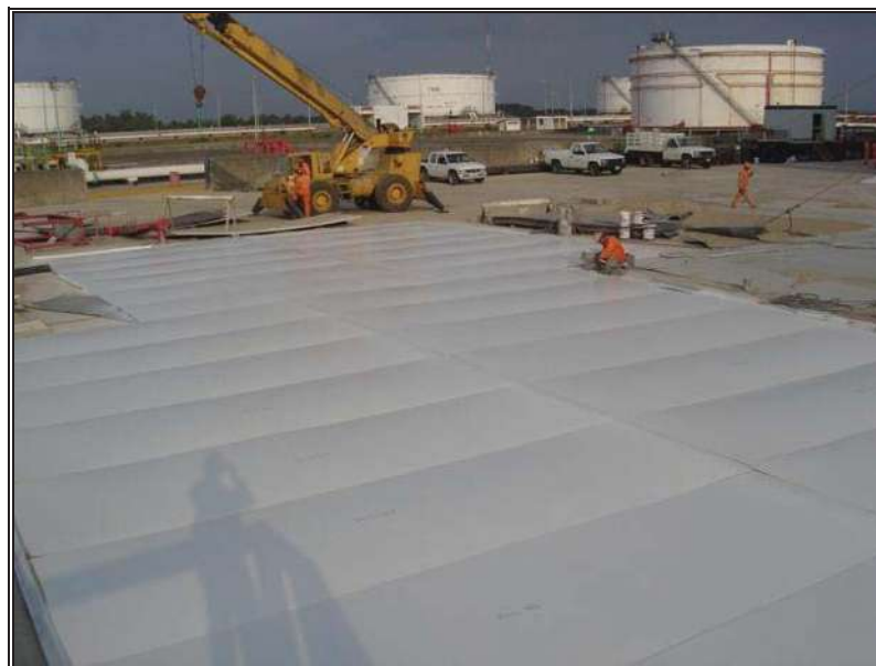
Fig. 7.13.- Aplicación de pintura en placas de la cúpula antes de su colocación
