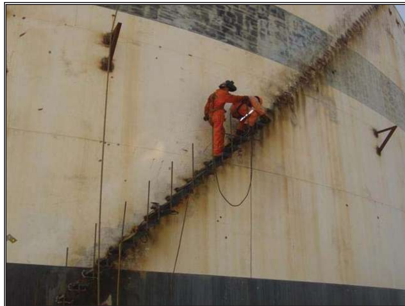
Fig. 3.13.- Desmantelamiento de escalera helicoidal.
