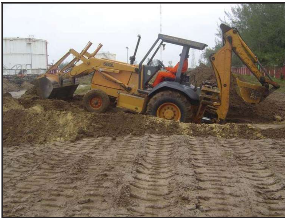
Fig. 4.6.- Mezclado de material contaminado para su neutralización.
