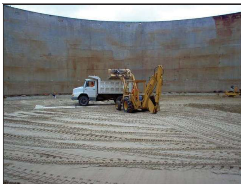
Fig. 4.5.- Excavación y afine del fondo de material no contaminado.
