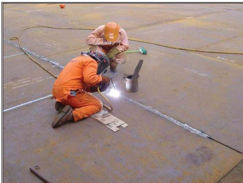
Fig. 5.13.- Soldadura de filete en placas centrales del fondo.
