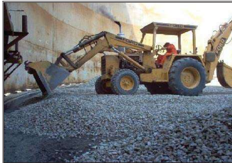
Fig. 4.14.- Colocación de capa de grava-arena bien graduada.
