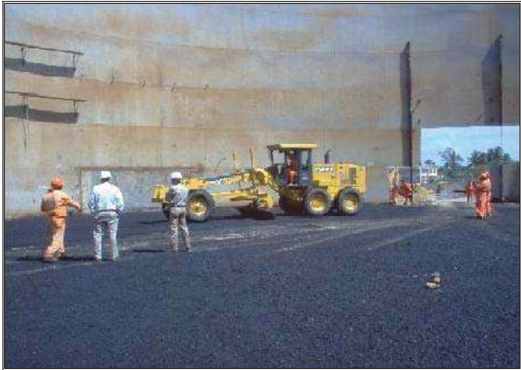
Fig. 4.16.- Colocación de carpeta con máquina motoconformadora.
