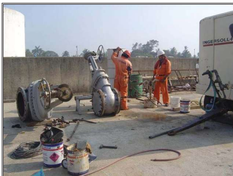
Fig. 8.15.- Prueba hidrostática de las válvulas.
