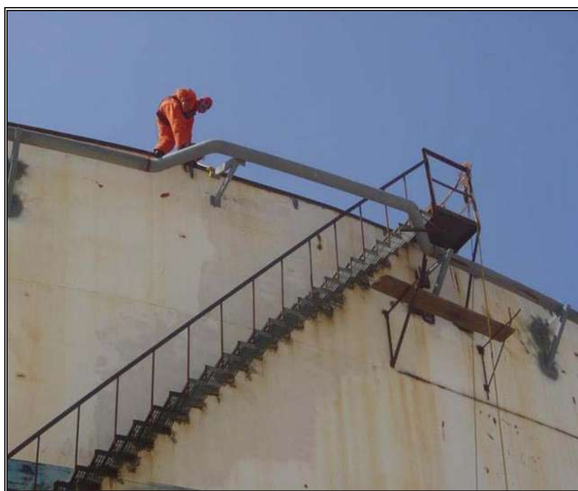
Fig. 8.17.- Fabricación y montaje de escalera helicoidal.
