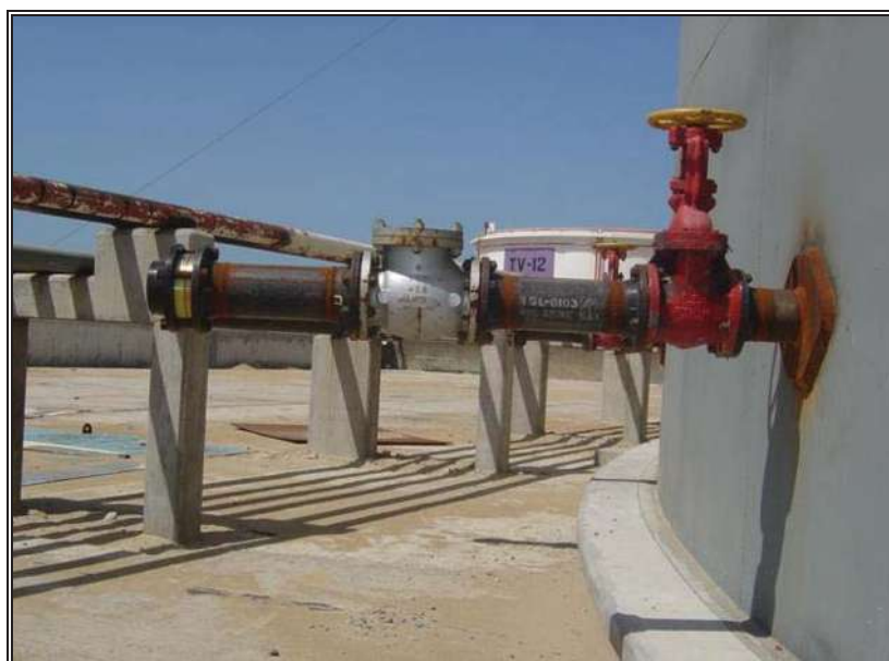
Fig. 8.3.- Boquilla de inyección subsuperficial.
