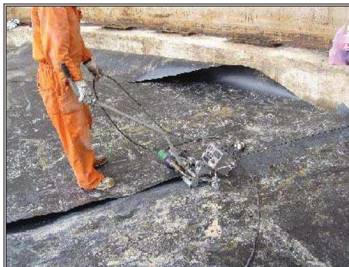
Fig. 4.11.- Soldadura de paneles de geomembrana.
