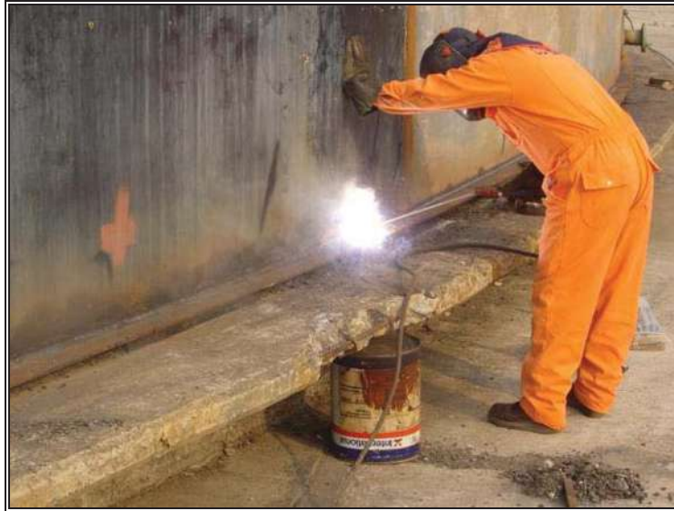
Fig. 6.7.- Aplicación de soldadura en Fondo-Envolvente.
