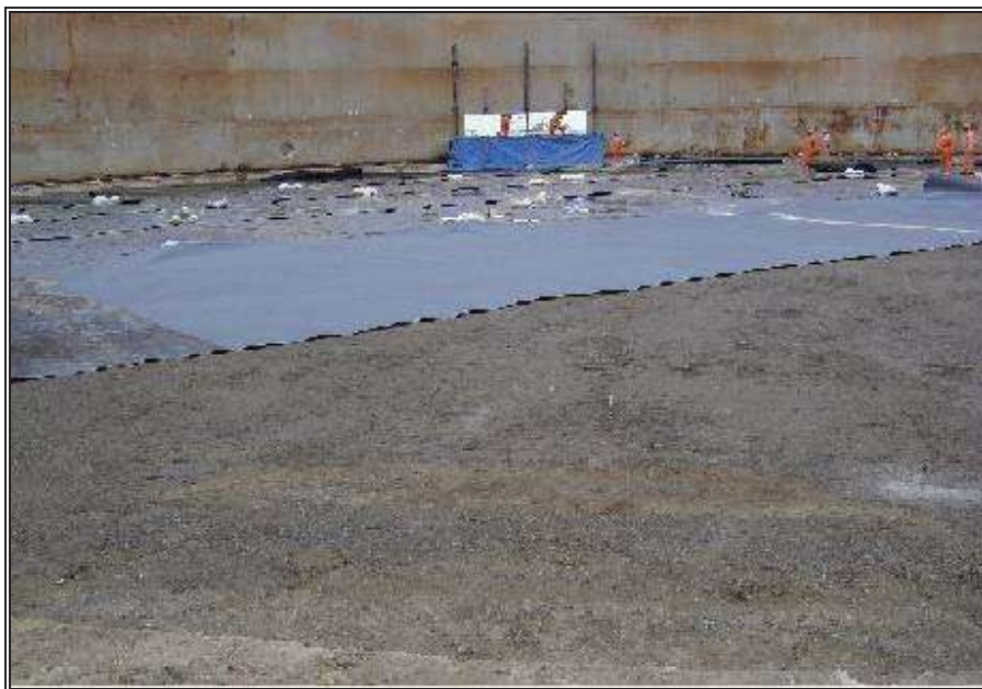
Fig. 4.9.- Colocación y tendido de la geomembrana.
