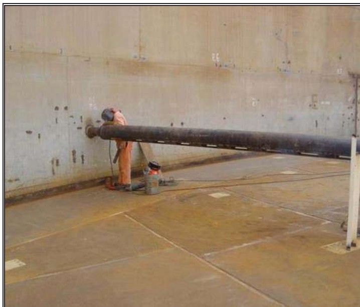
Fig. 8.5.- Colocación y soldadura de los tubos de inyección subsuperficial.
