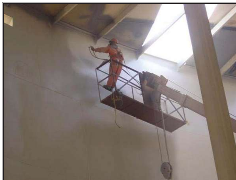
Fig. 6.18.- Aplicación de pintura en el interior del tanque.
