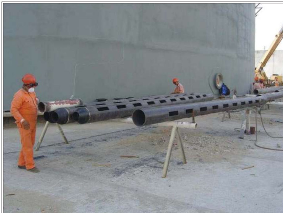
Fig. 8.4.- Fabricación de tubos de inyección subsuperficial.
