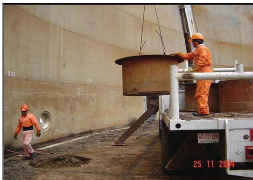
Fig. 3.8.- Desmantelamiento de las tinas de drenaje.
