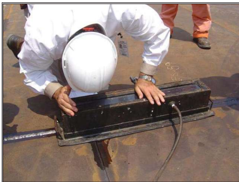
Fig. 7.17.- Prueba con caja de vacíos en soldaduras de placa de la cúpula.
