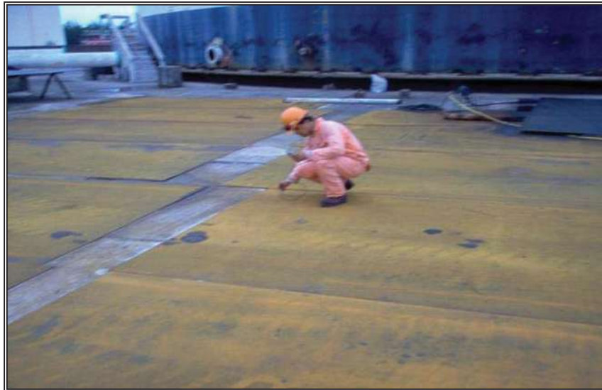
Fig. 5.2.- Calibración de espesores de las placas del fondo.
