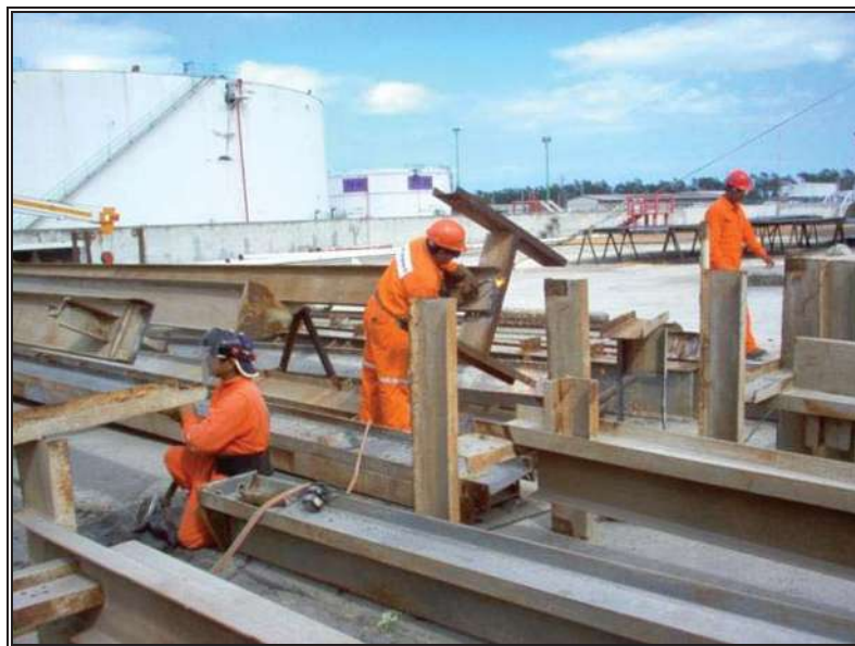
Fig. 7.4.- Retiro de bases tipo "H" en columnas
