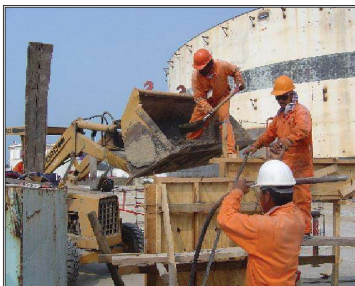
Fig. 8.23.- Vaciado y vibrado del concreto.
