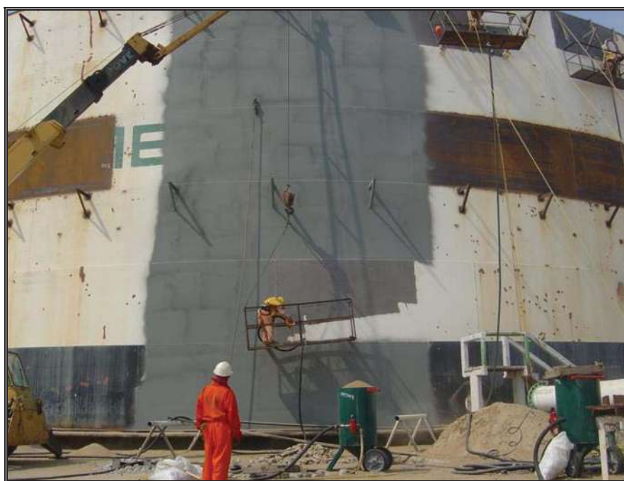
Fig. 6.17.- Limpieza con equipo de SAND-BLAST en el exterior del tanque.
