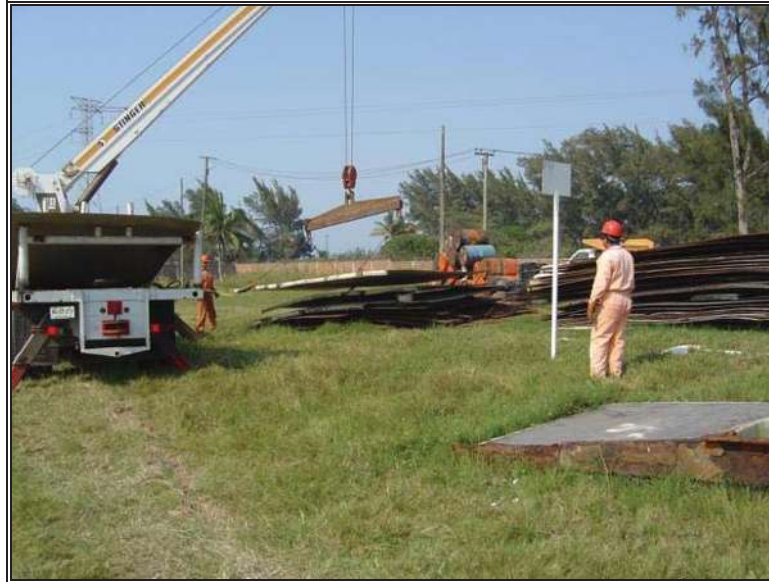
Fig. 3.16.- Centro de acopio de materiales.
