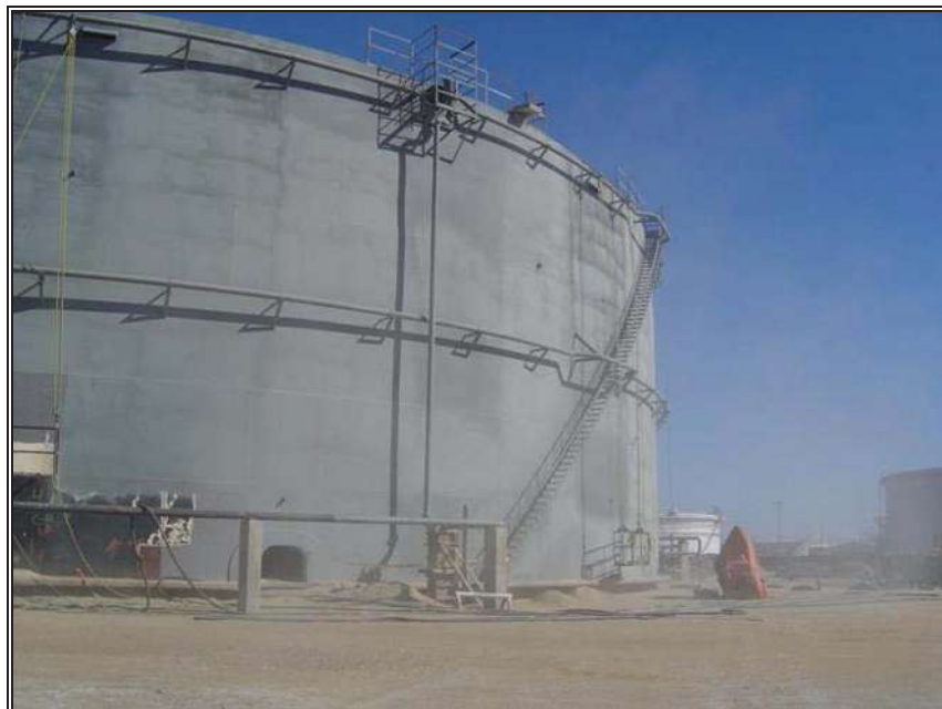
Fig.8.9.- Ubicación de anillos de enfriamiento.
