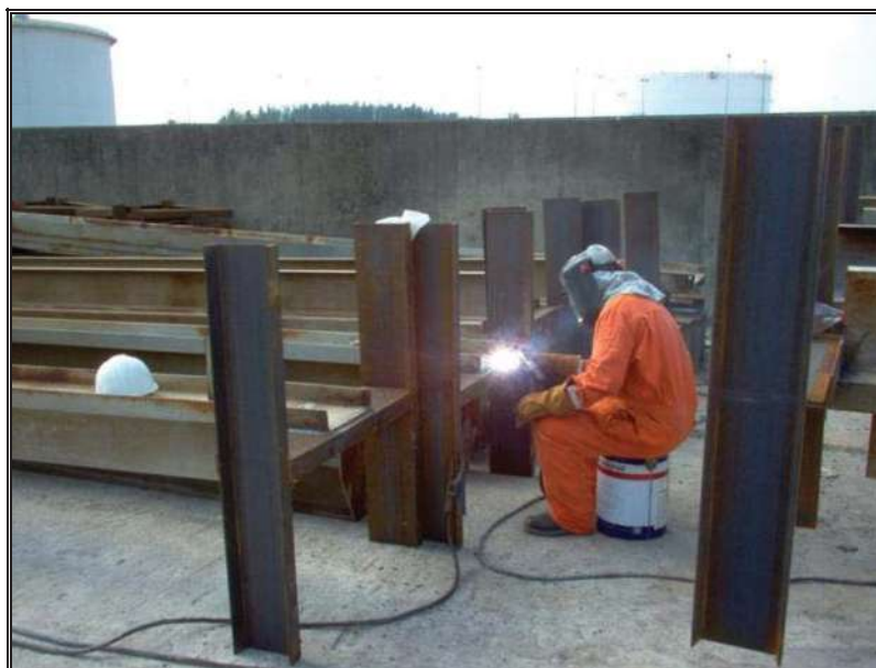
Fig. 7.5.- Soldadura en bases de columnas
