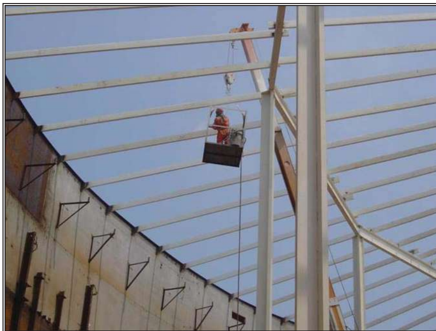
Fig. 7.11.- Aplicación de pintura en estructura colocada
