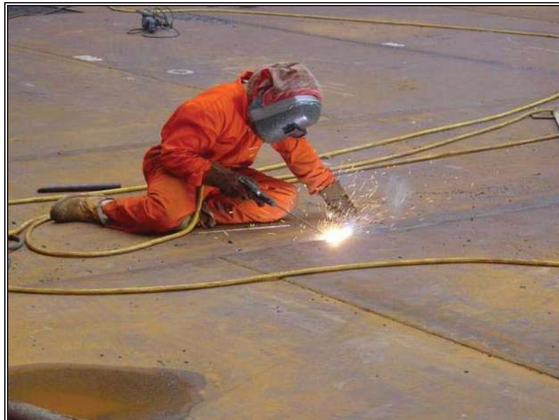
Fig. 7.14.- Soldadura de filete en placas de la cúpula.
