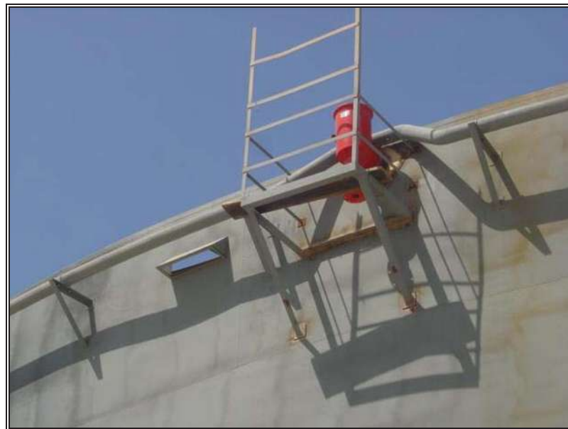
Fig. 8.16.- Vertedero de sobrellenado.
