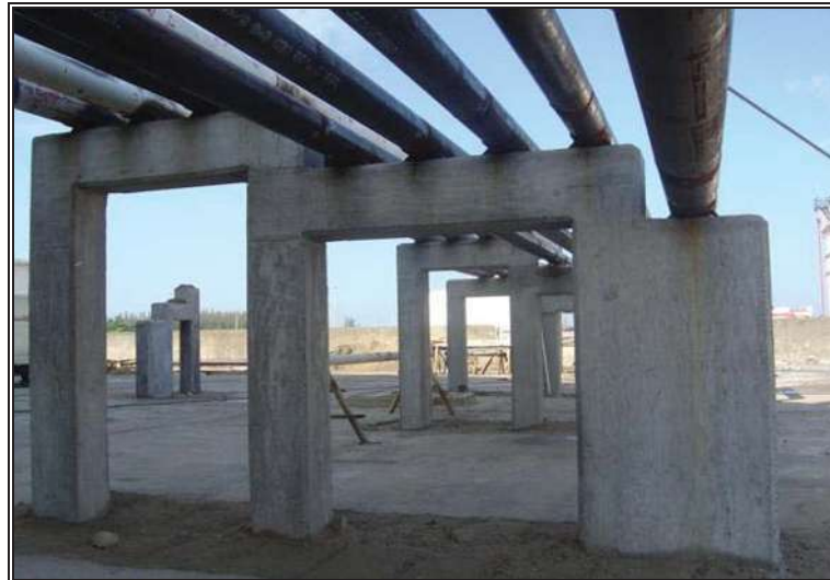
Fig. 8.25.- Mochetas con tubería colocada.
