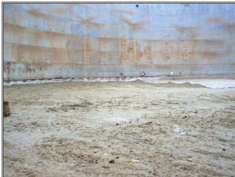
Fig. 4.8.- Capa de material calidad base de 15 cm. de espesor.
