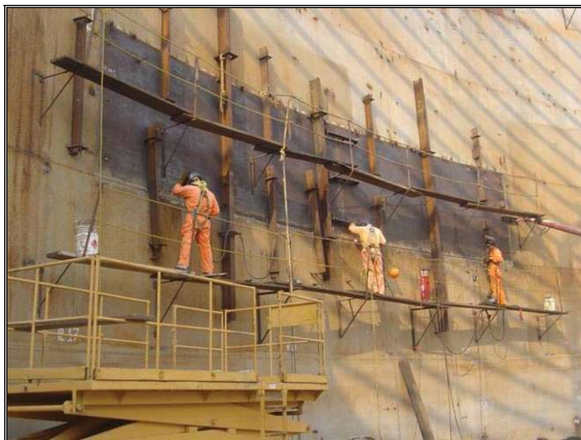
Fig. 6.10.- Colocación de rigidizantes y aplicación de soldadura.
