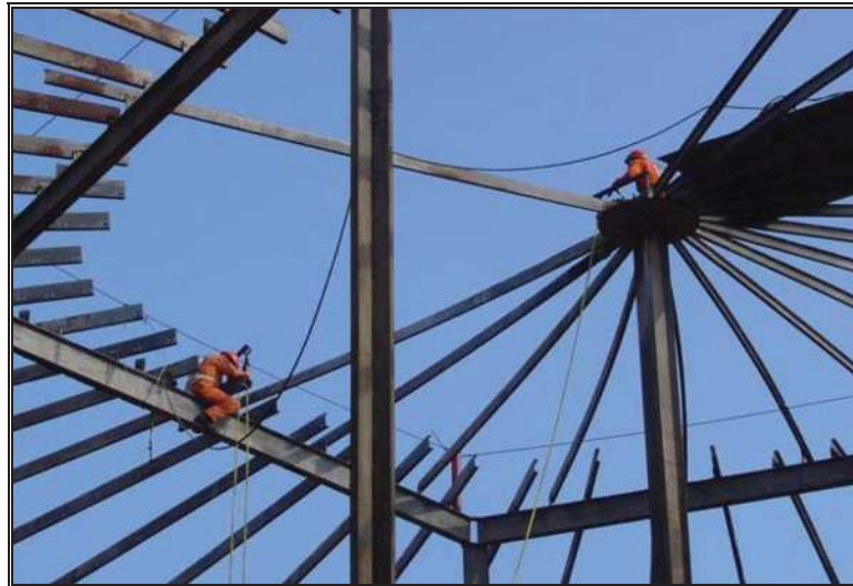
Fig. 3.5.- Retiro de canales del capitel de la columna central y primera sección de trabes.
