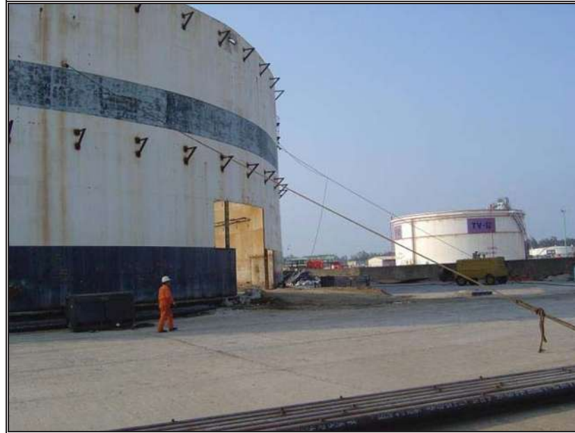
Fig. 3.2.- Ventana en la envolvente para acceso de materiales y equipo.
