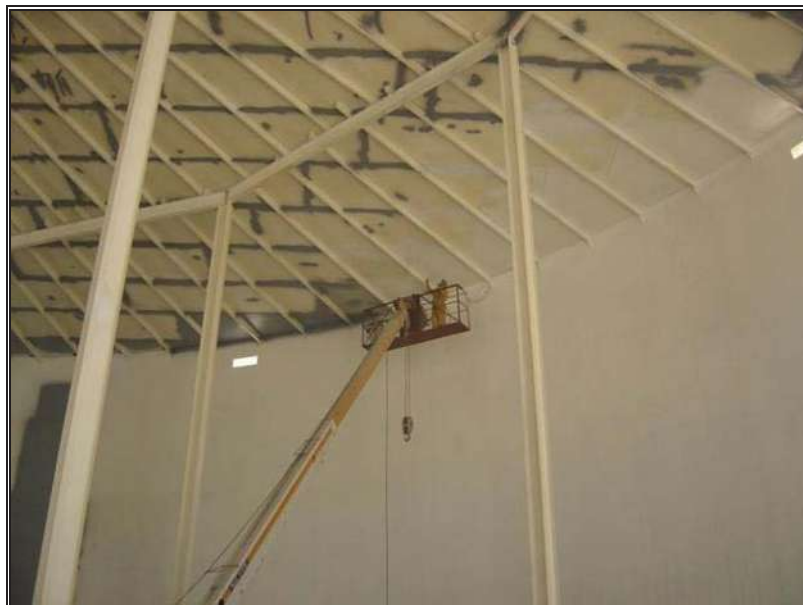
Fig. 7.20.- Aplicación de pintura en el interior de la cúpula
