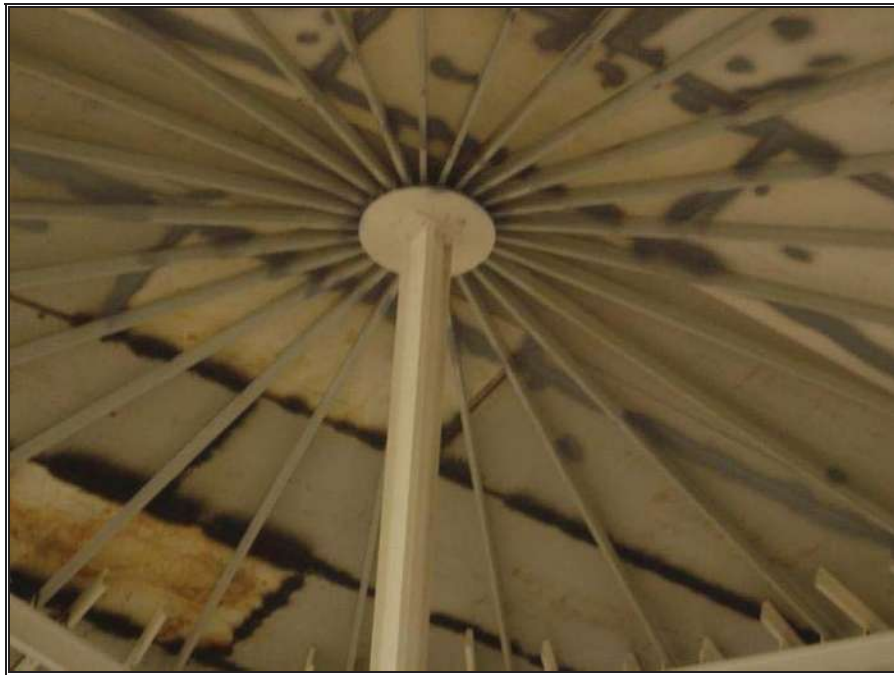
Fig. 7.18.- Detallado de pintura en soldadura de placas
