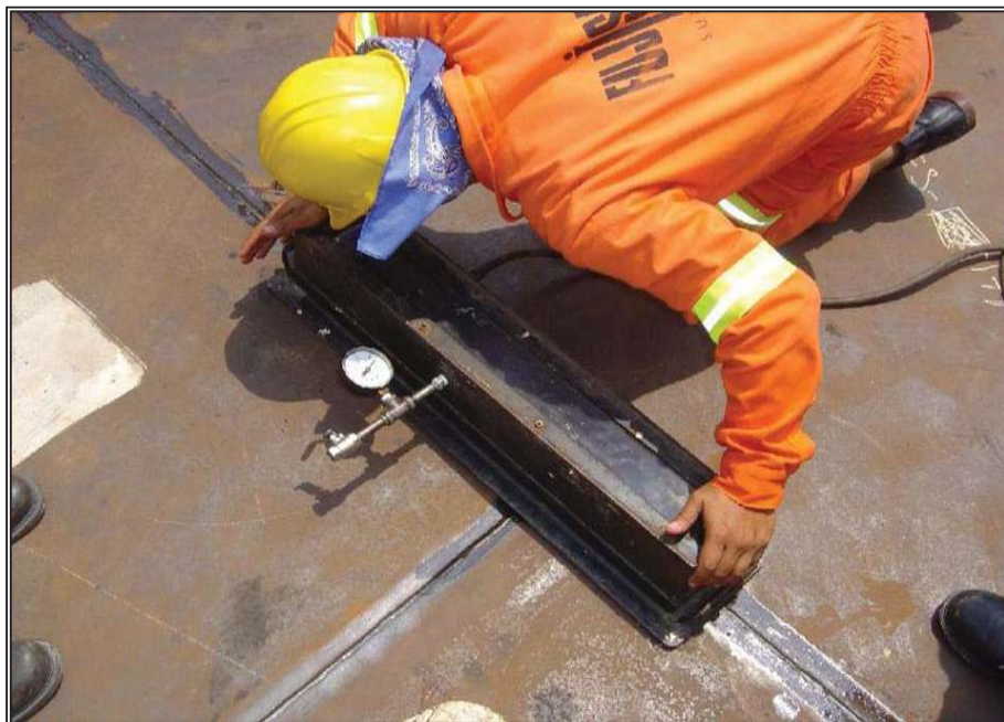
Fig. 5.14.- Prueba con caja de vacíos en soldaduras de placa del fondo.
