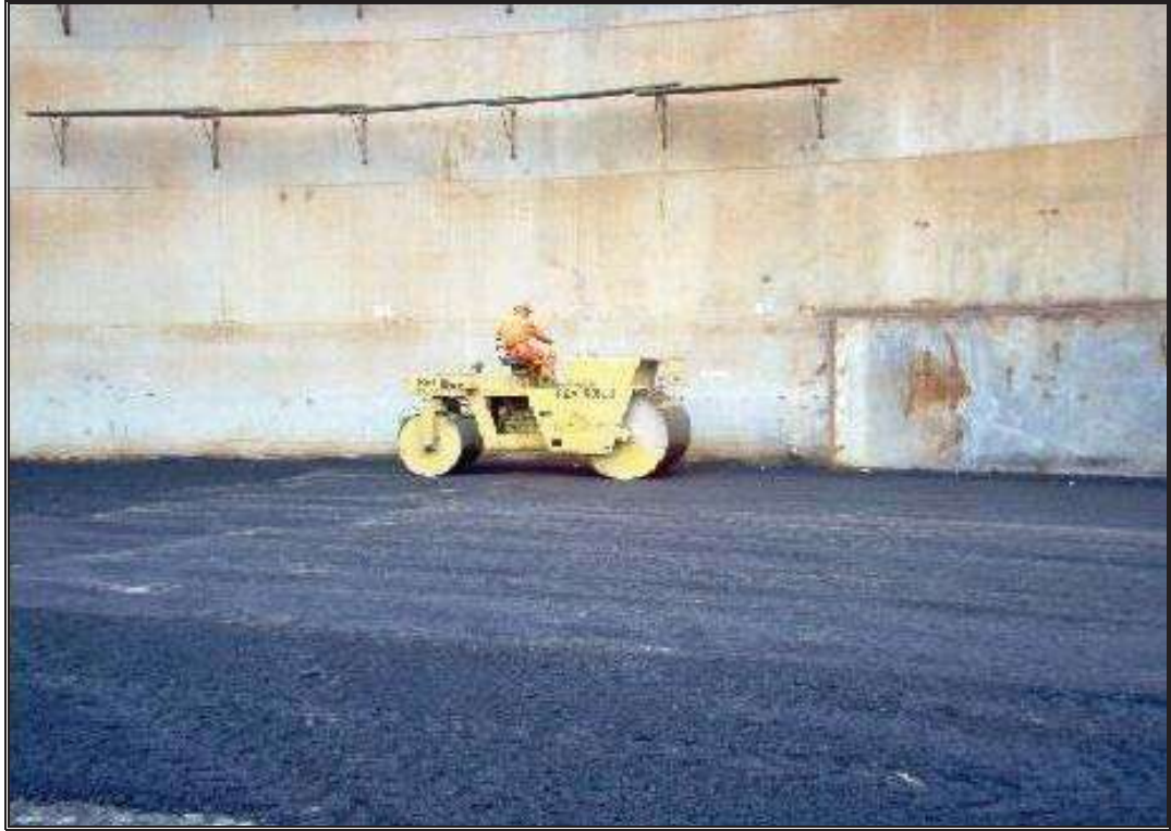
Fig. 4.17.- Compactación de carpeta con compactador tandem.
