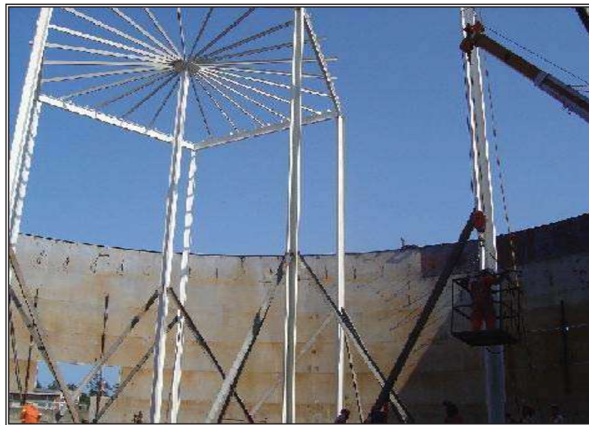
Fig. 7.9.- Colocación y apuntalamiento de columnas
