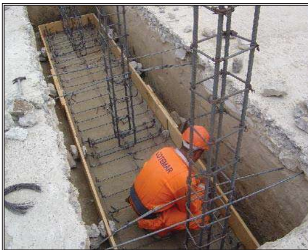
Fig. 8.19.- Colocación de acero de refuerzo y cimbra en zapata.
