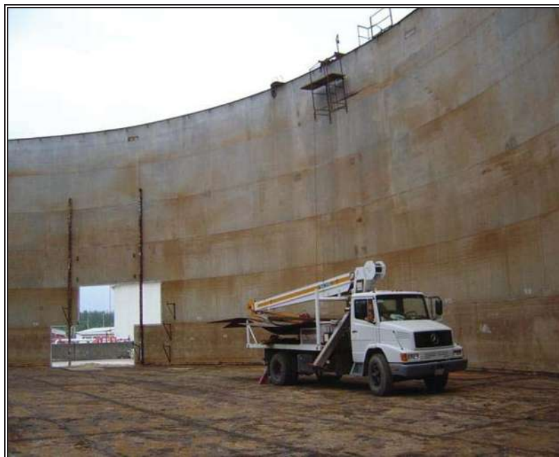
Fig.3.7.- Desmantelamiento y retiro de las placas de fondo.
