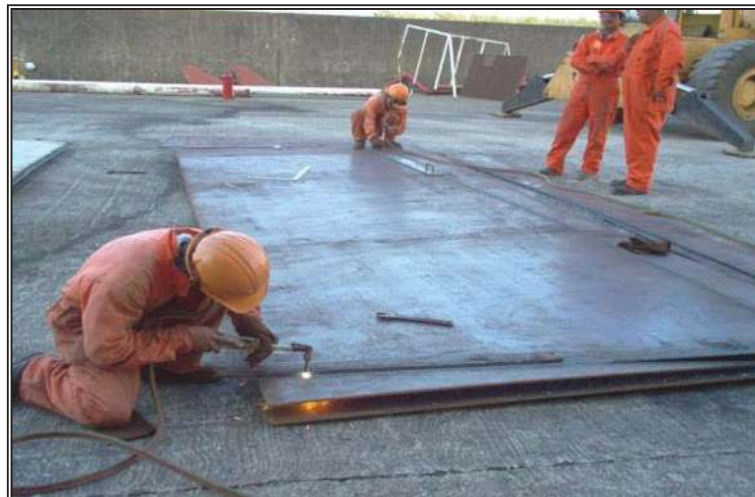
Fig.5.1.- Escuadrado de placas del fondo del tanque.
