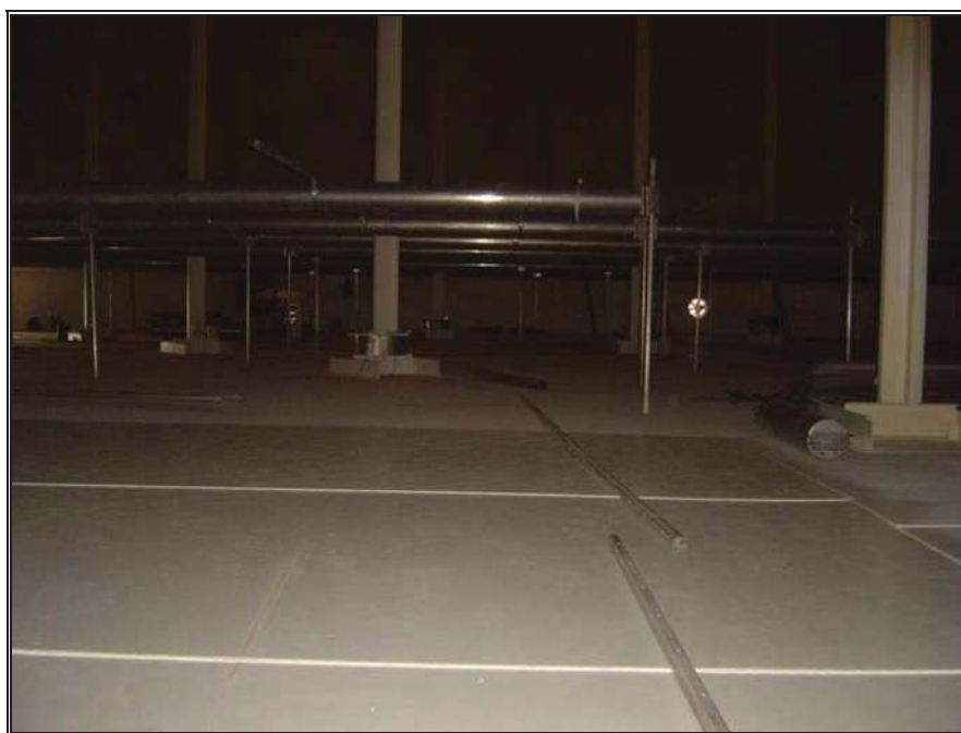
Fig. 8.26.- Colocación de la membrana interna flotante.
