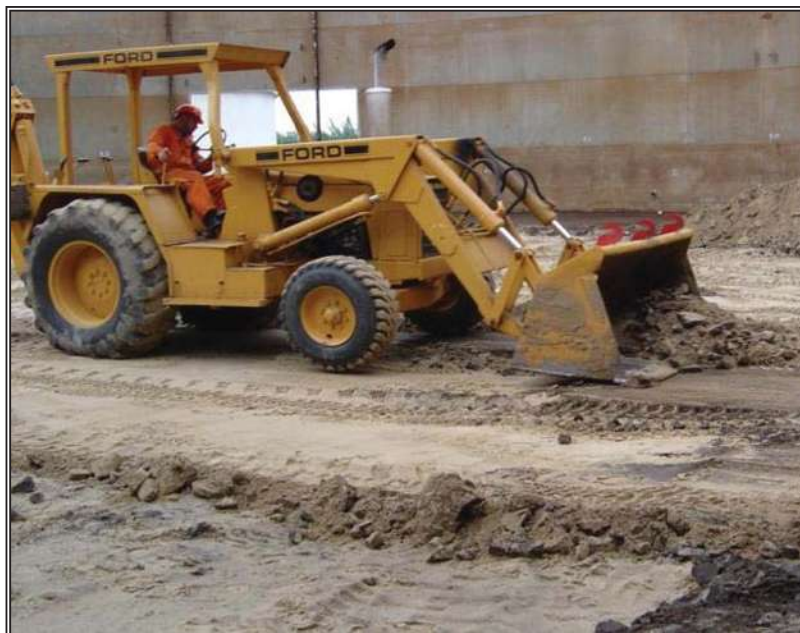
Fig. 4.3.- Retiro de material contaminado del interior del tanque.
