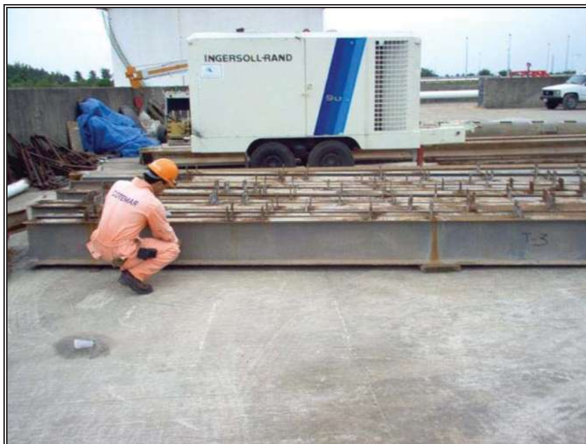
Fig. 7.2.- Sustitución de cartabones en trabes
