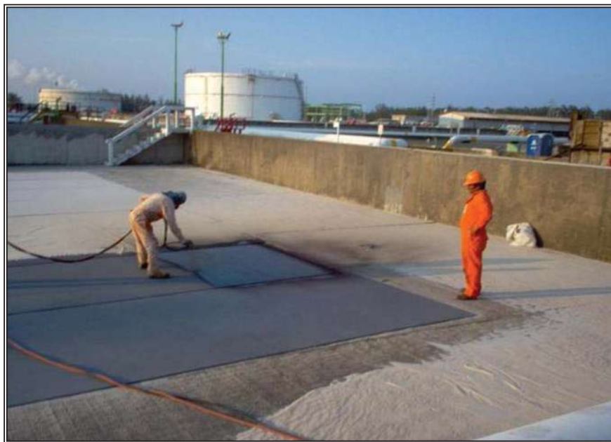
Fig. 5.4.- Aplicación de recubrimiento primario anticorrosivo RP-5.
