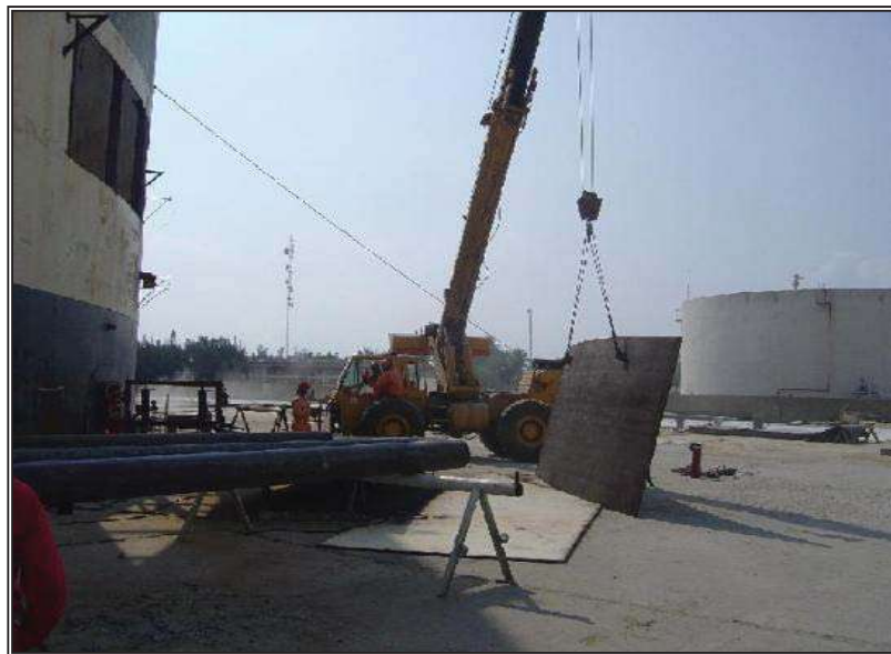
Fig. 6.9.- Maniobras para la colocación de placas.
