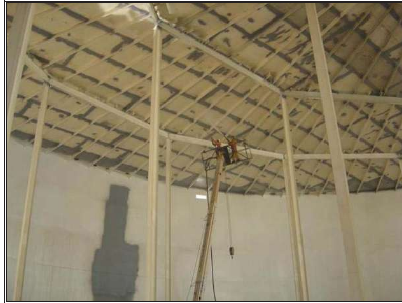
Fig. 7.19.- Retiro de polvo en la superficie de las placas.
