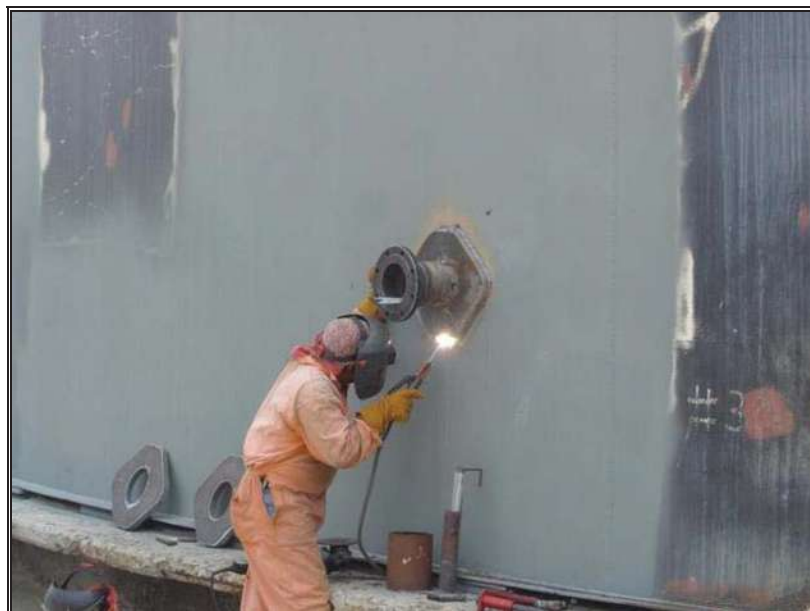
Fig. 8.1.- Soldadura de solapa para boquilla.
