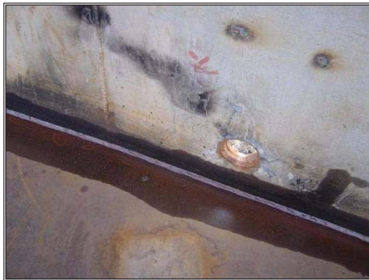
Fig. 6.8.- Aplicación de diesel en soldadura Fondo-Envolvente.
