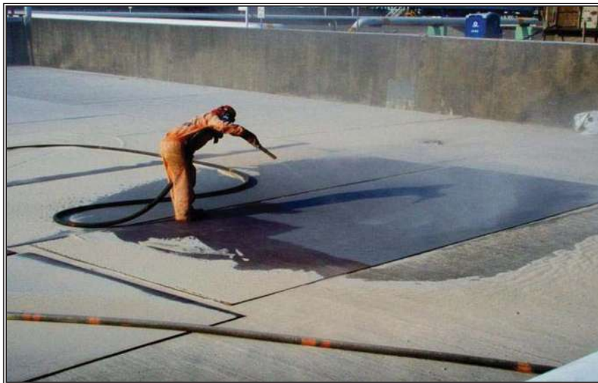
Fig. 5.3.- Limpieza de la placa con equipo de sand-blast.
