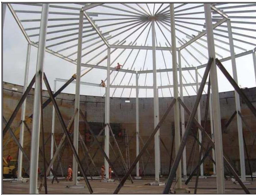
Fig. 7.10.- Colocación de estructura interior del tanque
