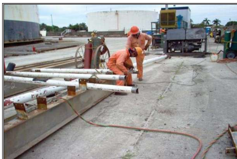
Fig. 3.15.- Corte y biselado en tubería desmantelada.
