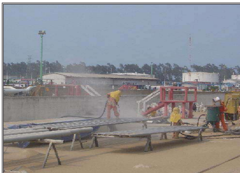
Fig. 7.6.- Limpieza de estructura con equipo de sand-blast.
