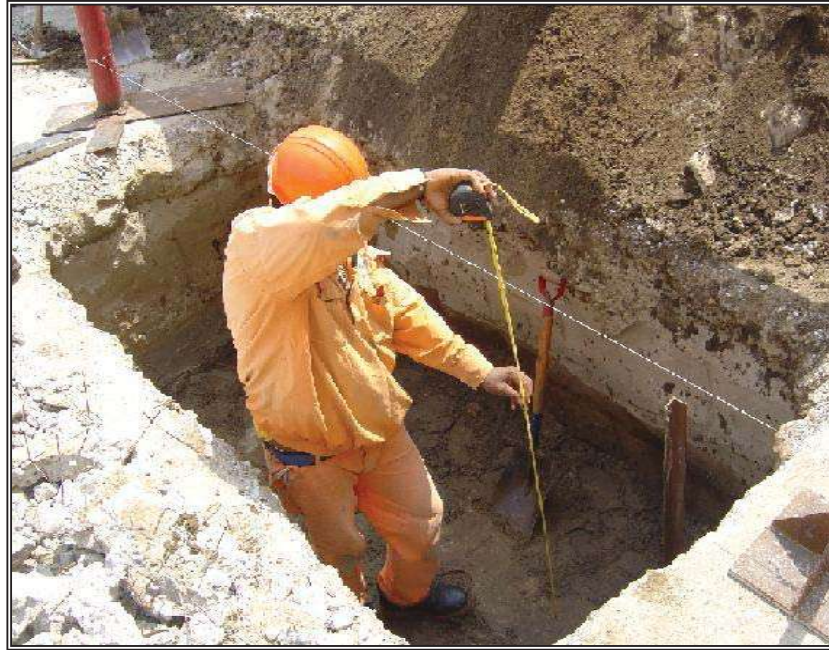
Fig. 8.18.- Afine de terreno con herramienta manual.
