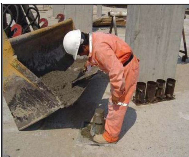
Fig. 8.20.- Toma de muestras de concreto para pruebas de laboratorio.
