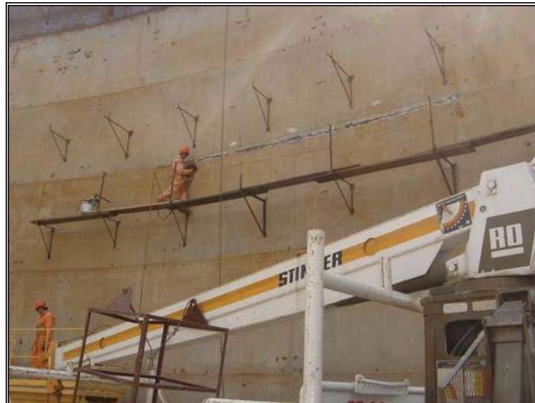
Fig. 3.12- Corte con equipo de oxiacetileno para retiro de placas de la envolvente.
