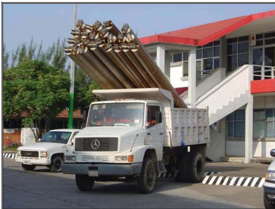
Fig. 3.3.- Retiro de pontones de la membrana interna flotante.
