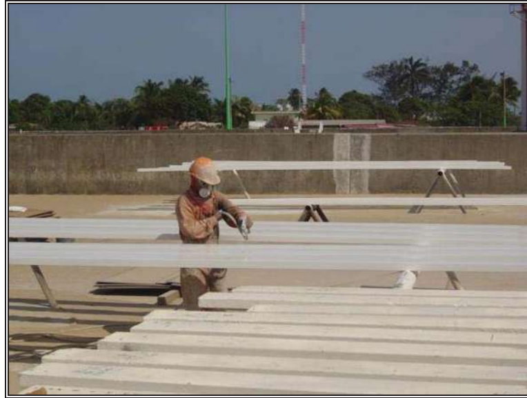
Fig. 7.7.- Aplicación de pintura en estructura
