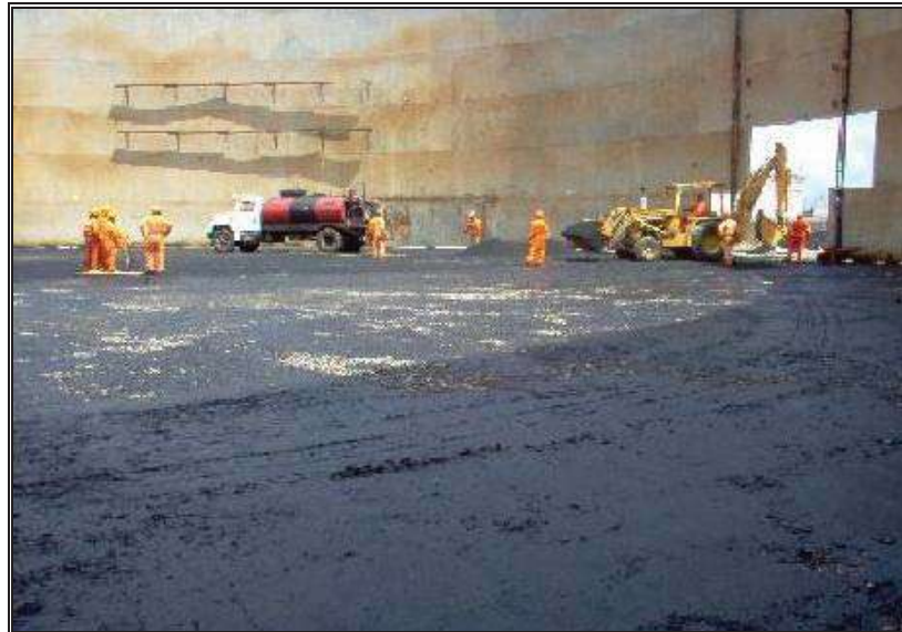
Fig. 4.15.- Riego de impregnación con petrolizadora
