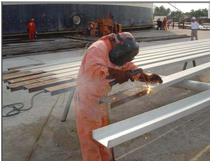
Fig. 7.1.- Rehabilitación de canales
