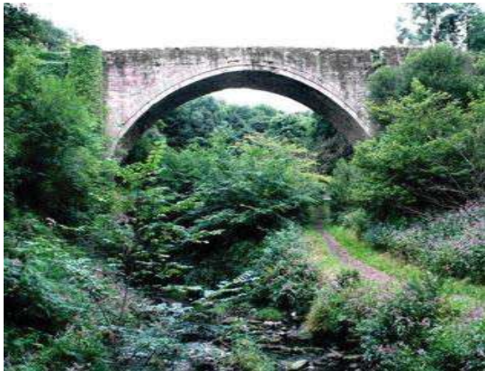
(a) Puente en Arco
