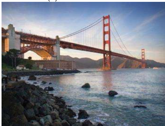
(c) Puente Colgante
