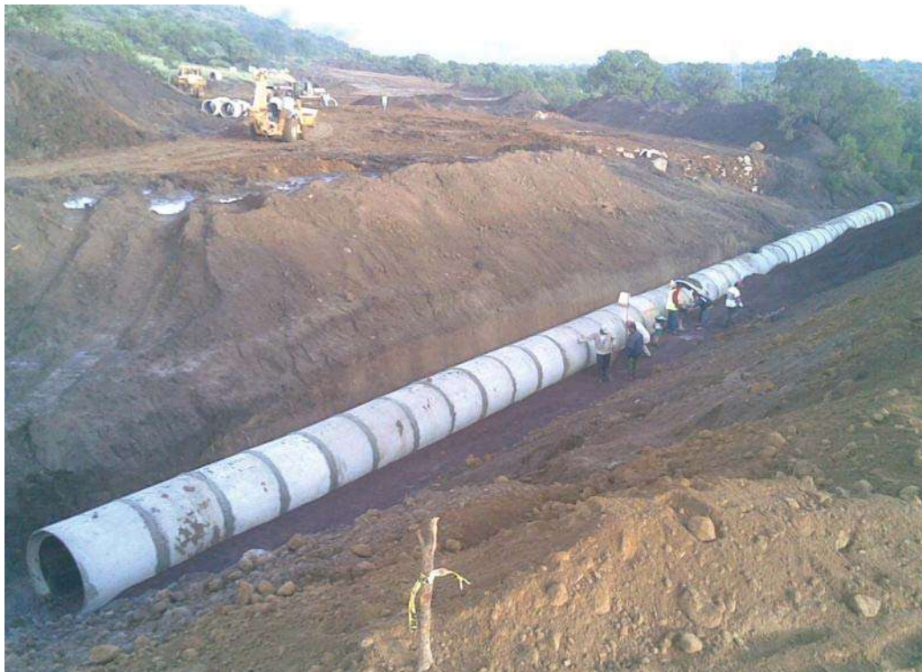
CONSTRUCCION DE OBRA DE DRENAJE CON TUBO DE CONCRETO.
