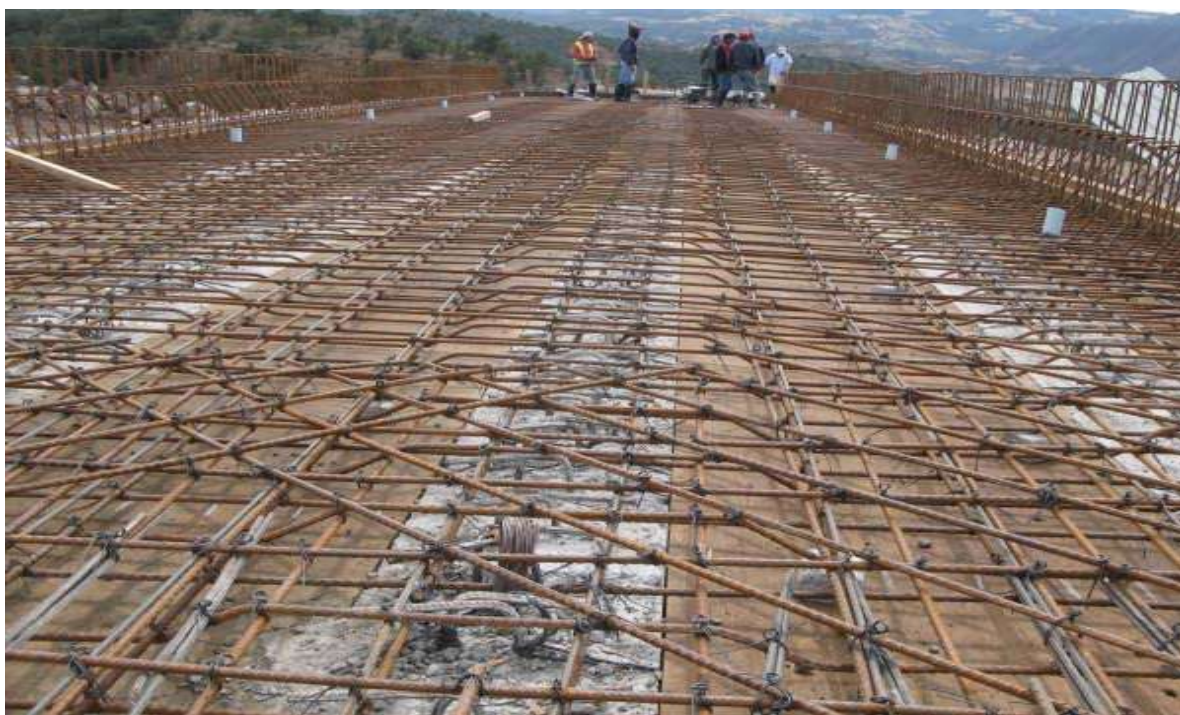
ARMADO DE LOSA Y PARAPETOS DE PIV.
