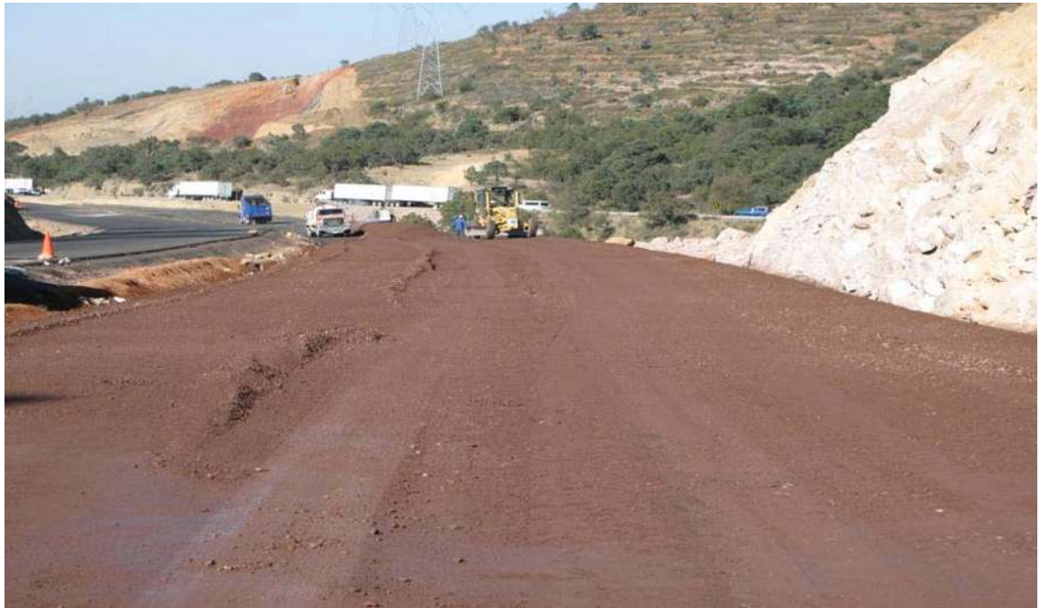
FORMACION DE CAPA SUBRRASANTE CO MOTOCONFORMADORA.
