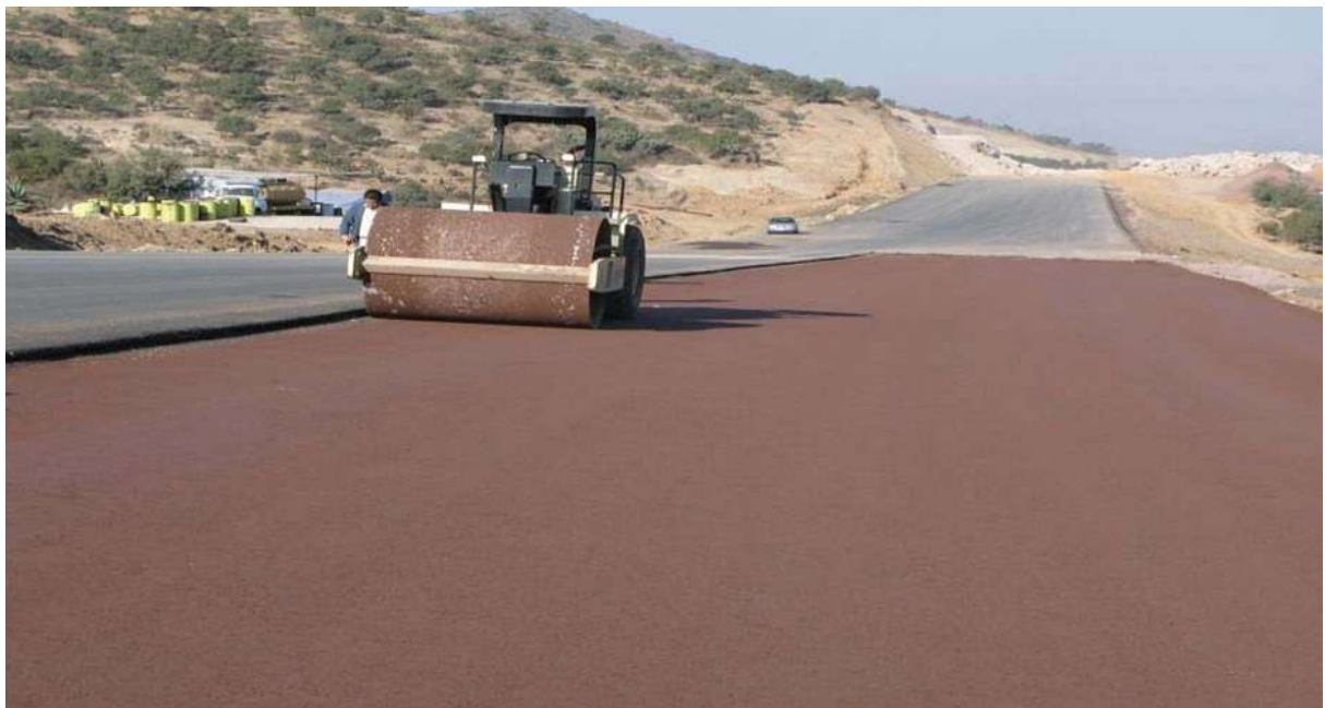
COMPACTACION CAPA BASE.
