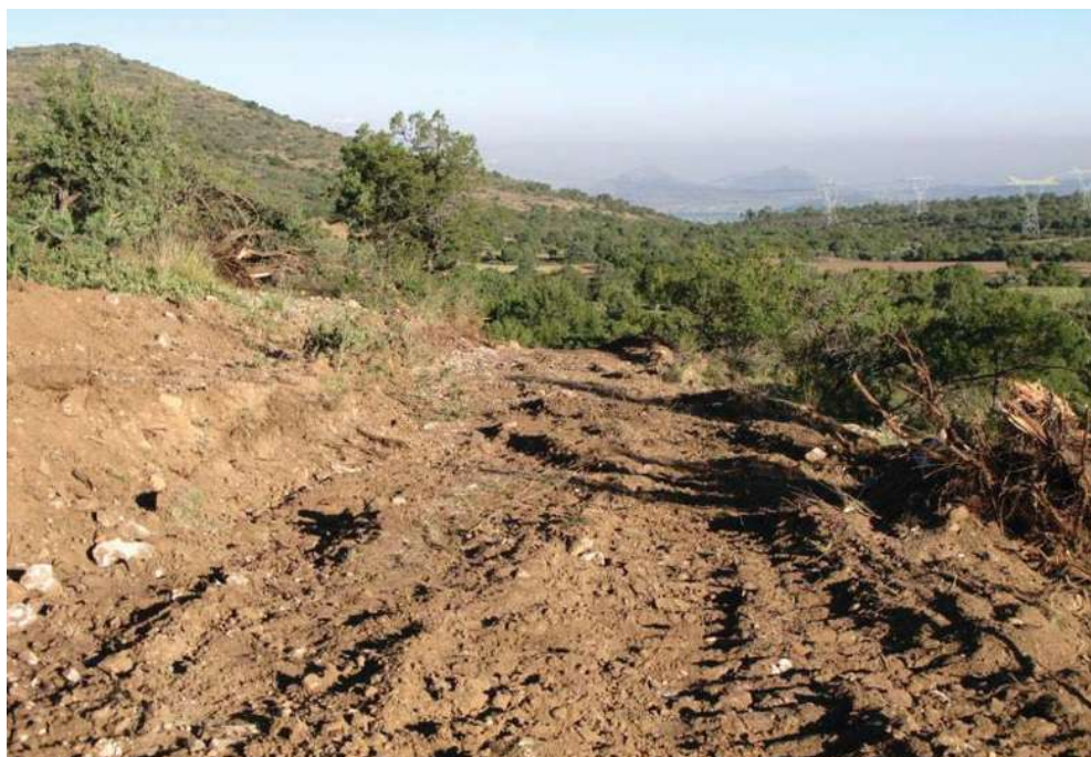
DESMONTE CON TRACTOR BULLDOZER D8-R
