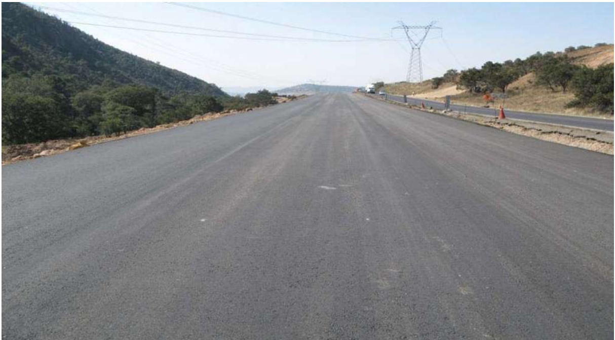
CARPETA DE CONCRETO ASFALTICO.
