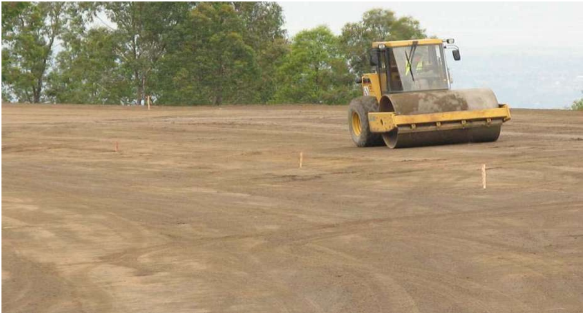
COMPACTACION DE SUBRRASANTE CON COMPACTADOR VIBRATORIO.
