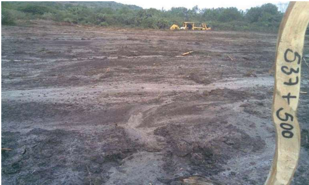
DESPALME CON TRACTOR BULLDOZER D8-R
