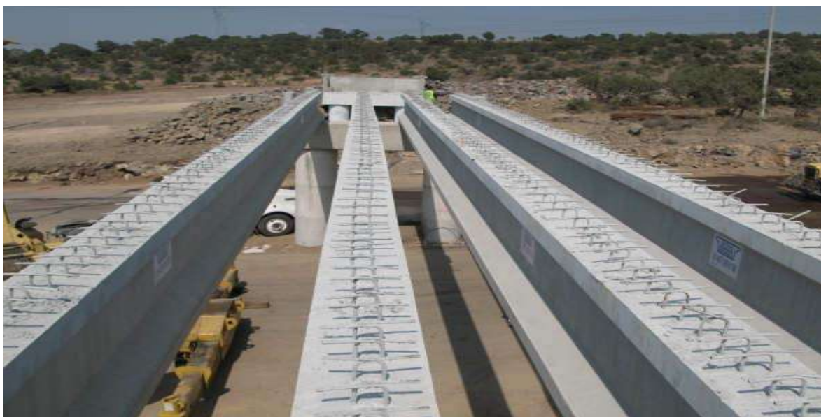
TRABES PRESFORZADAS MONTADAS.
