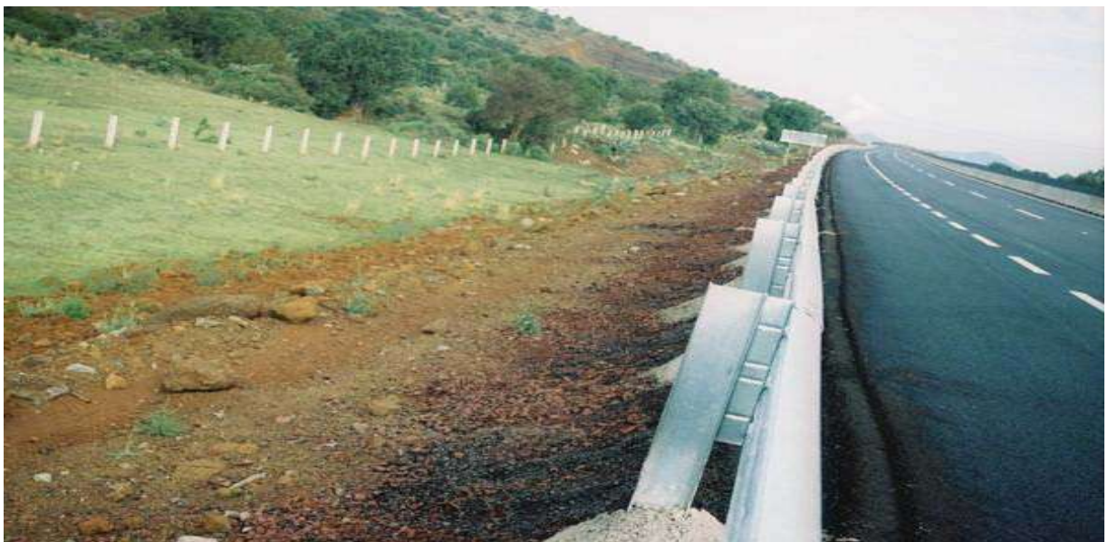
DEFENSA METALICA COLOCADA.
