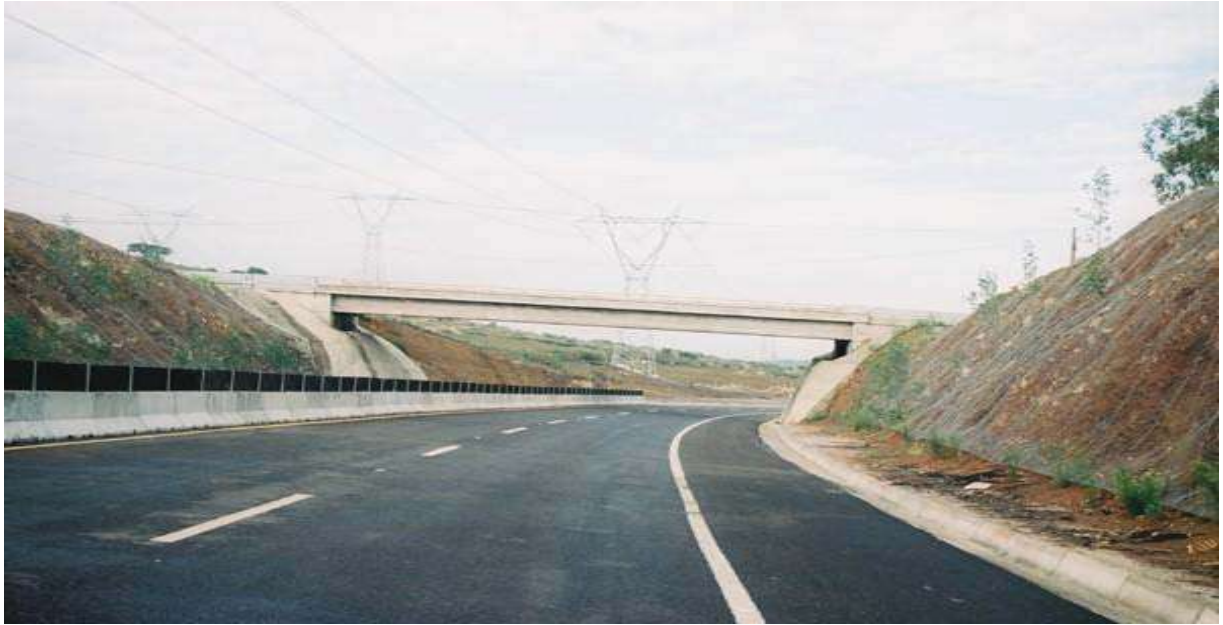
PINTADO DE RAYA CON PINTURA SOBRE PAVIMENTO ASFALTICO
