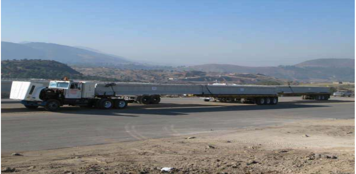
TRANSPORTACION DE TRABES PRESFORZADAS.
