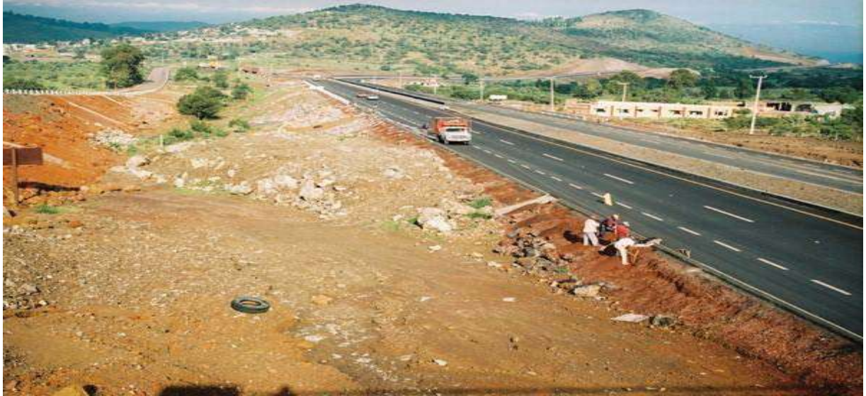
COLOCACION DE DEFENSA METALICA.
