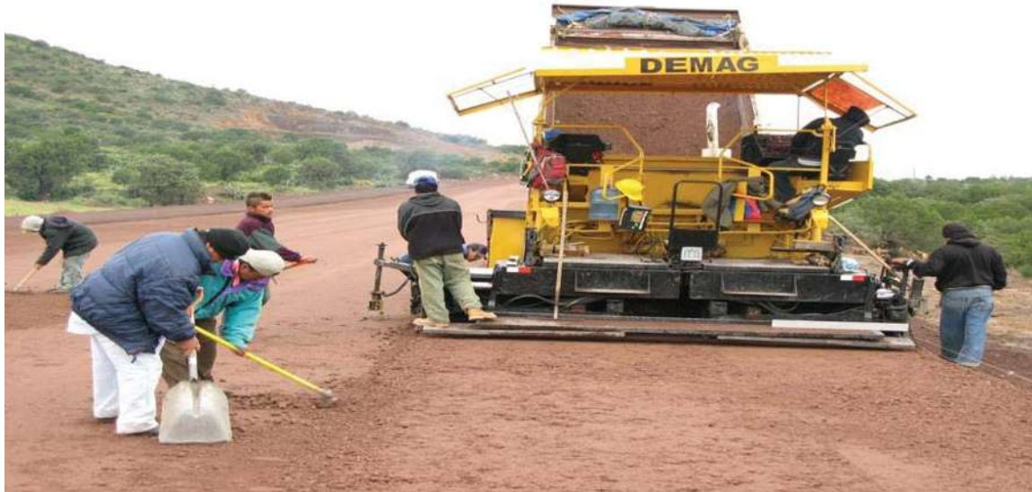
TENDIDO CAPA SUB-BASE
