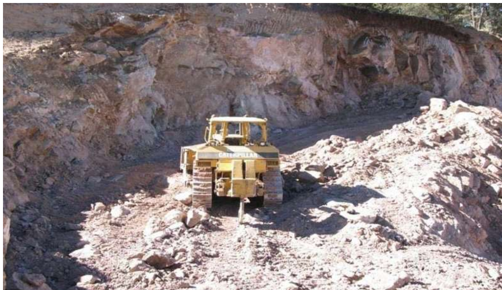
EXCAVACION DE CORTE EN BALCON CON TRACTOR BULLDOZER D8-R
