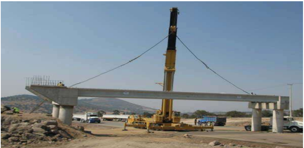
MONTAJE DE TRABES PRESFORZADAS.
