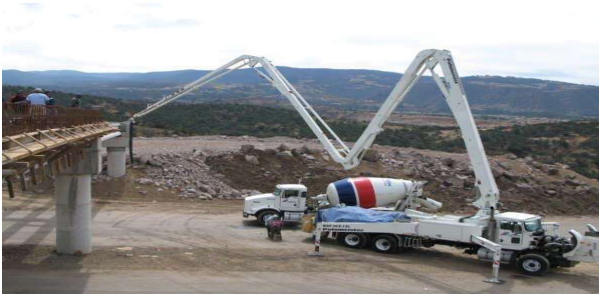
COLADO DE LOSA DE CONCRETO DE PIV.
