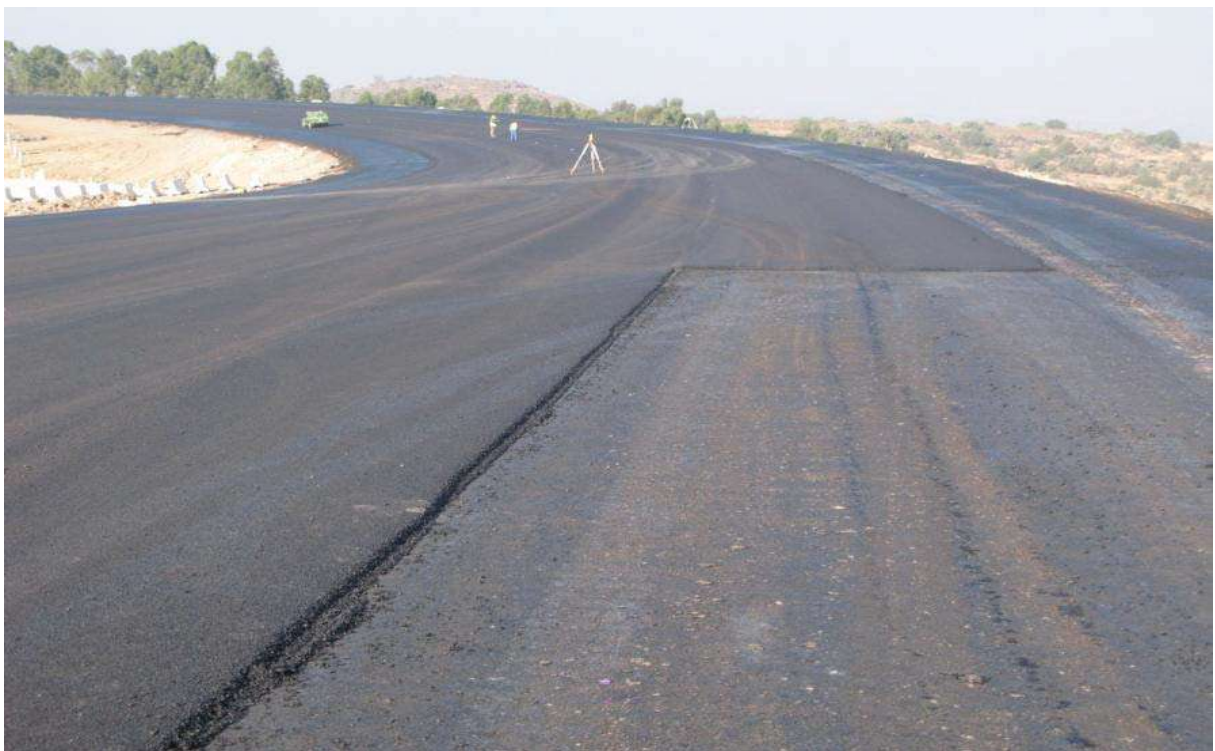
TENDIDO DE OPEN GRADE.
