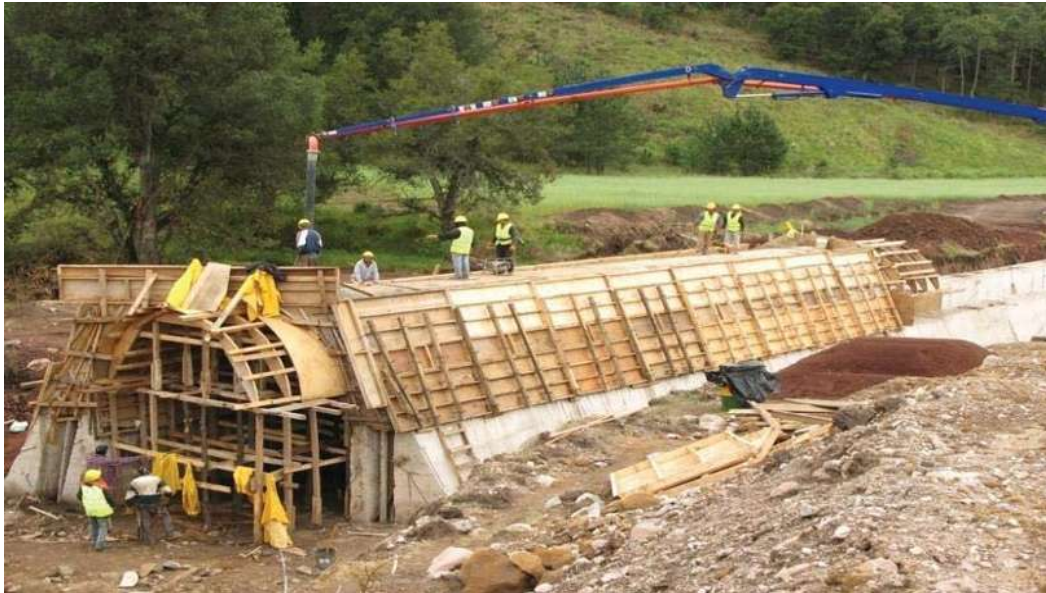
CONSTRUCCION DE BOVEDA DE CONCRETO.
