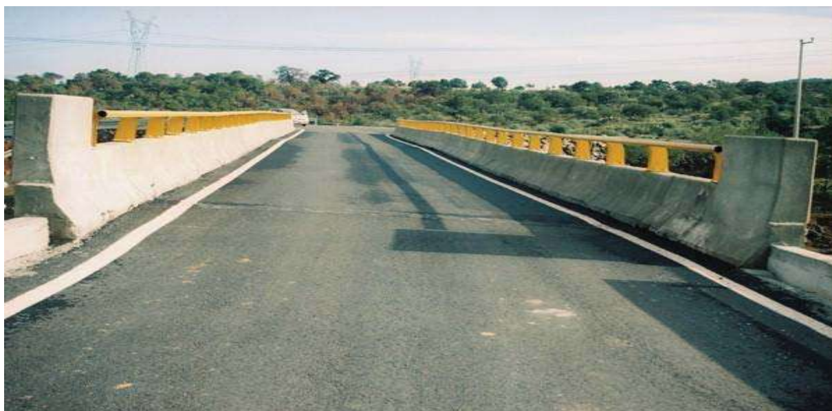
PIV TERMINADO CON CARPETA ASFALTICA SOBRE LOSA Y PARAPETOS DE ACERO.
