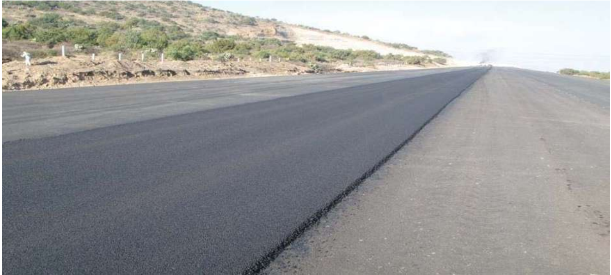
TENDIDO DE OPEN GRADE.
