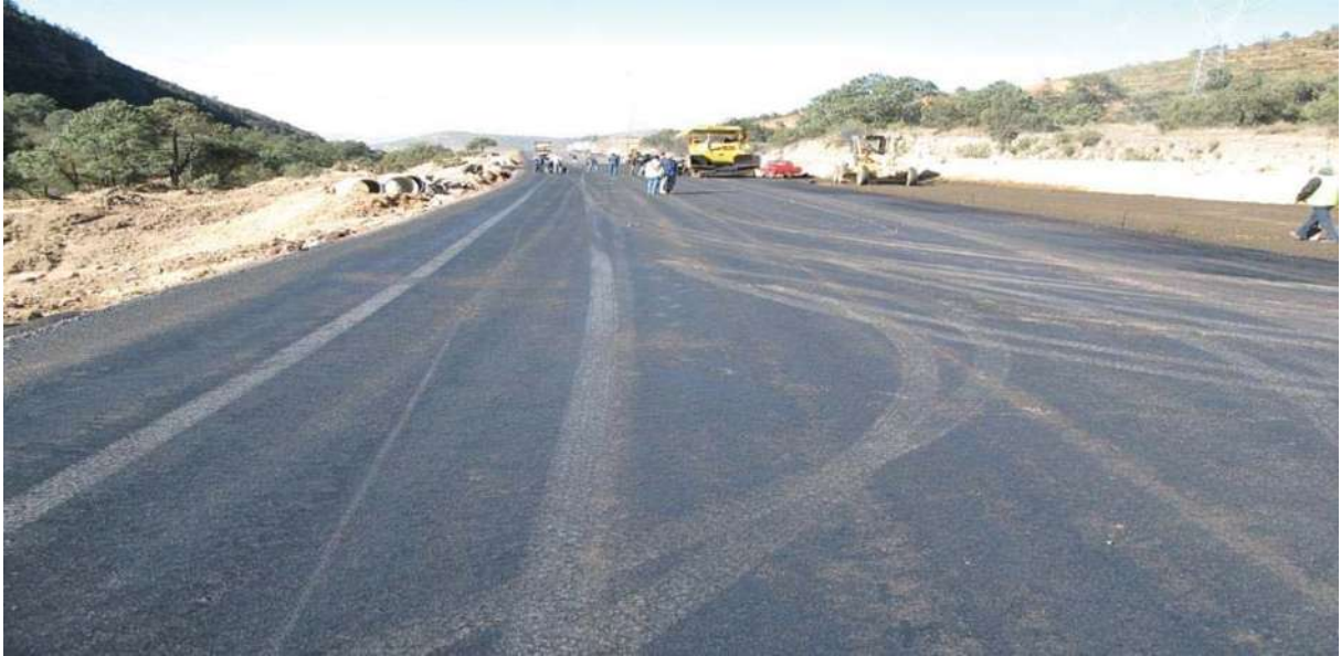
TENDIDO DE CARPETA DE CONCRETO ASFALTICO.
