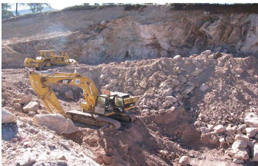
EXCAVACION DE CORTE EN CAJON CON TRACTOR BULLDOZER D8-R
