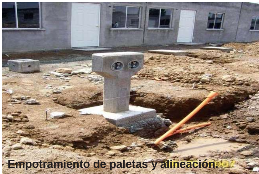
Base piramidal de concreto simple F-c 200 kg/cm 2 , para montaje de poste metálico y registro de baja tensión prefabricado de 35*35*40 cms. Con marco y contramarco metálico de fierro negro de acuerdo a las normas de la C.F.E.
