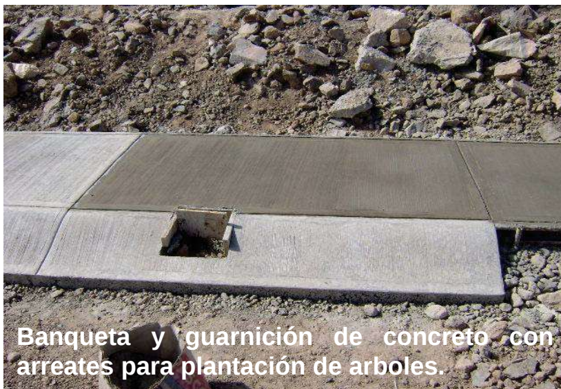
Cimbra de banqueta y colado en el lugar con f'_{c} = 150 \text{ kg/cm}^2
