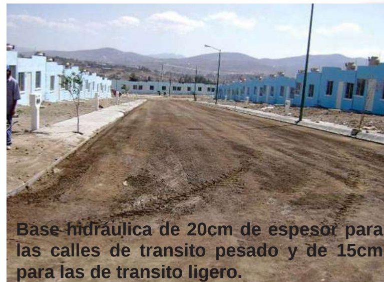
Conformación y compactación de la capa sub-rasante en la construcción de las vialidades.
