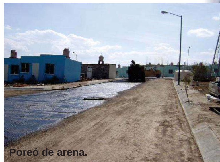
Base hidráulica de 20cm de espesor para las calles de tránsito pesado y de 15cm para las de tránsito ligero.
