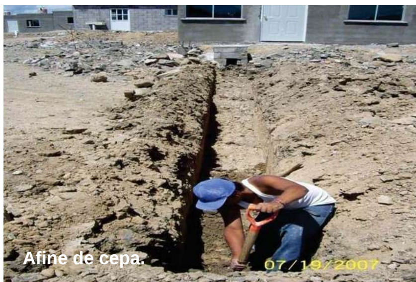
Excavación de cepas con retroexcavadora de 70 cm. ancho y 1.15 m. de altura mínima. 07/19/2007
