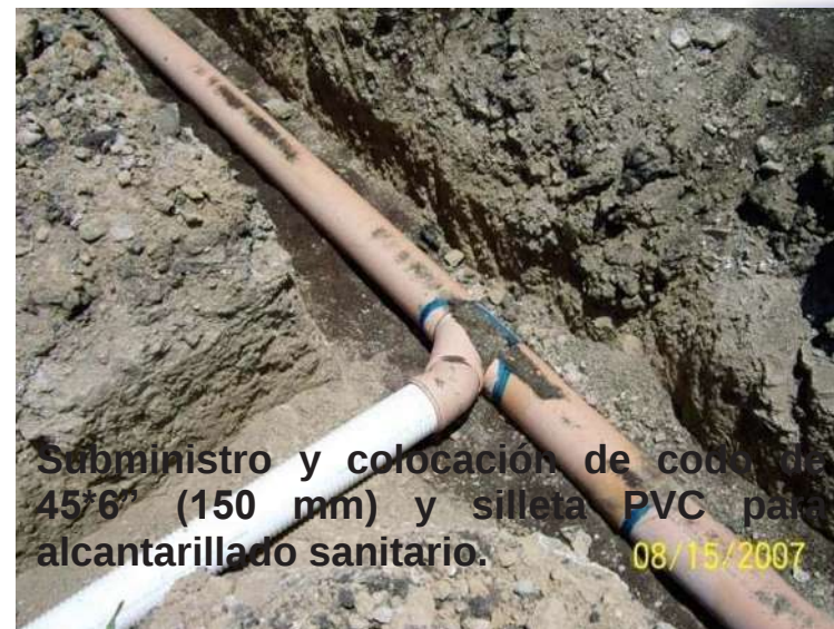
Suministro y instalación de tubería de PVC alcantarillado sanitario serie 25.
