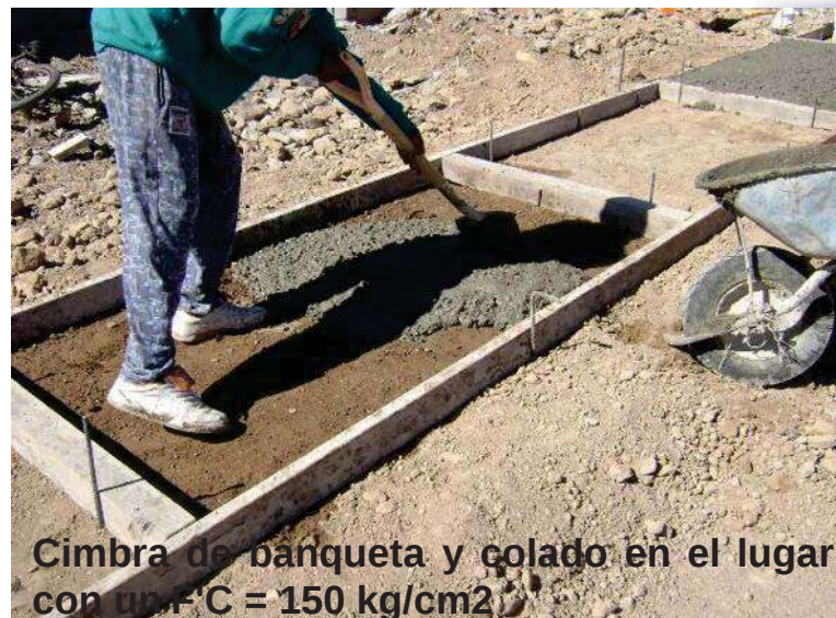
Banqueta y guarnición de concreto con arreates para plantación de arboles.
