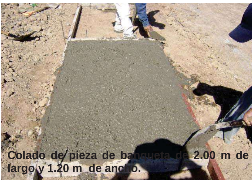
Banqueta y guarnición de concreto con arreates para plantación de arboles.
