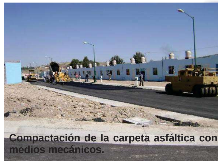
Tendido de carpeta asfáltica de las vialidades del conjunto habitacional.
