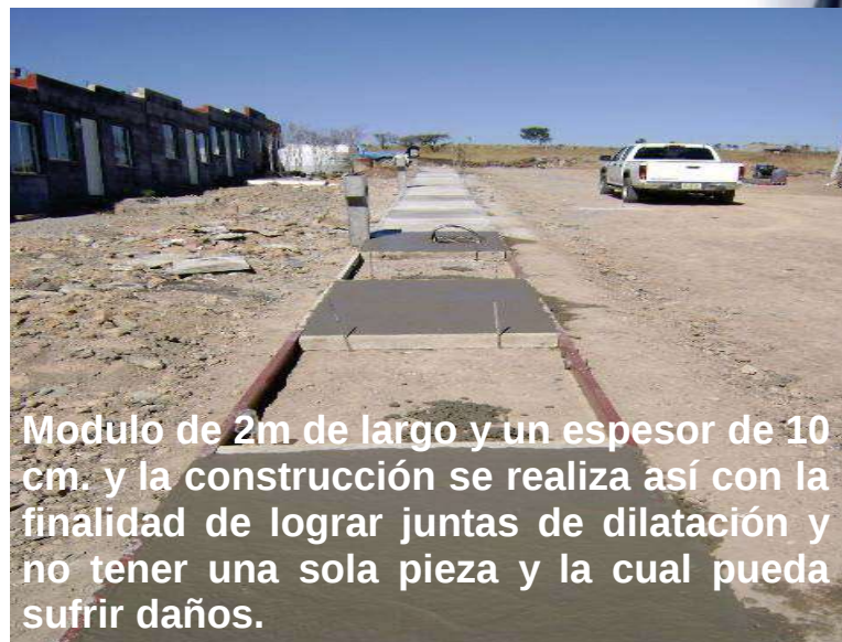
Cimbra de banqueta y colado en el lugar con f'_{c} = 150 \text{ kg/cm}^2
