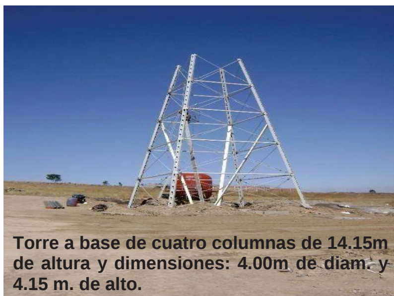
Fabricación de tanque elevado metálico de 30 m 3 de capacidad y 14.15m altura
