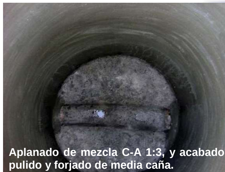
Construcción de pozo de visita común para tubería de 30-61 cm. De diámetro y plantilla de mampostería de piedra brasa.
