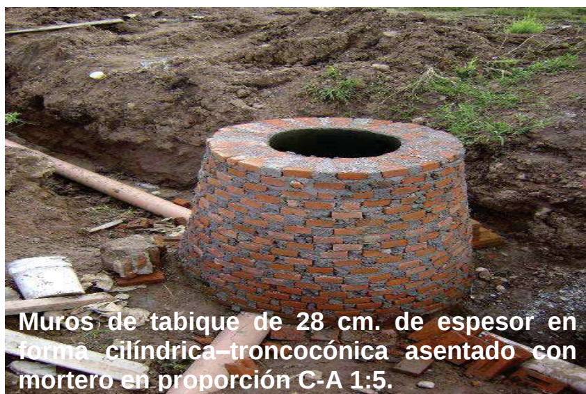
Construcción de pozo de visita común para tubería de 30-61 cm. De diámetro y plantilla de mampostería de piedra brasa.
