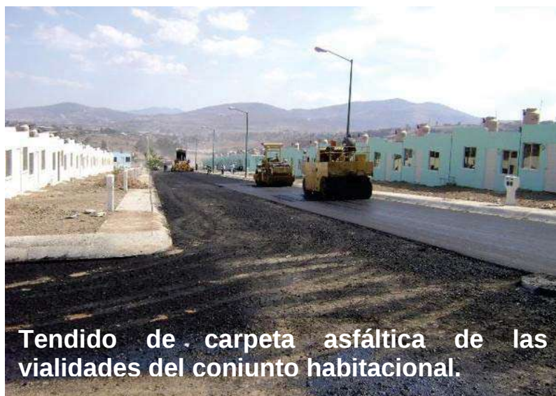
Compactación de la carpeta asfáltica con medios mecánicos.
