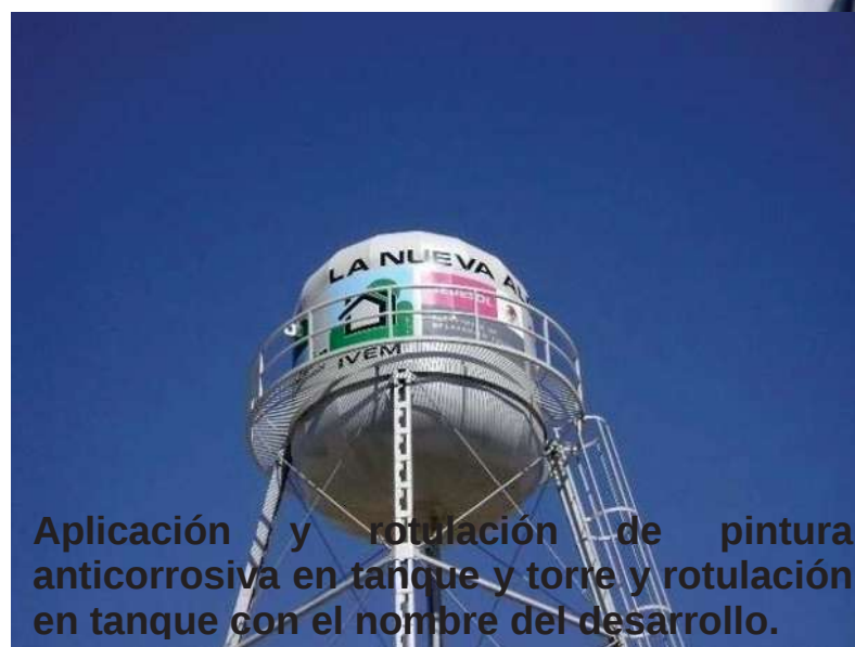
Sistema "pasa - hombre" en la parte superior del tanque con un pasillo circular con pasa manos así como escaleras.
