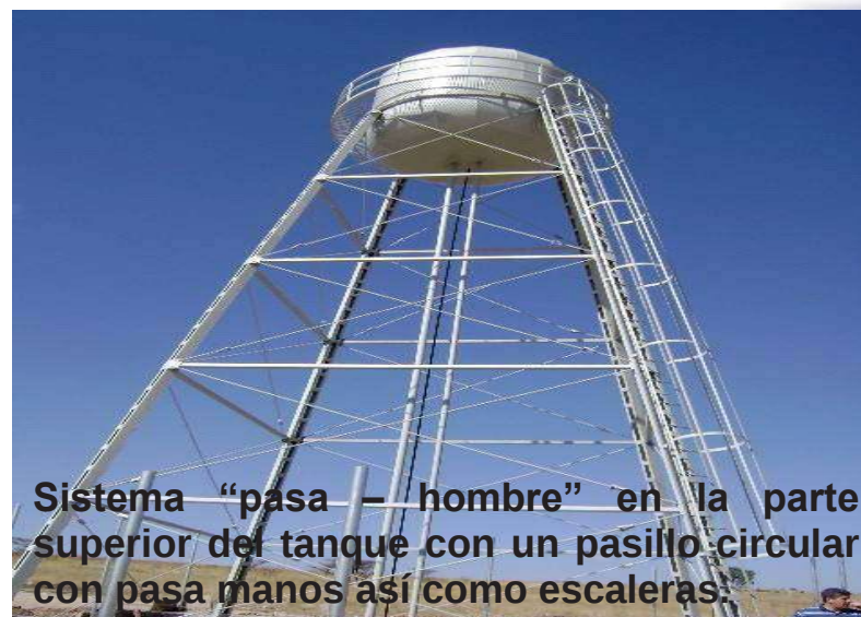
Fabricación de tanque elevado metálico de 30 m 3 de capacidad y 14.15m altura
