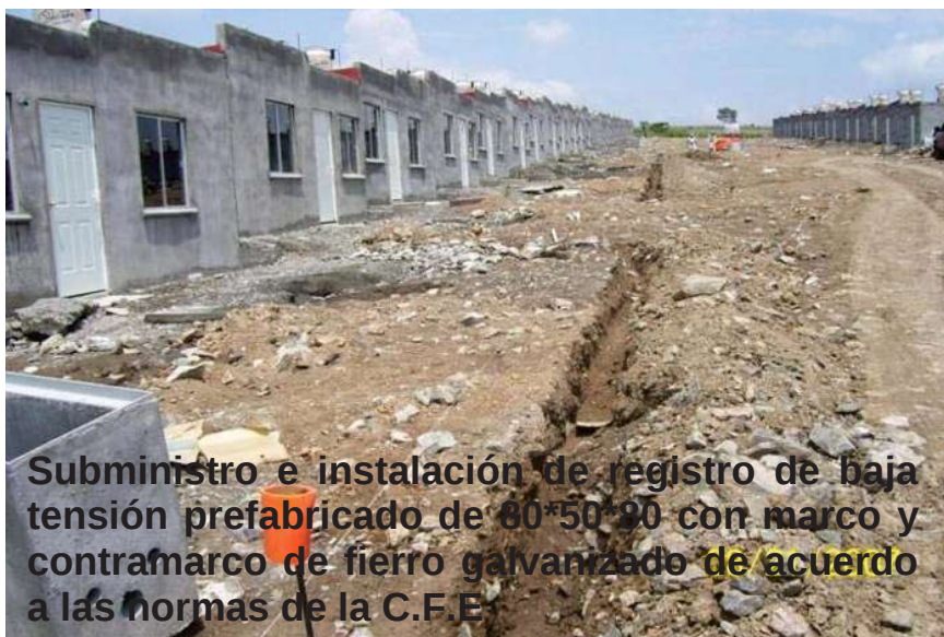
Subministro e instalación de tubo poliducto de altad densidad de 75 mm de diámetro.
