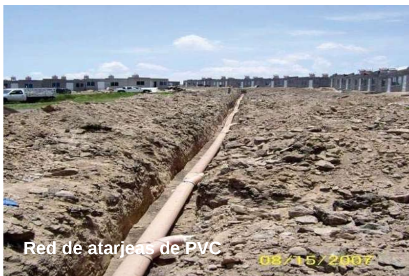
Suministro y instalación de tubería de PVC alcantarillado sanitario serie 25.
