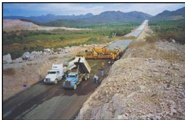
FIGURA 1. Pavimentadora de cimbra deslizante.
