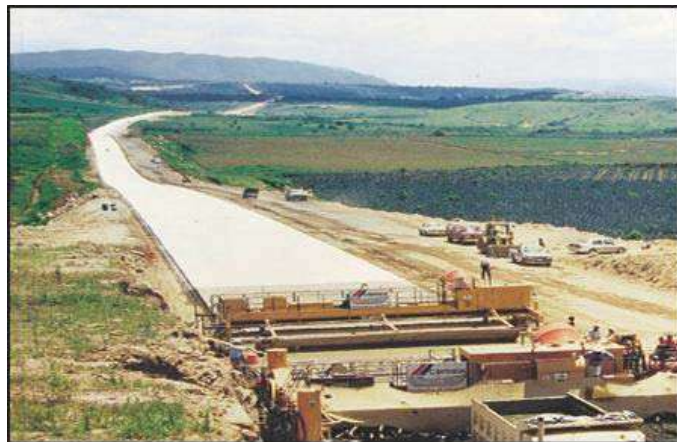
FIGURA 2. Autopista de concreto hidráulico.
