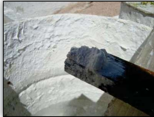
Figura 2.- Cal apagada para utilizarse en morteros.
