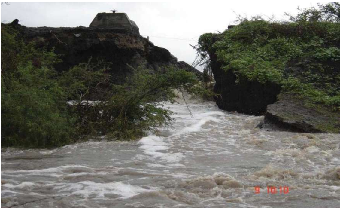
PRESA EL REFUGIO MUNICIPIO DE YURECUARO, MICH.
