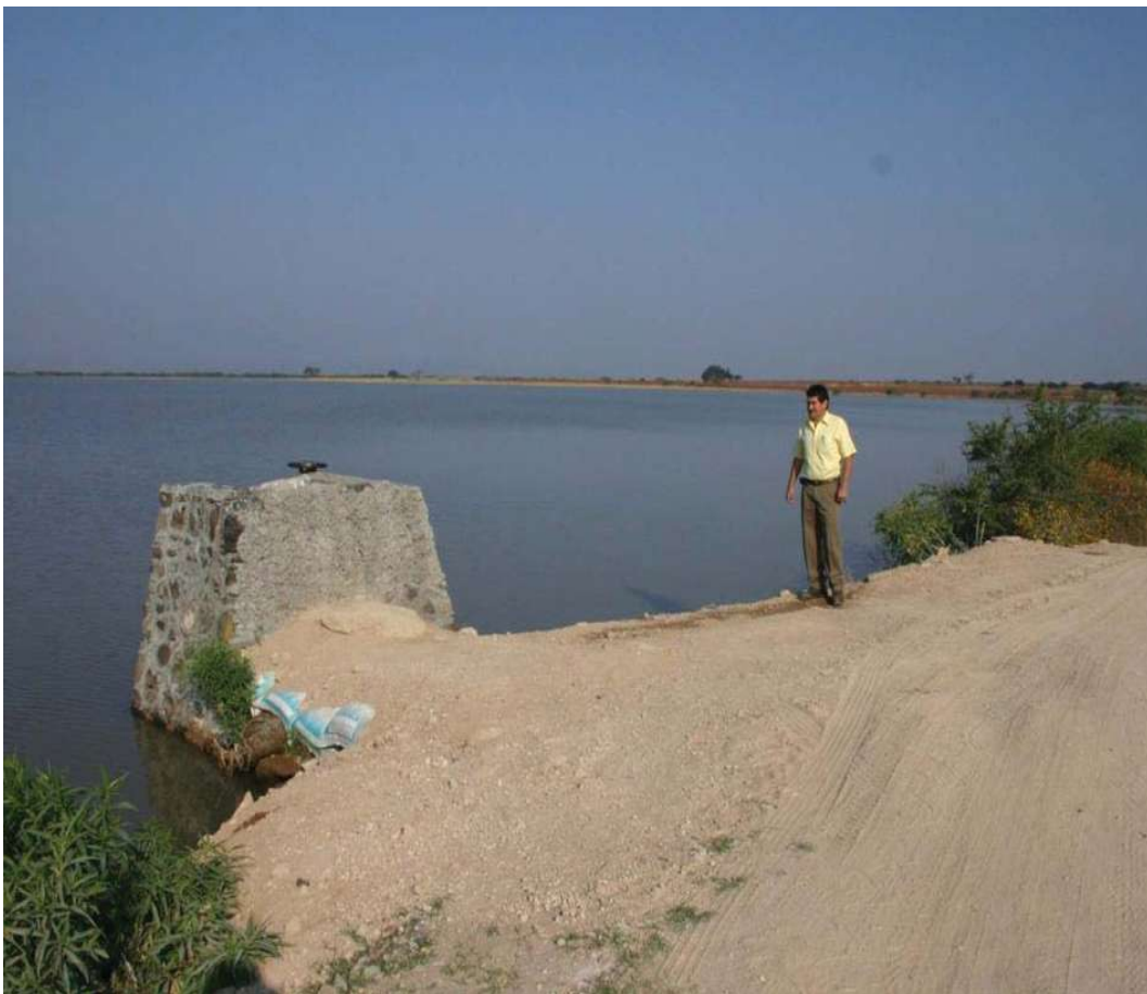
PRESA LA SOTELEÑA
