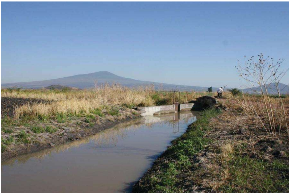
PRESA LA NORIA CANAL PRINCIPAL Km 3 + 340
