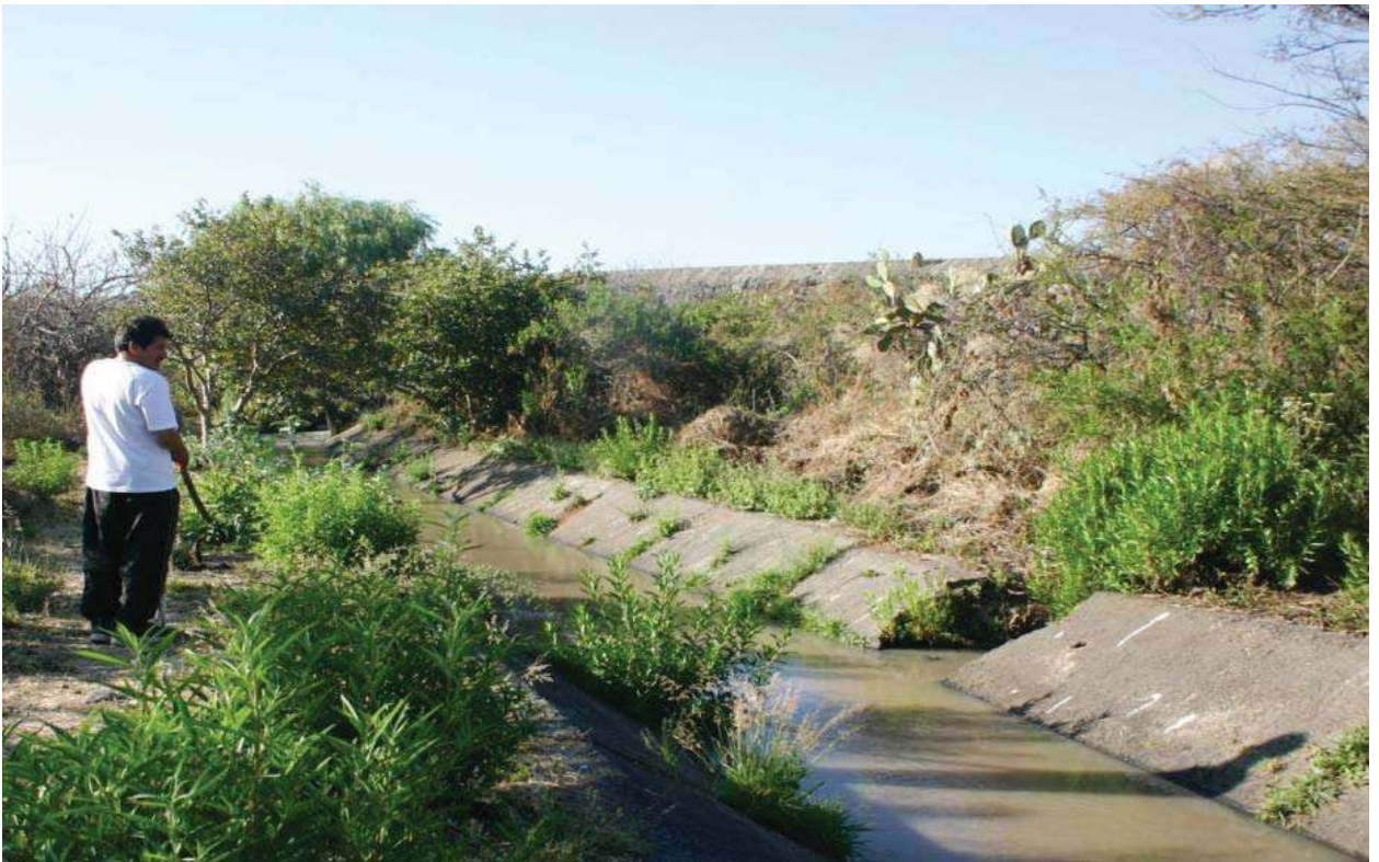
PRESA LA NORIA CANAL PRINCIPAL Km 0 + 060
