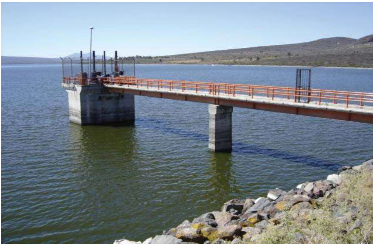
PRESA MELCHOR OCAMPO MUNICIPIO DE ANGAMACUTIRO
