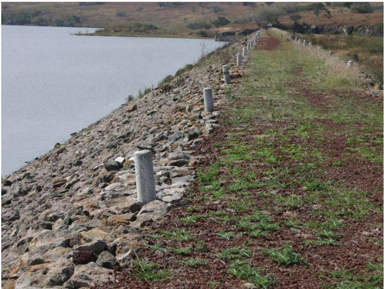
PRESA PUERTA DE VARGAS
