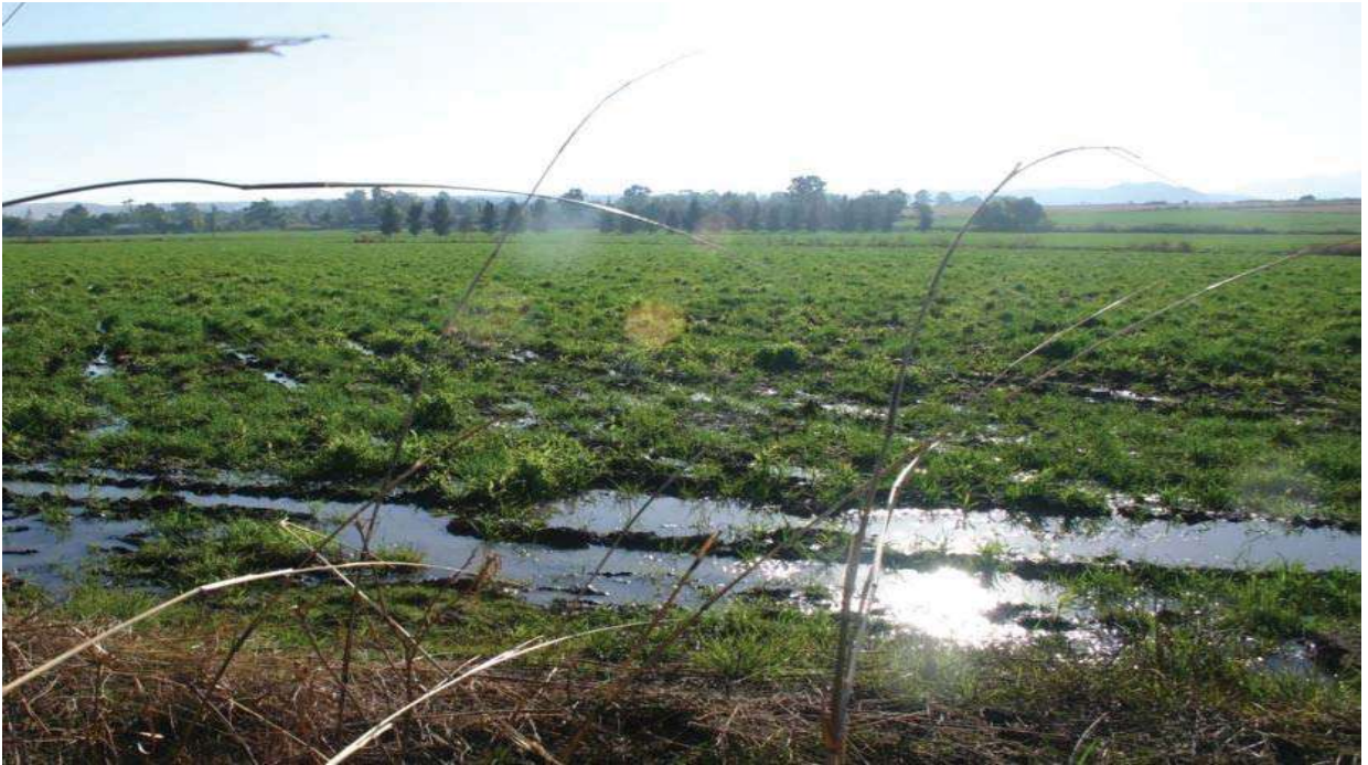
CANAL PRINCIPAL PRESA LA NORIA MARGEN DERECHA KM 0+100
