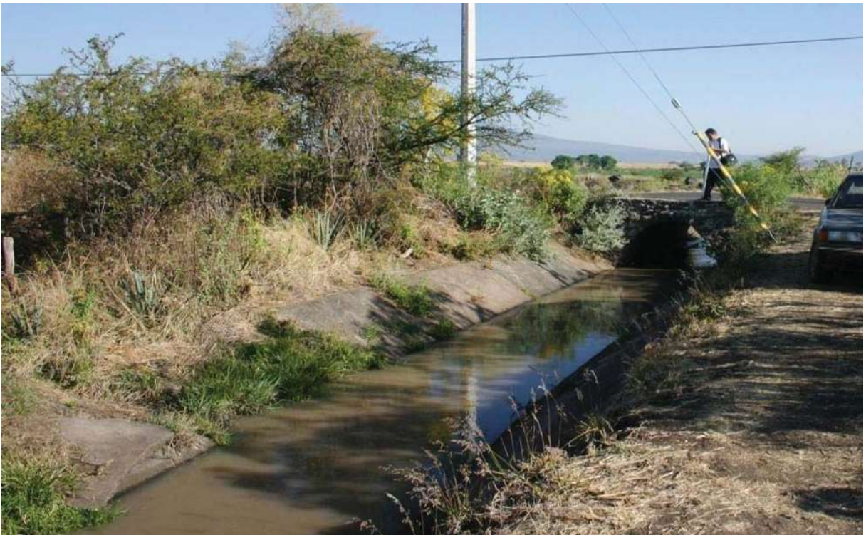
PRESA LA NORIA CANAL PRINCIPAL Km 0 + 260
