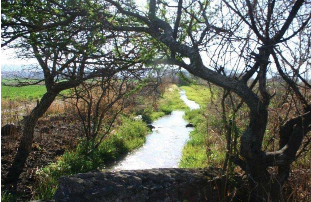
PRESA LA NORIA CANAL PRINCIPAL Km 2 + 380
