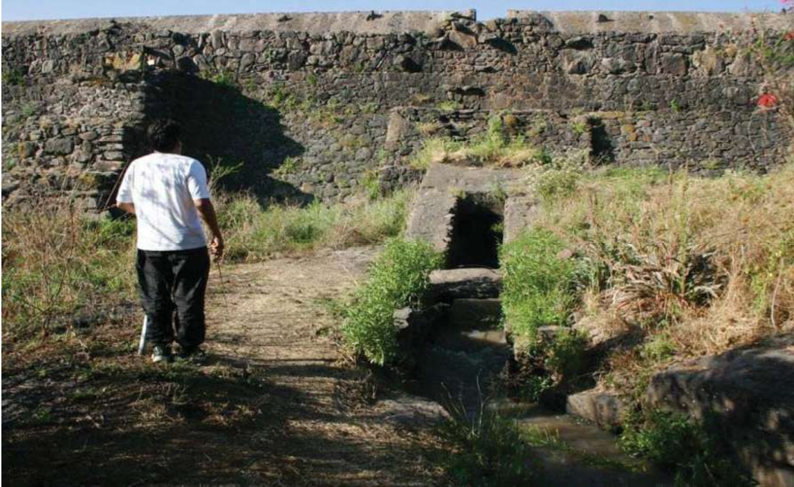
PRESA LA NORIA OBRA DE TOMA
