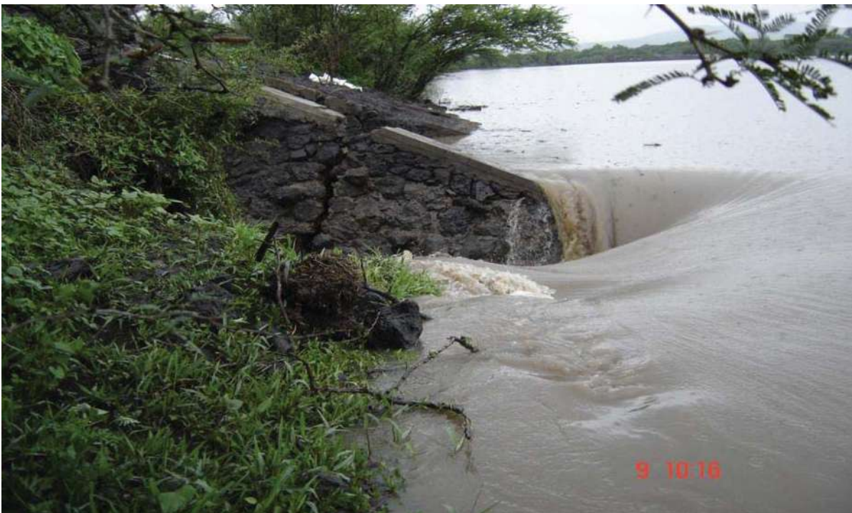
PRESA EL REFUGIO MUNICIPIO DE YURECUARO, MICH.
