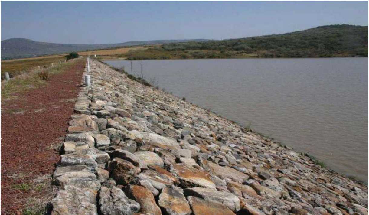
PRESA PUERTA DE VARGAS
