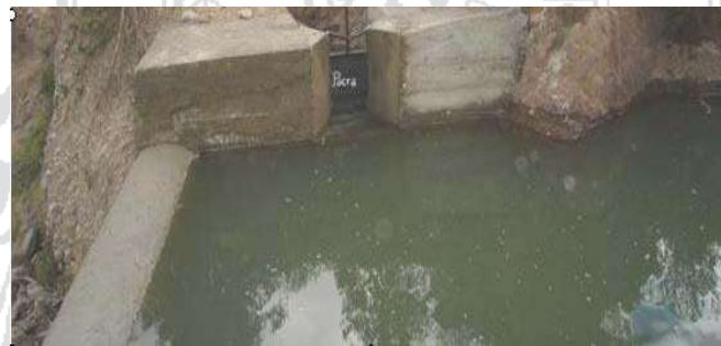
Figura: 2.3.1.4.- presa de almacenamiento.
